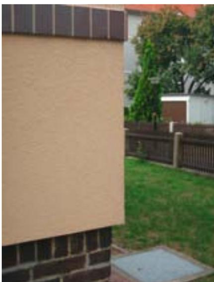
Abb. 38 Fassade, WDVS mit nachgebildetem Simsband aus aufgeklebten Klinkerplatten (schwieriger Kompromiss)
