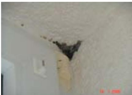
Abb. 13 Detail, Schimmel in einer Außenwanddecke nach Sanierung
