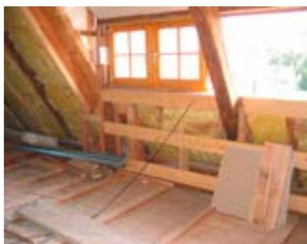
Abb. 8 Ausbau Dachgeschoss, Zwischensparrendämmung aus Glaswolle
