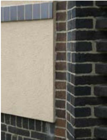
Abb. 37 Fassade, Dämmputz mit nachgebildetem Simsband aus aufgeklebten Klinkerplatten (schwieriger Kompromiss)
