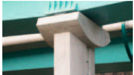
Brückenpfeiler aus Beton
