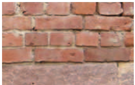
Mauerziegel aus Lehm, mit Kalk-Sand-Mörtel versetzt
