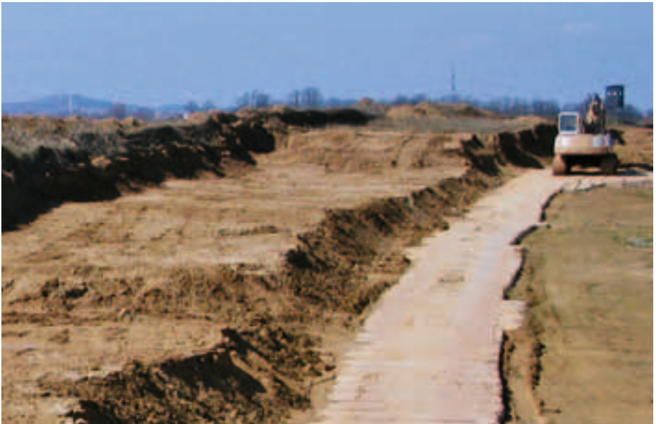
Lehmabbau unter geringmächtigem Mutterboden
