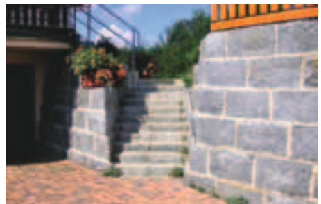
Mauerwerk und Treppenstufen aus Granit
