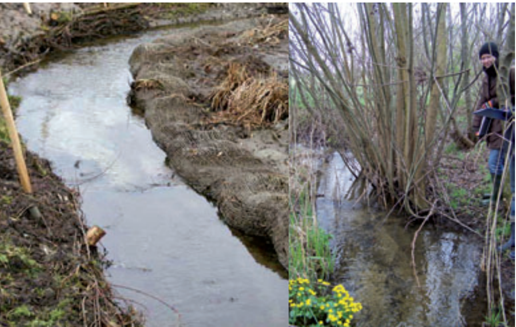
Abb. 6: Vegetationswalzen und Lebendfaschinen zur Initiierung einer standortgerechten Vegetationsentwicklung, (a) Zustand unmittelbar nach Baufertigstellung (Blick in Fließrichtung, Dezember 2000) und (b) acht Jahre später (Blick gegen die Fließrichtung) Fotos: A. Stowasser
