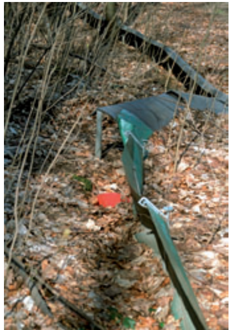
Abb. 3: Ergänzung der ACO-PRO®-Leiteinrichtung durch provisorischen Krötenzaun an der B 180 zwischen Flöha und Erdmannsdorf Foto: V. Kuschka
