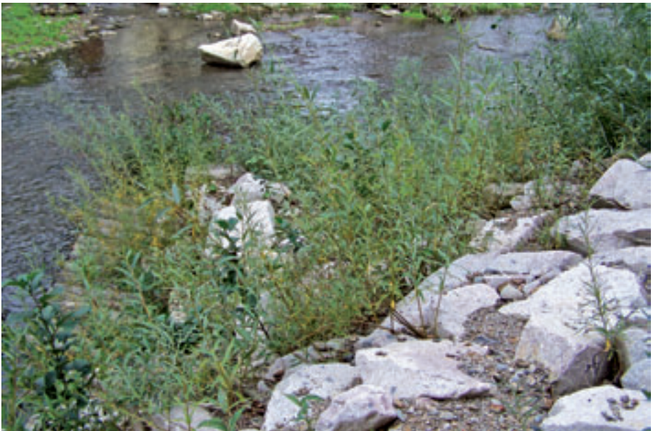
Abb. 14: Lebendbuhne in Kombination mit begrünter Steinschüttung mit einjährigem Austrieb der Weiden und Erlen – September 2008 Foto: A. Stowasser
