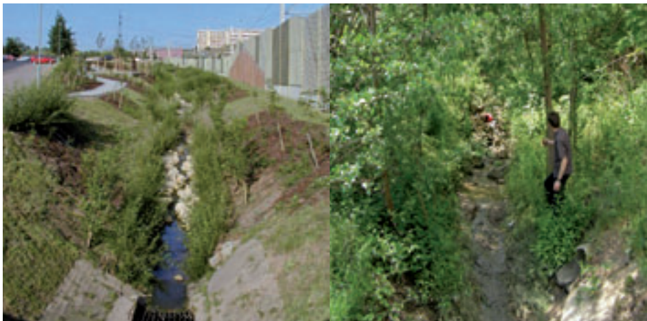
Abb. 9: Während der Austrieb der Lebendbauweisen (a) nach der ersten Vegetationsperiode 2001 zunächst zu einem geschlossenen Weidenbestand führt, dominieren (b) nach einigen Jahren die zusätzlich eingebauten Schlusswaldarten den Gewässer begleitenden Gehölzbestand (Zustand Juli 2007). Gewässersohle und Uferböschungen sind intensiv durchwurzelt, die hydraulische Leistungsfähigkeit des Gewässerquerschnitts ist gewährleistet und der Pflegeaufwand im Vergleich zum Ausgangszustand (vgl. Abb. 6) reduziert.
