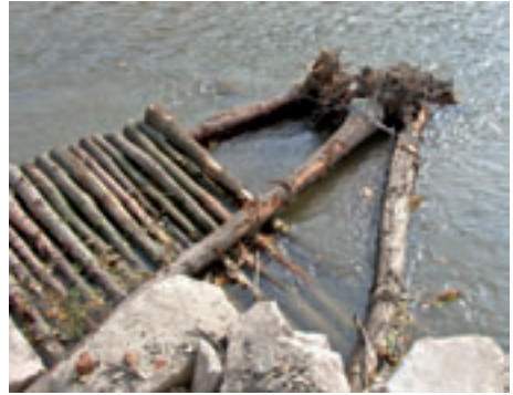
Abb. 12: Lebendbühne mit Fischunterstand im Bauzustand – September 2007 Foto: A. Stowasser
