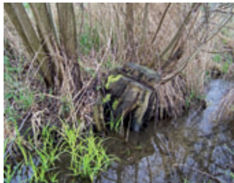
Abb. 5: Wurzelstubben kombiniert mit austriebsfähigen Weidensteckhölzern, (a) unmittelbar nach Baufertigstellung (Dezember 2000) und (b) acht Jahre später Foto: A. Stowasser
