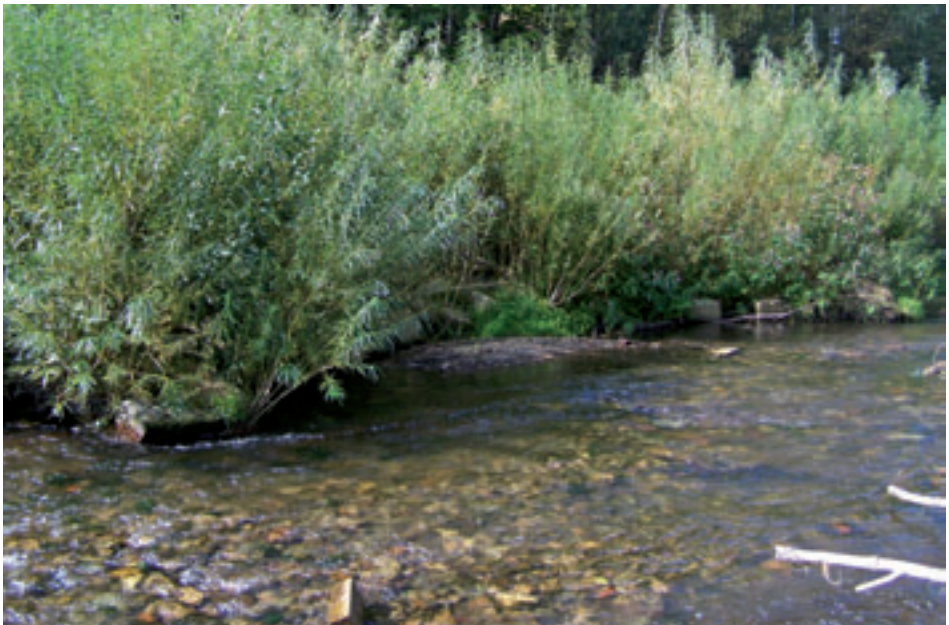
Abb. 15: Blick vom gegenüber liegenden Ufer auf die Ufersicherung aus den Abbildungen 11 – 14 im September 2009. Foto: A. Stowasser
