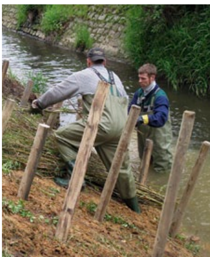
Abb. 18: Ingenieurbiologische Ufersicherung
