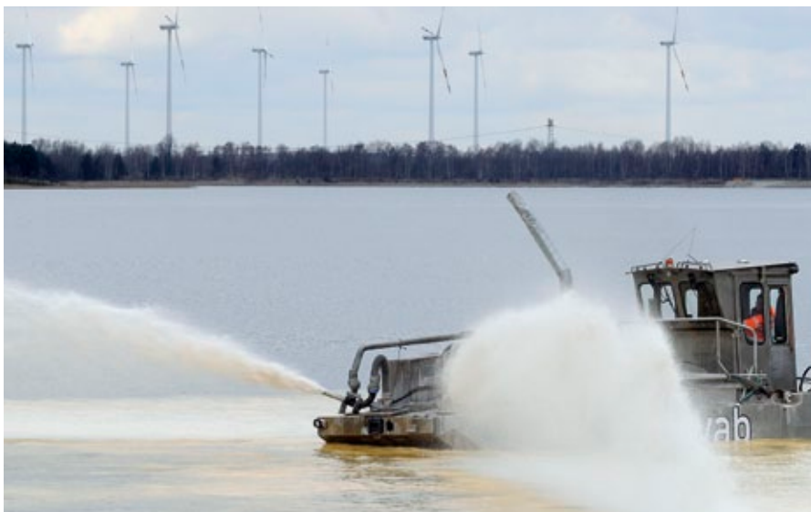
Abb. 19: Inlake-Verfahren – die Ausbringung von Kalkmilch stellt eine Möglichkeit zur Neutralisation des Seewassers schwefelsaurer Tagebaurestseen dar.
