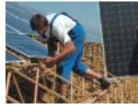
Montagearbeiten im Solarpark Espenhain
