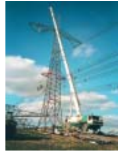
Grundinstandsetzungsarbeiten am Überlandleitungsnetz durch ABB
