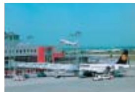
Neu ausgebauter Verkehrsflughafen Dresden
