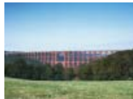
Göltzschtalbrücke im Vogtland, die größte Ziegelbrücke der Welt
