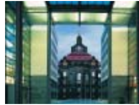
Die Sächsische Staatskanzlei, Blick vom neuen Ministerialgebäude
