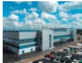
Die neue 300-mm-Waferfertigung der Siltronic AG in Freiberg
