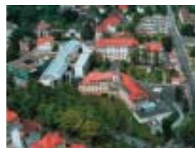
Die neuen Erweite-rungsgebäude am Kreis Krankenhaus Zittau
