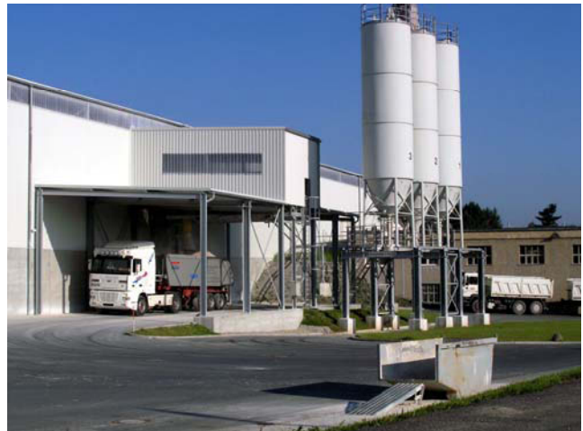
Abb. 81: Neue Verladung im Werk Kemmlitz
