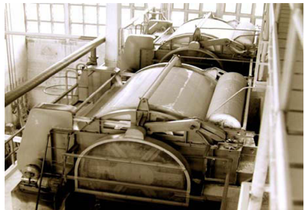
Abb. 72: Vakuumdrehzellenfilter im Werk II
