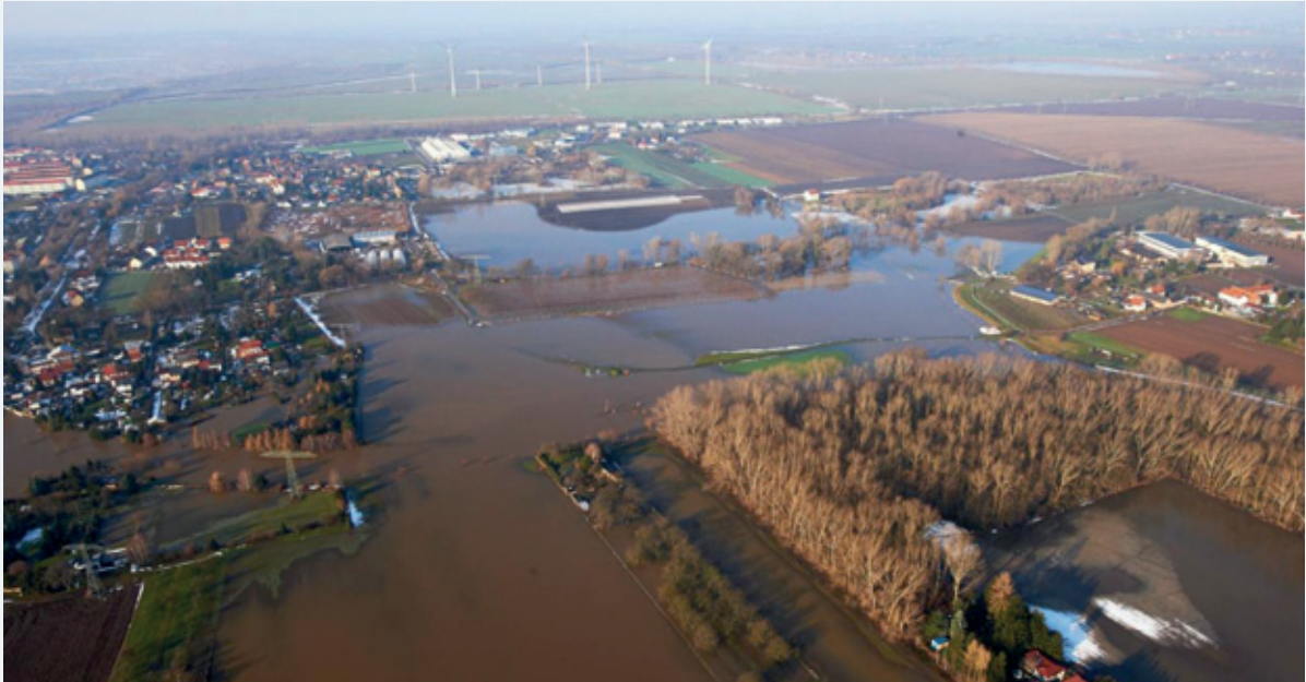
Abbildung 5-5: Überschwemmungen im Bereich Pegau am 10.01.2011 (Foto: LTV)
