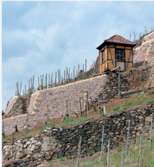
Abbildung 6-30: Rekonstruierte Weinbergmauern unterhalb des Spitzhauses in Radebeul (Foto: F. Aust)
