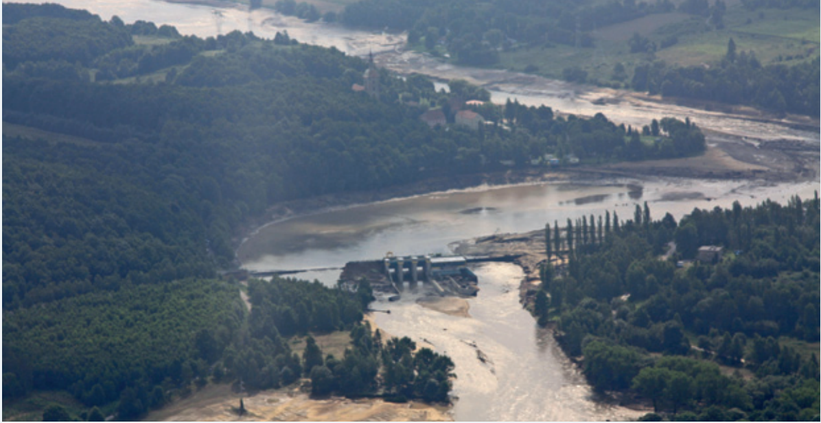
Abbildung 9-20: Das Tal der Witka mit dem gebrochenen Damm der Talsperre Niedów (Foto: SMI)
