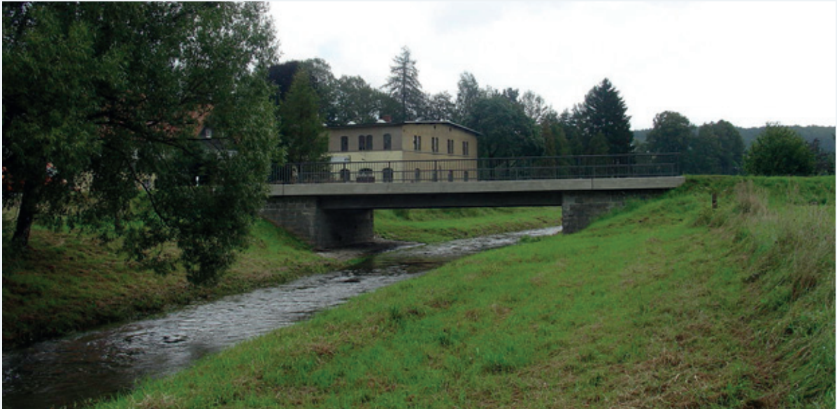
Abbildung 9-43: Vorhandenes Brückenbauwerk bis August 2010 (Foto: SBA Bautzen)
