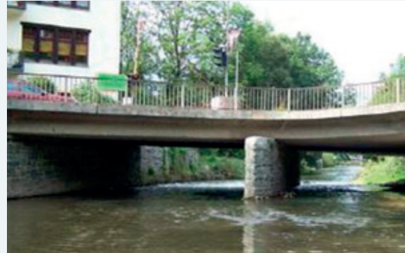
Straßenbrücke Klaffenbacher Straße
