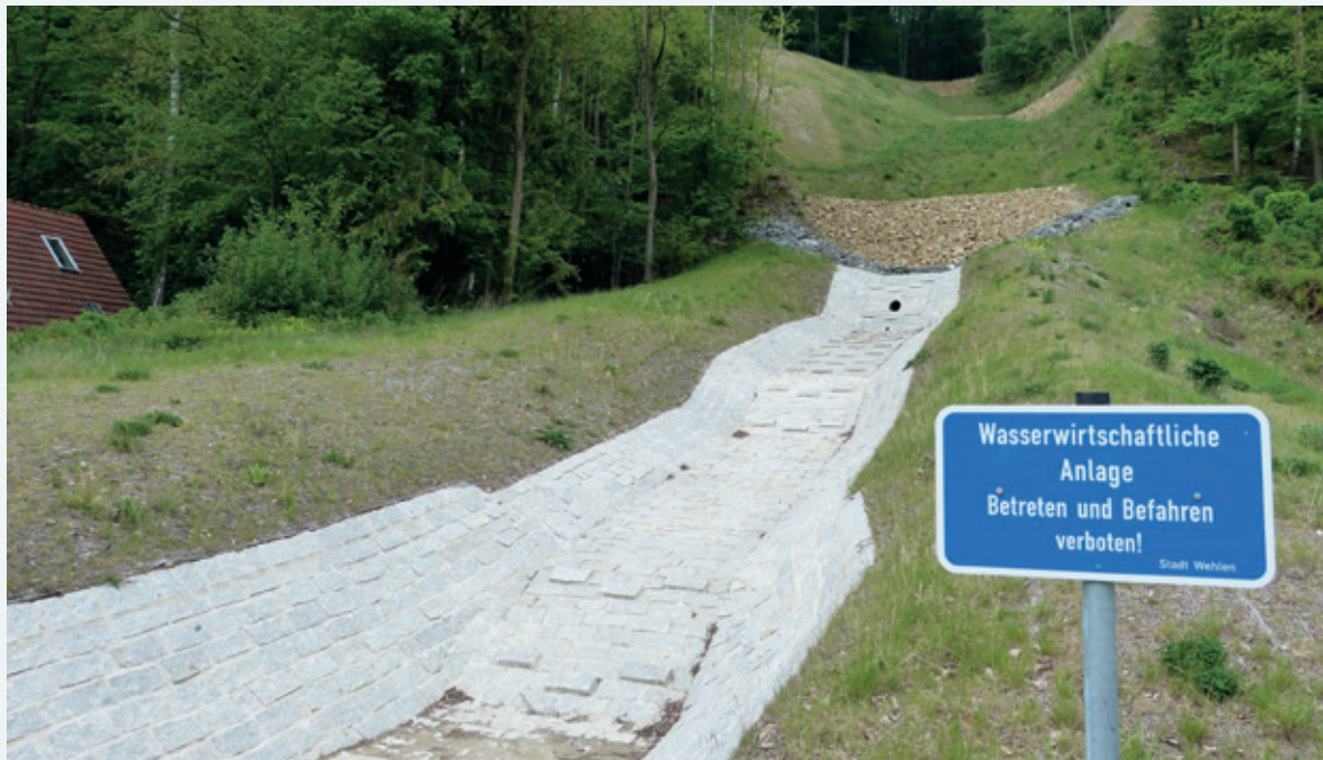
Abbildung 9-41: Das neu errichtete Gerinne unterhalb des Haldenfußes ein Jahr nach Fertigstellung (Foto: LTV, Mai 2012)
