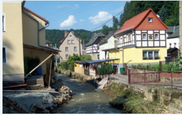
Abbildung 9-78: Nach dem Hochwasser des Krippenbachs, 10.08.2010 (Foto: LTV)
