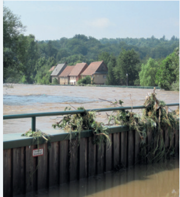
Abbildung 9-11: Überströmte Spundwand an der Klosterstraße (Foto: LTV)
