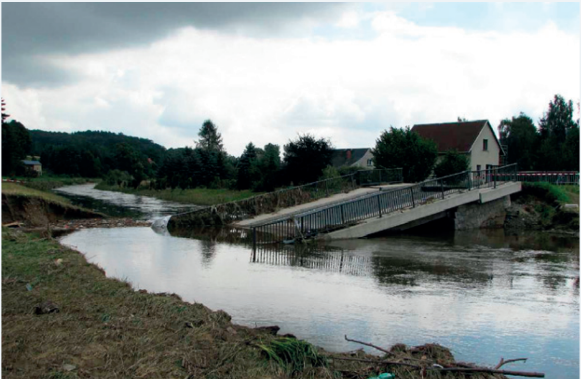
Abbildung 9-48: Zerstörte Brücke (Foto: Hr. Baldauf)
