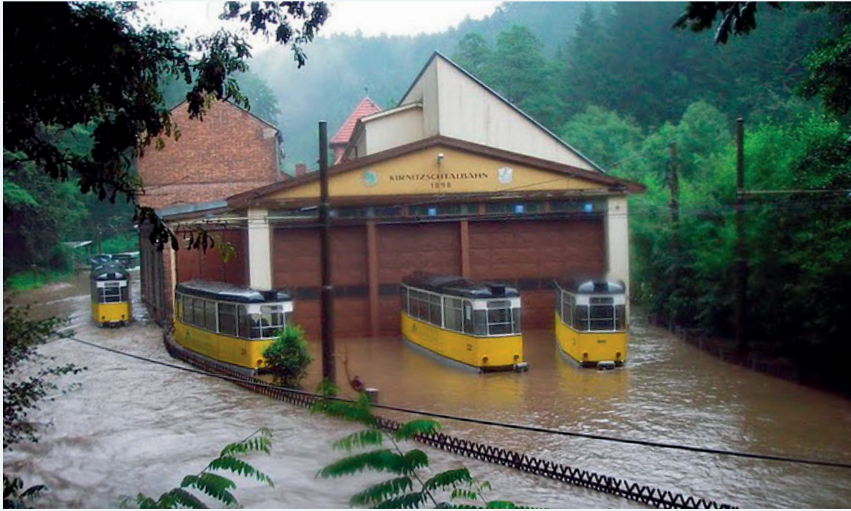
Abbildung 9-36: Das Depotgebäude der Kirmitzschtaalbahn während der ersten Hochwasserwelle am 07./08.08.2010 (Foto: OVPS)
