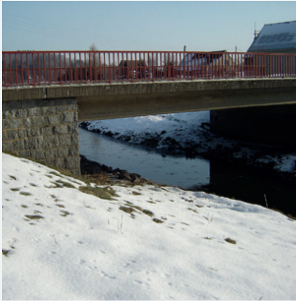
Abbildung 9-44: Vorhandenes Brückenbauwerk bis August 2010 (Foto: SBA Bautzen)
