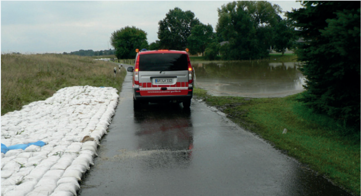
Abbildung 9-31: Sandsackverbau auf dem Deich während des Hochwassers (Foto: Landratsamt Görlitz)
