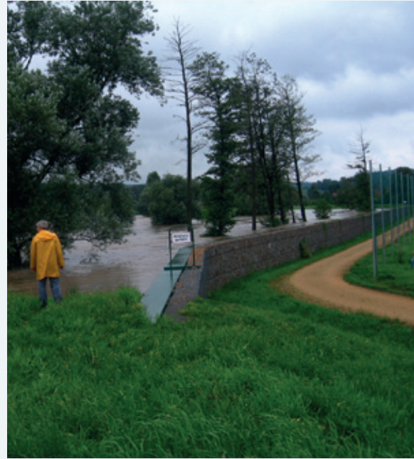
Abbildung 9-9: Kontrolle der Hochwasserschutzanlagen am 07.08.2010, nachmittags (Foto: LDS)
