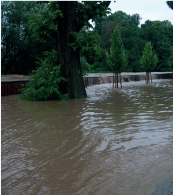
Abbildung 9-10: Überströmen der Spundwand am Franz-Gareis-Weg (Foto: LDS)
