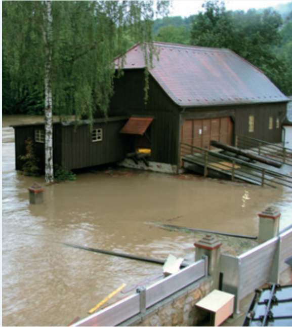
Abbildung 9-8: Ostritz Kloster. Aufbau mobiler Hochwasserschutz-elemente am 07.08.2010, gegen 16:00 Uhr (Foto: Kloster St. Marienthal)
