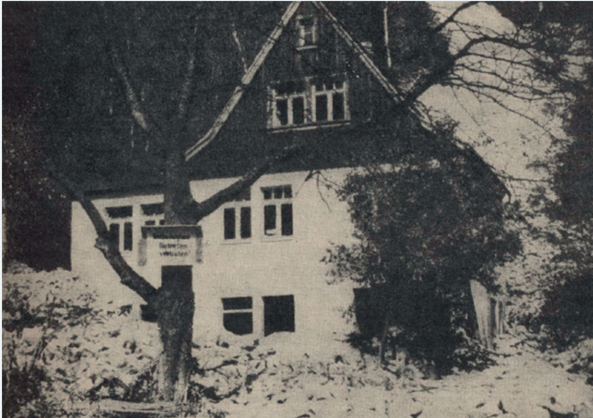
Abbildung 9 39: Das Wohngebäude Pirnaer Straße 199 nach der Mure 1958 (Foto aus Barthel 1965)
