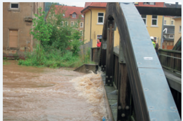
Abbildung 9-60: Einstau Brücke Hönickasteg (Foto: LTV)
