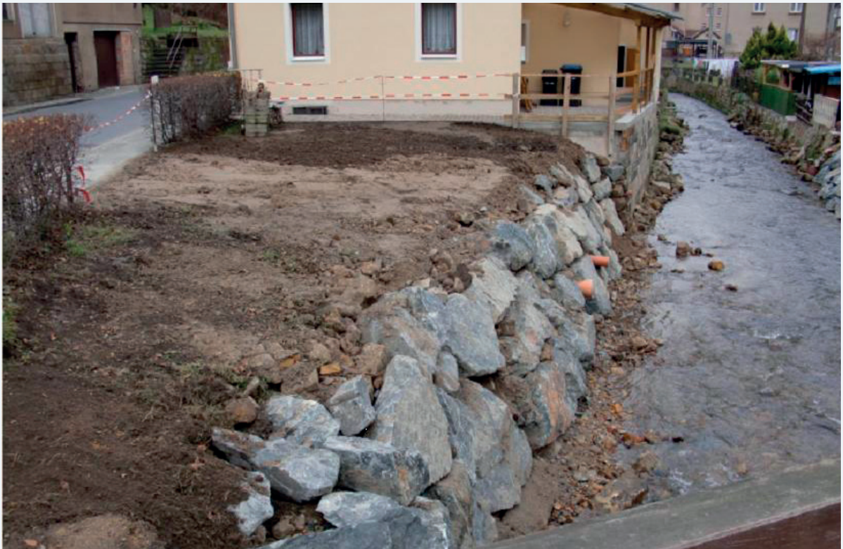
Abbildung 9-79: Maßnahmen Sofortsicherung 2010 (Foto: Stadtverwaltung Bad Schandau)
