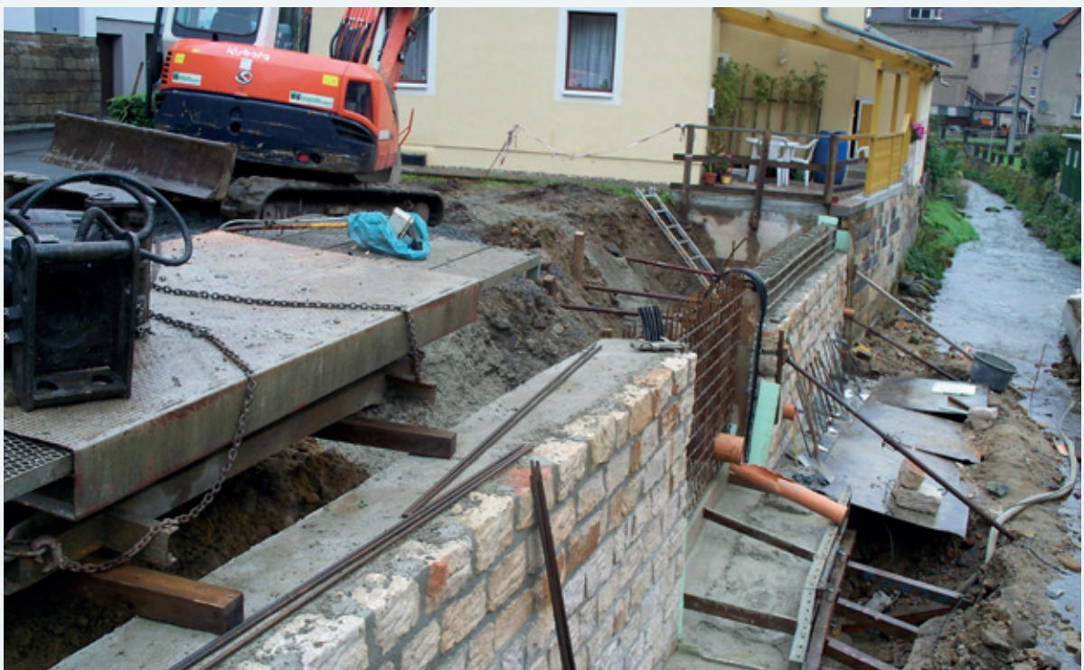
Abbildung 9-80: Endgültige Hochwasserschadensbeseitigung Sommer 2012 (Foto: Landesdirektion Sachsen)
