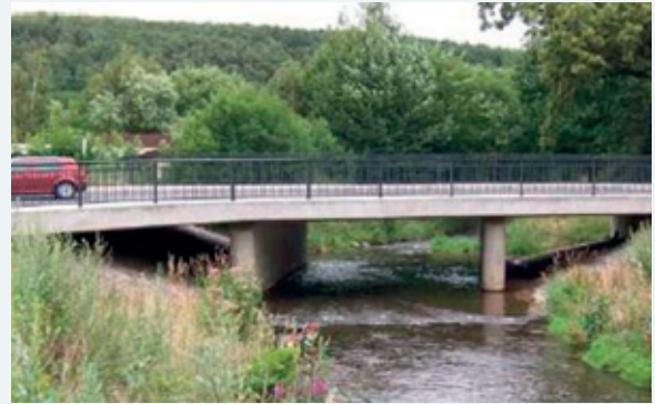
Brücke Klaffenbacher Hauptstraße
