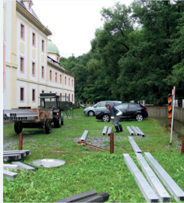
Abbildung 9-7: Ostritz Kloster. Aufbau mobiler Hochwasserschutz-elemente am 07.08.2010, gegen 14.00 Uhr (Foto: Kloster St. Marienthal)
