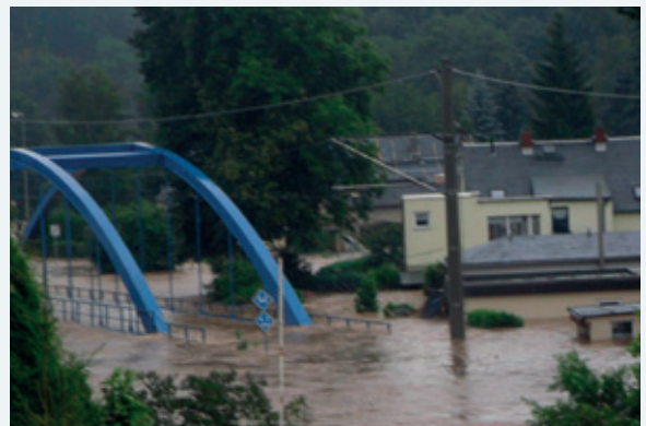
Abbildung 9-58: Einstau und Überströmen der Eisenbahnbrücke „Blaues Wunder“ in Chemnitz-Harthau am 07.08.2010 innerhalb weniger Stunden (Foto: LTV)
