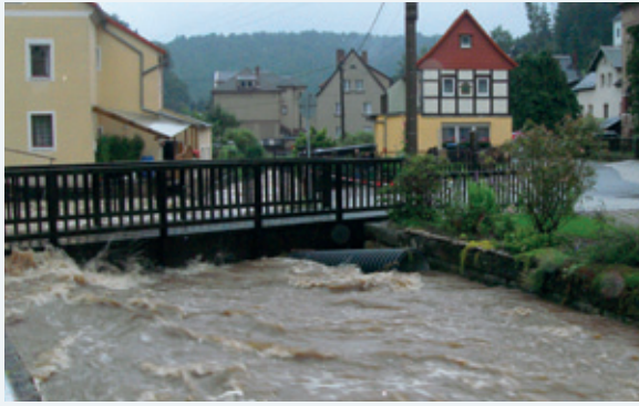
Abbildung 9-77: Hochwasser Krippenbach am 07.08.2010 (Foto: Stadtverwaltung Bad Schandau)
