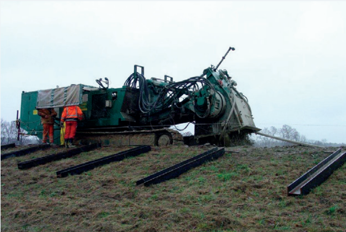
Abbildung 9-32: FMI-Einheit(Fräse) beim Einbau der Dichtwand (Foto: Ingenieurbüro für Wasser- und Tiefbau KG IWT)
