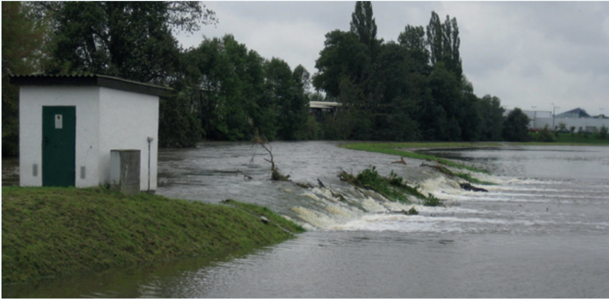
Abbildung 4-38: Überströmung des Teilschutzdeiches unmittelbar unterhalb des Pegels Kleinraschütz/Große Röder am 29.09.2010 bei HW = 316 cm (Foto: BfUL)
