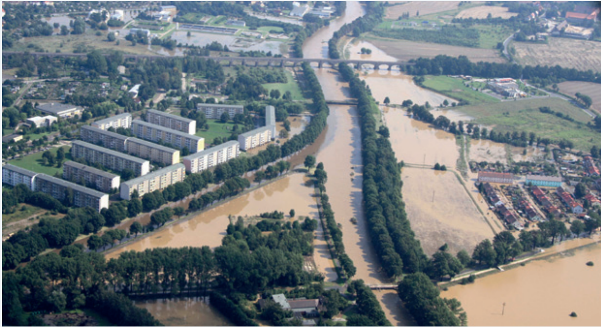
Abbildung 4-10: Von der Lausitzer Neiße überschwemmtes Gebiet in Zittau und Sieniawka am 08.08.2010 (Foto: SMI)
