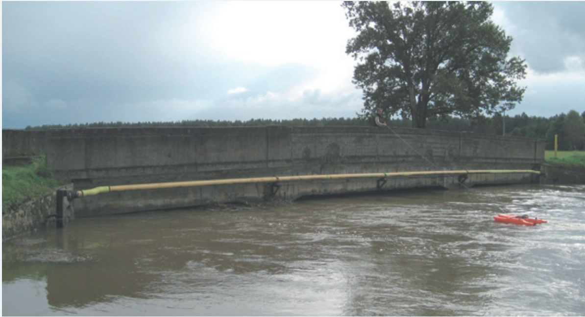
Abbildung 4-35: Durchflussmessung der BfUL mittels Ultraschall (ADCP) – Messboot am Pegel Neuwiese/Schwarze Elster bei W = 319 cm (fallend) am 29.09.2010 nachmittags (Foto: BfUL)
