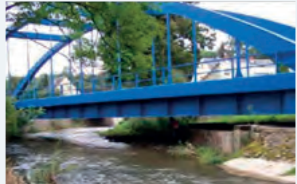
Eisenbahnbrücke „Blaues Wunder“
