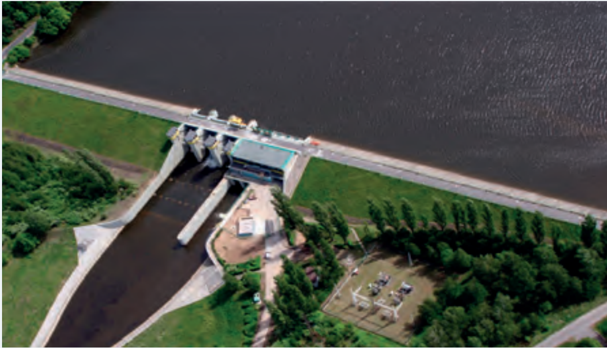
Abbildung 9-22: Talsperre Niedów an der Witka in der Republik Polen vor der Zerstörung durch das Hochwasser im August 2010 (Foto: PGE)
