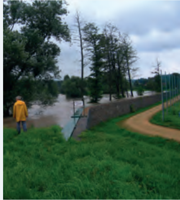
Abbildung 9-9: Kontrolle der Hochwasserschutzanlagen am 07.08.2010, nachmittags (Foto: LDS)
