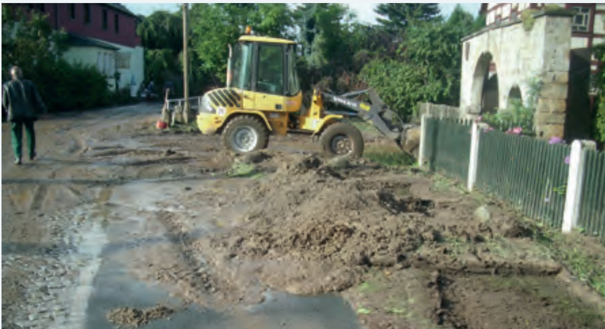
Abbildung 6-18: Feinmaterialablagerungen durch den Bonnewitzer Bach in Pirna (Foto: Stadtverwaltung Pirna)
