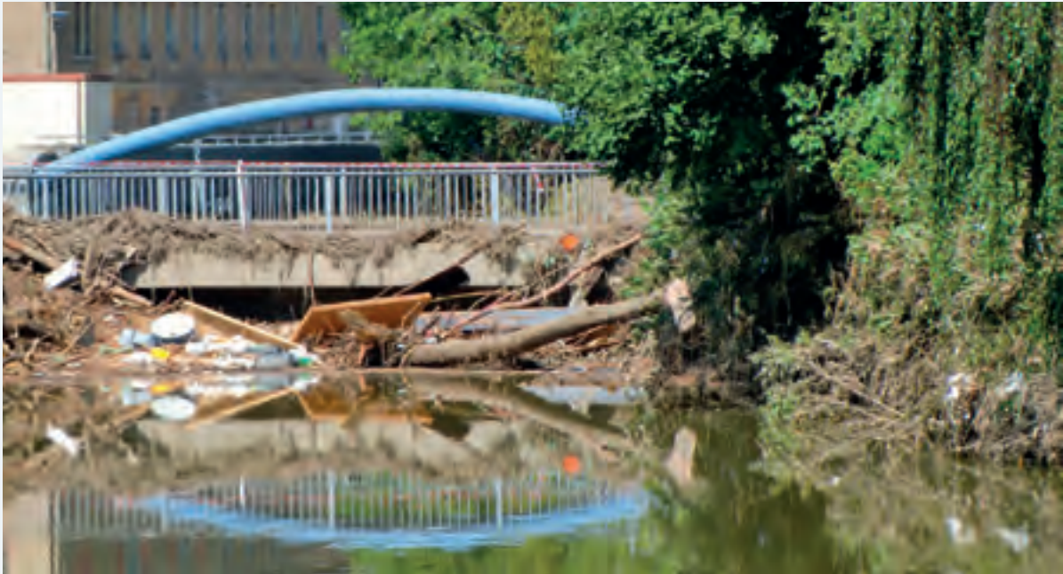
Abbildung 6-16: Verklauung der Brücke Bahnhofstraße in Ostritz (Foto: LTV)
