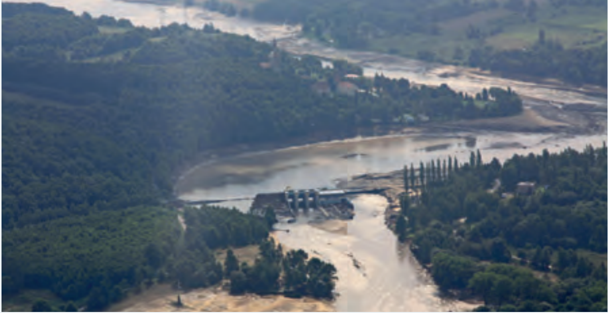
Abbildung 9-20: Das Tal der Witka mit dem gebrochenen Damm der Talsperre Niedów (Foto: SMI)
