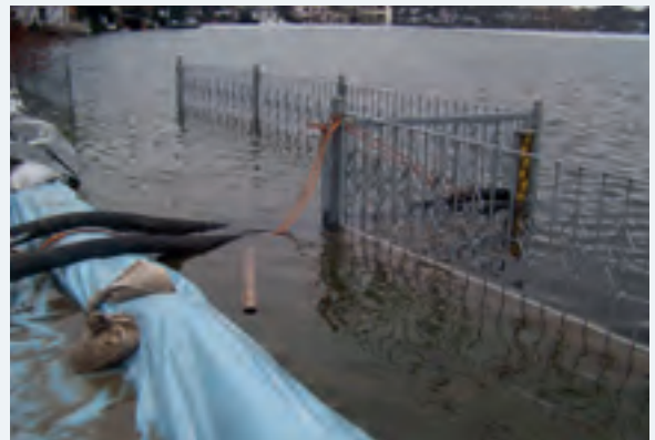
Abbildung 4-78: Abpumpen von Wasser aus dem Großsteinberger See (Foto: LRA Leipzig, 21.01.2011)
