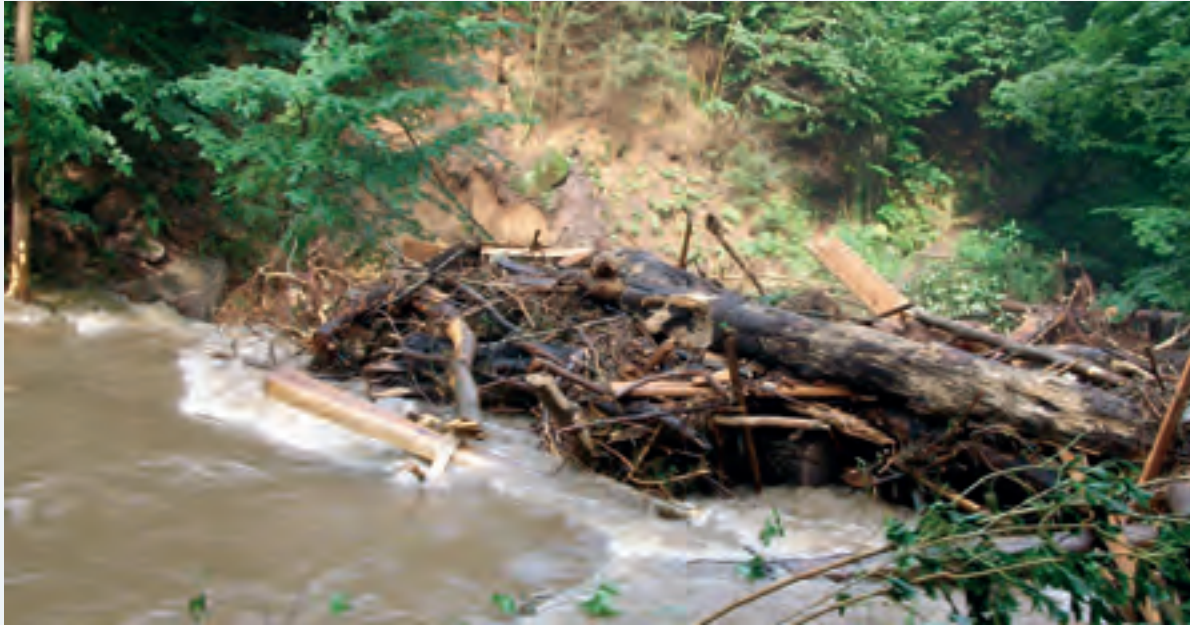
Abbildung 5-1: Aufstau und Verkläusung an einem Wehr unterhalb der Felsenmühle beim Auguthochwasser 2010 (Foto: LTV)
