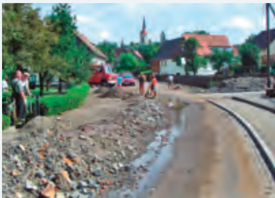
Abbildung 9-67: Schlamm- und Geröllablagierungen in der Ortslage Bertsdorf nach dem Hochwasser Anfang August 2010 (Foto: Bertsdorfer Heimatverein e.V.)
