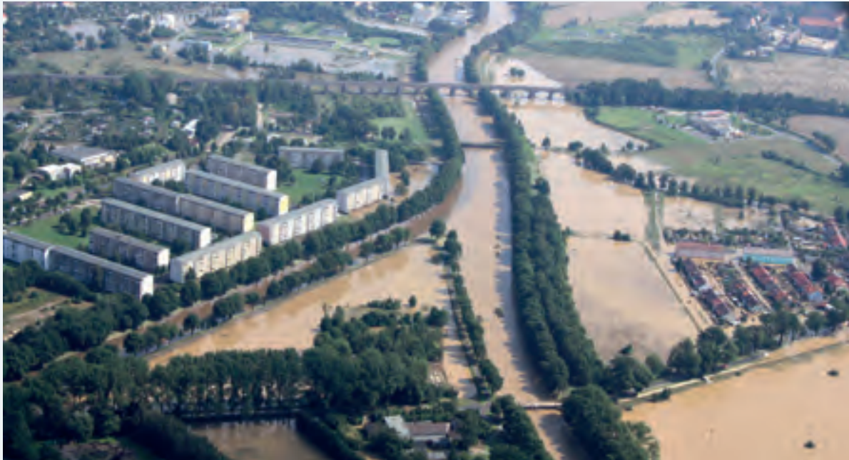
Abbildung 4-10: Von der Lausitzer Neiße überschwemmtes Gebiet in Zittau und Sieniawka am 08.08.2010 (Foto: SMI)
