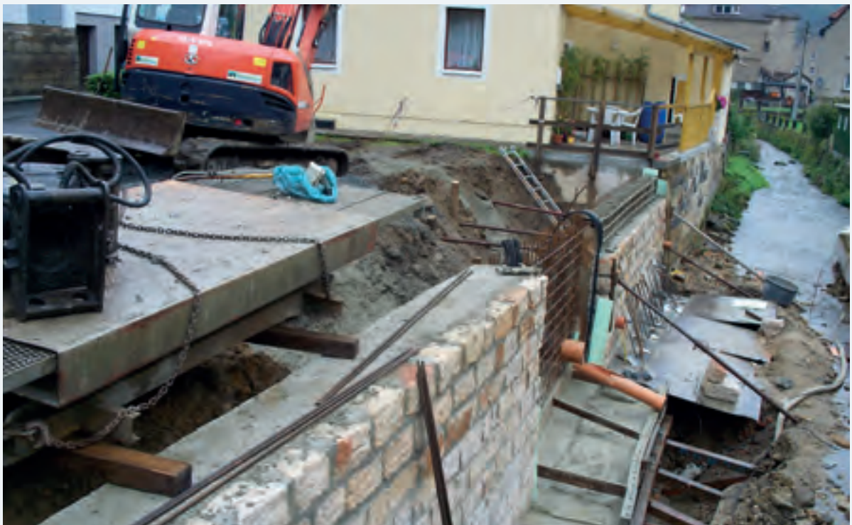
Abbildung 9-80: Endgültige Hochwasserschadensbeseitigung Sommer 2012 (Foto: Landesdirektion Sachsen)
