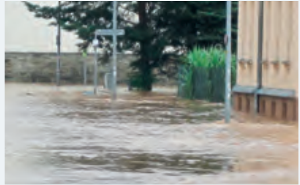
Abbildung 9-56: Überflutung Stadtteil Harthau (Foto: LTV)
