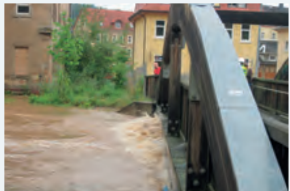
Abbildung 9-60: Einstau Brücke Hönickasteg (Foto: LTV)
