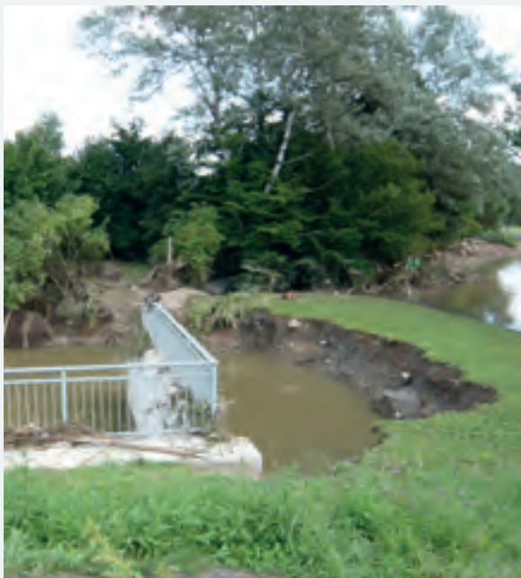
Abbildung 9-18: Ostritz, Kolk am Sielbauwerk (Foto: LTV)
