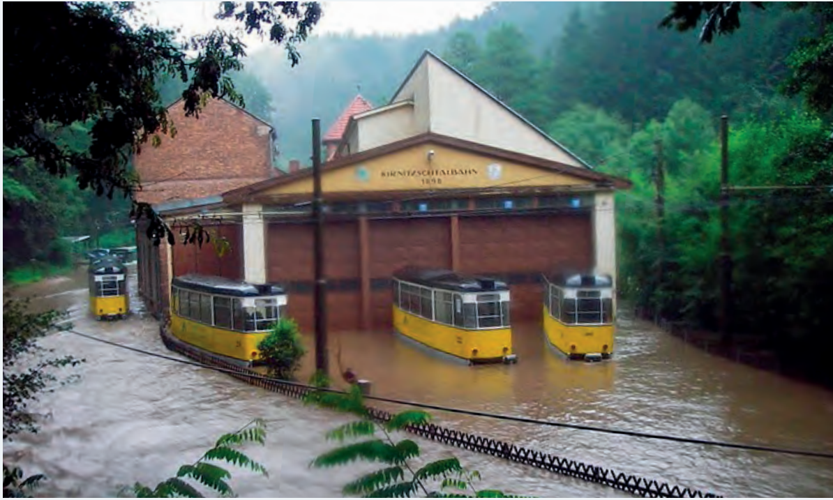
Abbildung 9-36: Das Depotgebäude der Kirnitzschalbahn während der ersten Hochwasserwelle am 07./08.08.2010 (Foto: OVPS)
