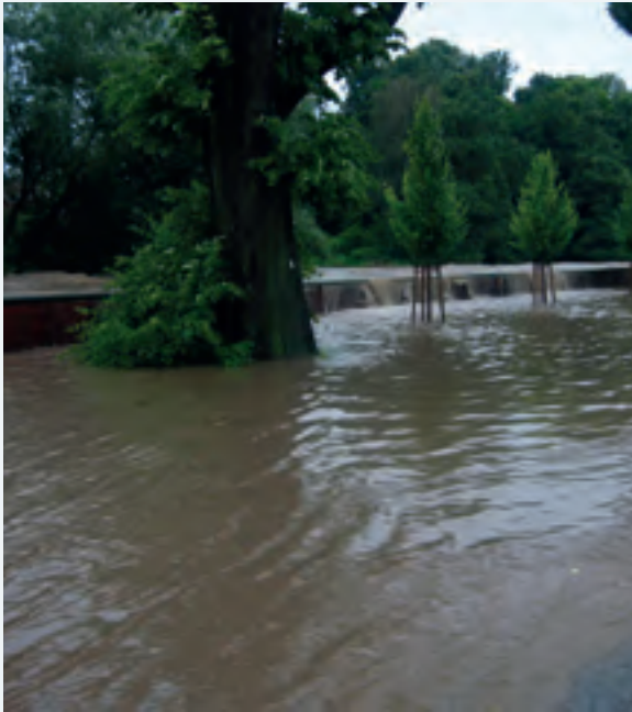
Abbildung 9-10: Überströmen der Spundwand am Franz-Gareis-Weg (Foto: LDS)
