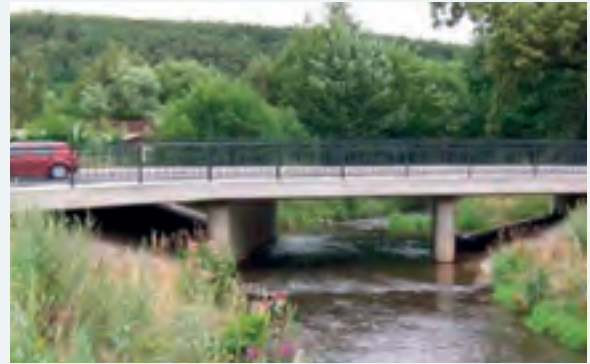
Brücke Klaffenbacher Hauptstraße
