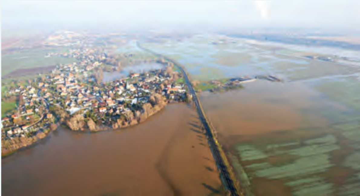
Abbildung 5-7: Die B2 im Überschwemmungsbereich der Weißen Elster und des Profener Elstermühlgrabens (Foto: LTV)
