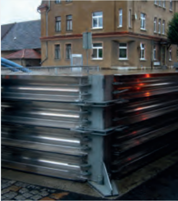
Abbildung 9-6: Ostritz, aufgebauter mobiler Hochwasserschutz an der Bahnhofstraße/Turbinengraben am 07.08.2010, gegen 17:00 Uhr (Foto: LDS)
