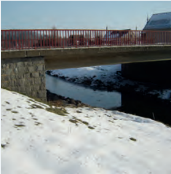
Abbildung 9-44: Vorhandenes Brückenbauwerk bis August 2010 (Foto: SBA Bautzen)
