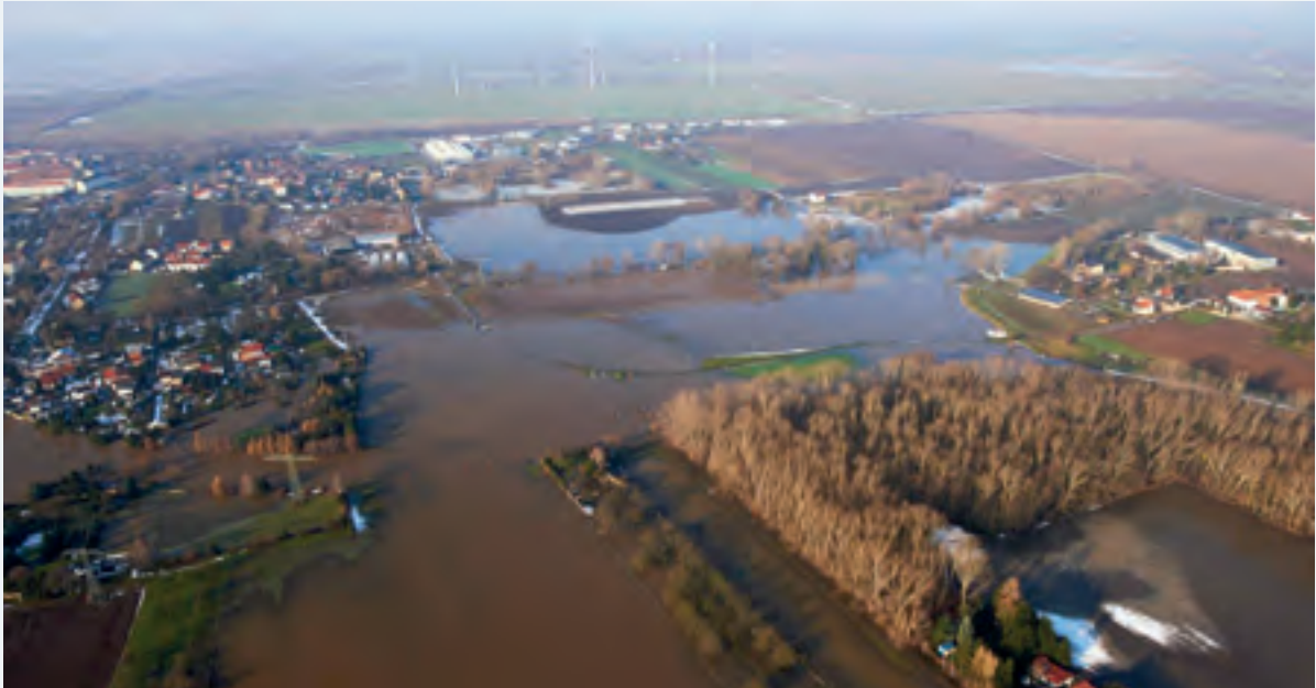
Abbildung 5-5: Überschwemmungen im Bereich Pegau am 10.01.2011 (Foto: LTV)
