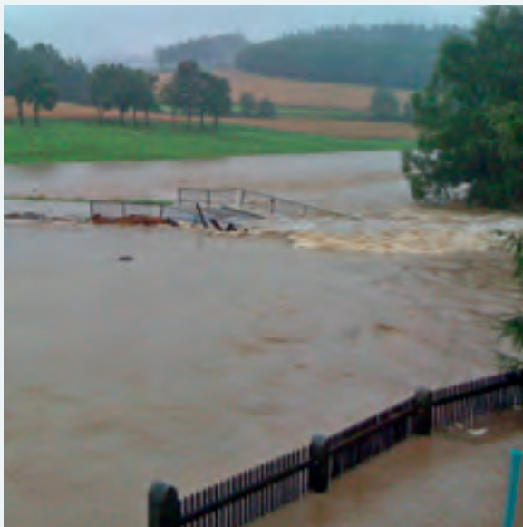
Abbildung 9-46: Überströmen (Foto: Hr. Baldauf)
