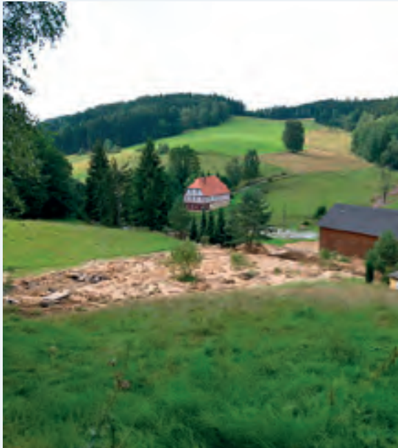
Abbildung 6-24: Wild abfließendes Wasser nach der Zerstörung eines Straßendamms an der Straße nach Hinterhermsdorf (Landkreis Sächsische Schweiz-Osterzgebirge) im August 2010 (Foto: R. Schneider)
