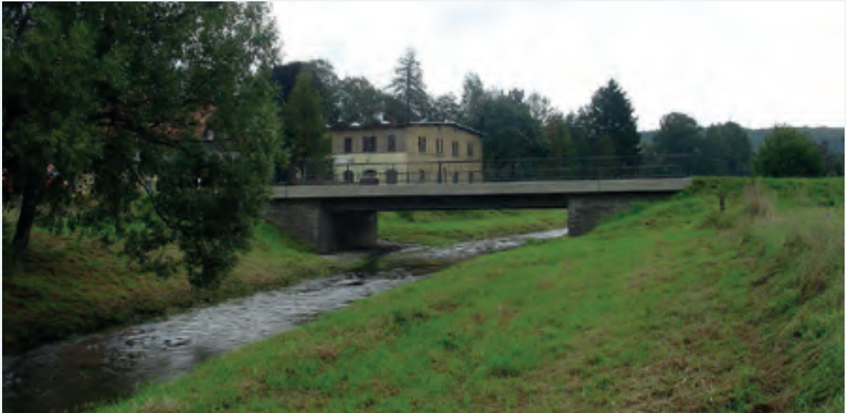
Abbildung 9-43: Vorhandenes Brückenbauwerk bis August 2010 (Foto: SBA Bautzen)
