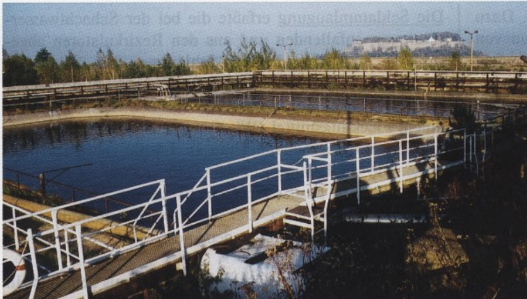
Abb. 169: Reichlösungsbecken zur Weiterleitung der Rückauflösung in die Aufbereitung, als Puffer in den Lösungskreislauf eingeschaltet. Foto: J. KUGLER, 1996
