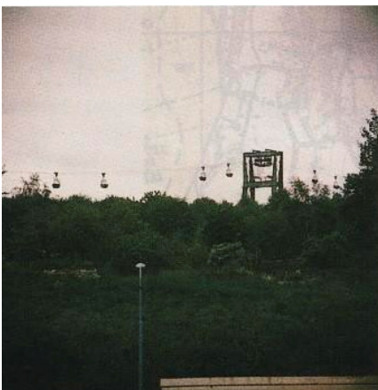
Abb. 156: Lastenseilbahn vom Schacht „390“ zum Bahnanschluß Rottwerndorf, 1985 demontiert. Foto: Wismut GmbH, Abt. Dok. und Information
