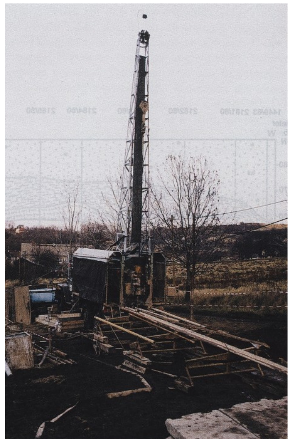
Abb. 148: Selbstfahrendes Bohrgerät vom Typ SIF-300. Mit diesen Maschinen wurde die Lagerstätte aufgesucht und vorerkundet. Foto: J. KUGLER
