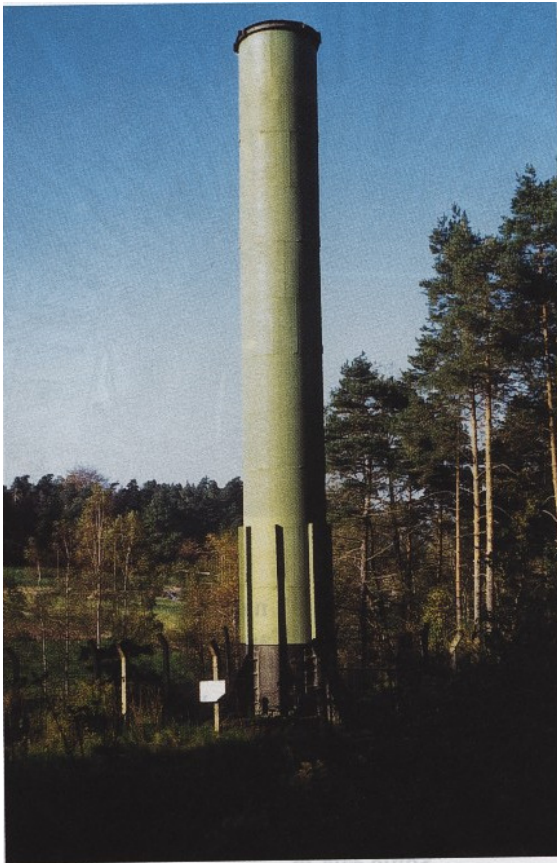
Abb. 157: Wetterbohrloch Nr. 5: Hirschstange/Teufelsgrund, nach 1979 zur Verbesserung der wettertechnischen Bedingungen gemeinsam mit 6 weiteren Wetterbohrlöchern angelegt und später aufgerohrt. Foto: J. KUGLER, 1996
