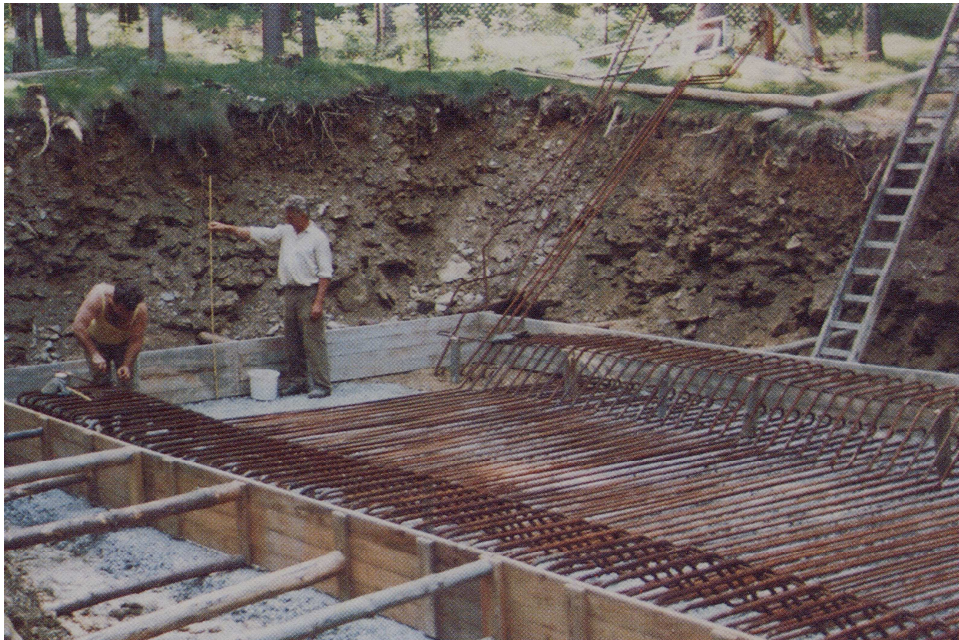
Abb. 119a: Verwahrung von Taesüberhauen: Anbringen der Eisenbewehrung
