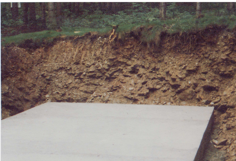
Abb. 119b: Verwahrung von Tagesüberhauen: Fertige Betonplatte
