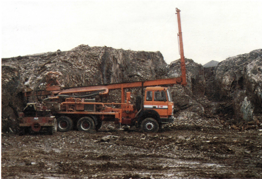
Abb. 118a: Anbohren eines Abbauhohlraumes von Übertage
