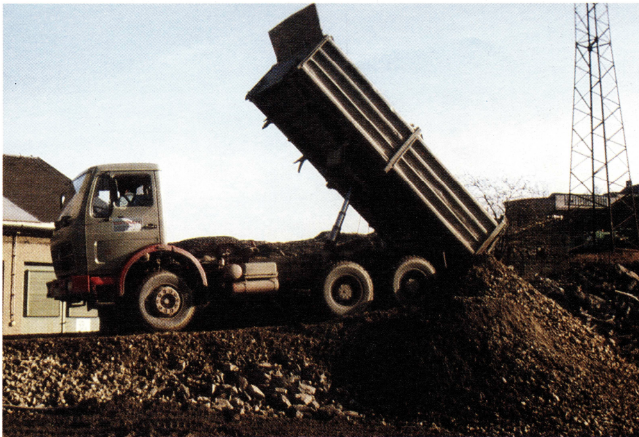
Abb. 118b: Versatz eines Abbauhohlraumes über Bohrlöcher von Übertage
