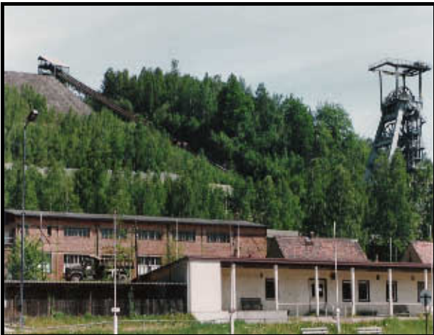
Abb. 4-1-10: Schacht 371 mit seinem charakteristischen Schrägaufzug zur Bergehalde
