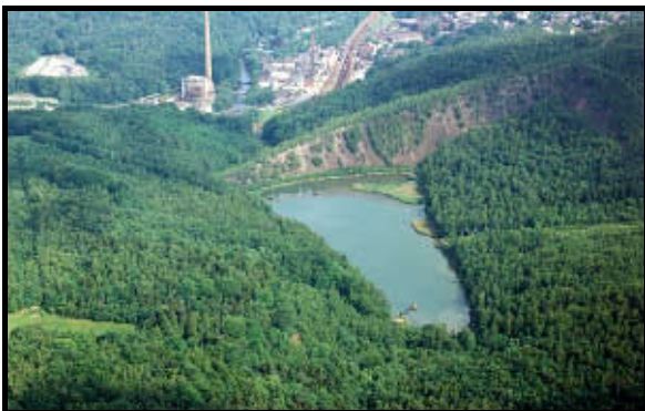
Abb. 5-10: Absetzbecken Borbachtal und Halde Borbachtaldamm vor der Sanierung (1992)
