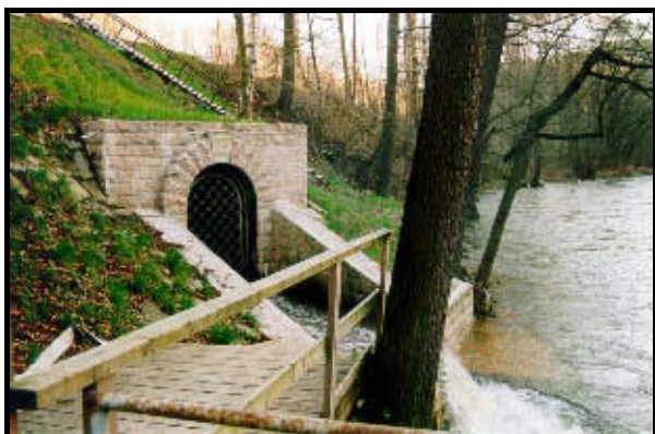
Abb. 5-5: Mundloch der Abflussrösche der Wasserbehandlungsanlage
