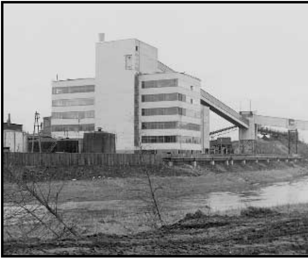
Abb. 3-6-7: Neue Radiometrische Zeche mit Erzoffenlager im Aufbereitungsbetrieb 101 in Crossen
