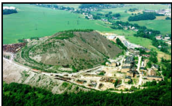
Abb. 5-6: Halde und Betriebsgelände des Schachtes 366 bei Alberoda vor der Sanierung
