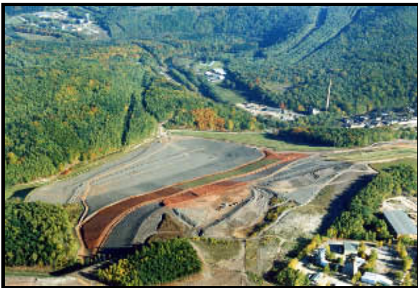
Abb. 5-11: Trockenverwahrtes Absetzbecken mit sanierter Halde Borbachdamm und laufende Abdeckerarbeiten an der Halde 382 (Stand 2003)
