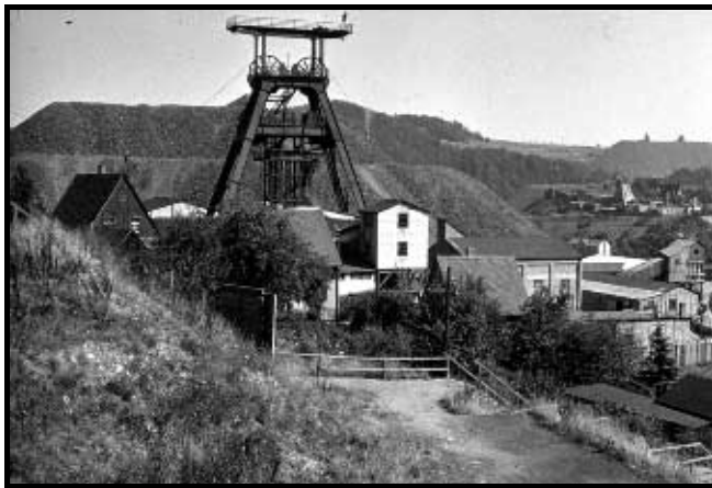
Abb. 4-1-3: Schacht 38 - nach seiner Rekonstruktion im Jahr 1955 erster moderner Großschacht im Schlemaer Revier, rechts Schacht 207 und Halde 296
