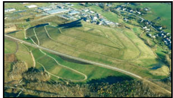
Abb. 5-7: Profilierter, abgedeckter und begrünter Halde und Betriebsfläche 366 mit der Trasse des neuen Autobahnzubringers (S 255)
