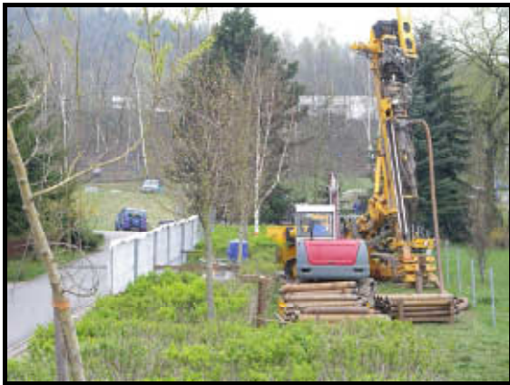
Abb. 5-2: Versatzbohrungen für die Nachverwahrung von Schacht 8 am Rand des Oberschlemaer Kurparks
