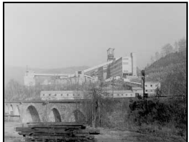
Abb. 3-6-4: Die Radiometrische Aufbereitungsfabrik (RAF) am Schacht 371 im Jahr 1963
