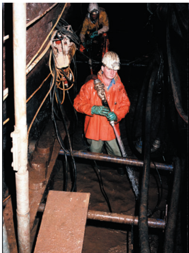
Abb. 10-23: Hydraulische Entschlammungsarbeiten im Tiefen Elbstolln; Foto: WEISSE
