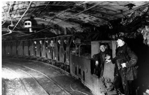
Abb. 14.4-6: Mannschaftszug, im Bahnhof am ehemaligen Schacht 2, 13. Sohle Paul-Berndt Grube. Oberleitungslok Siemens & Schuckert Werke, verm. Typ NG 261. 1950; Foto: Deutsche Fotothek Nr. 104377
