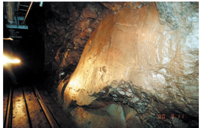
Abb. 7-1: GW-führende Klüfte im Porphyrit, Tiefer Elbstolln bei 5720 m v. Mdl.; Foto: SCHAUER
