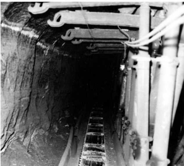
Abb. 10-12: Abbauausrüstung beim Einsatz der Teilschnittmaschine: Zweikettenkratzförderer (ZKKF), Hydraulikstempel und Vorbaukappen, 5. Flöz unterhalb Lette 5, Gf. Bannewitz-Süd; Foto: SDAG Wismut
