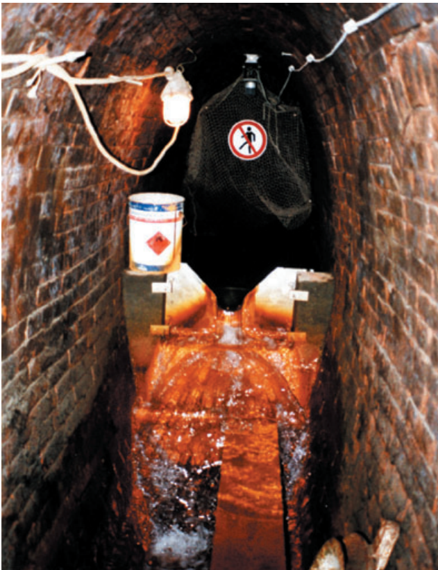
Abb. 10-24: Ausmauerung mit Klinker und Messwehr im SO-Elbstollnflügel, Foto: SCHAUER
