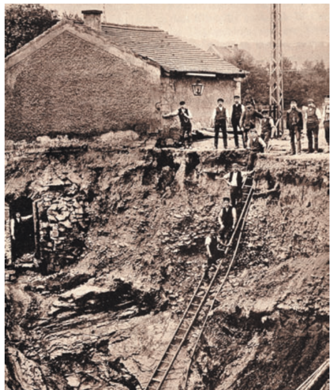
Abb. 9.2-12: Ausgewaschener Erdkessel (bis 12 m tief, 8200 m 3 Volumen) im Bereich der Ernst Strecke als Folge des Weißeritz-Hochwassers vom 30./31. Juli 1897. Links Rest der Ernst-Strecke zur Kaue. Nach HAUSSE, 1898: 46
