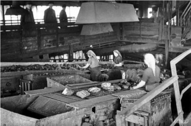
Abb. 14.6-2: Maschinelle Trockensortierung, Klaubeband durch Frauen besetzt, Staubabsaugung über der Anlage, Döhlener Wäsche, 1950; Foto: Deutsche Fotothek Nr. 103487
