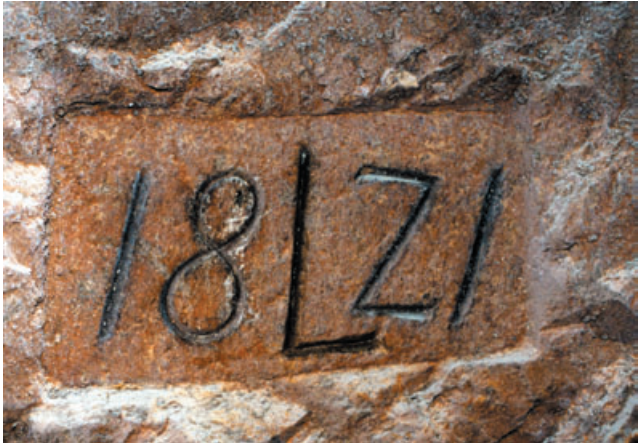
Abb. 14-5: „Tiefer Elbstolln“, bei 676 m. Das Vortriebs- und Gedingegezeichen (auch Gedingestufe) bedeutet: Stand des Vortriebes Jahresende 1821. Der Stollen wurde von rechts nach links aufgeföhren. Das Zeichen (die „Stufe“) musste der Berggeschworene einschlagen. Foto: SCHAUER
