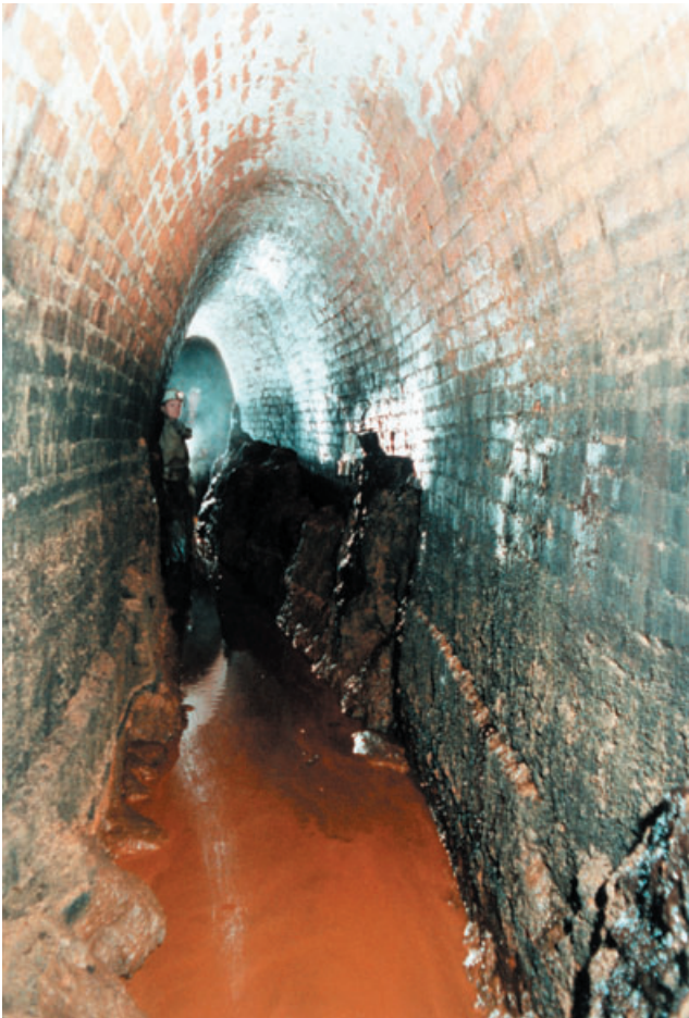
Abb. 14-1: Klinkerausmauerung im Mundlochbereich des Tiefen Weißeritz Stolln, Freital-Potschappel; Foto: HAUSTEIN
