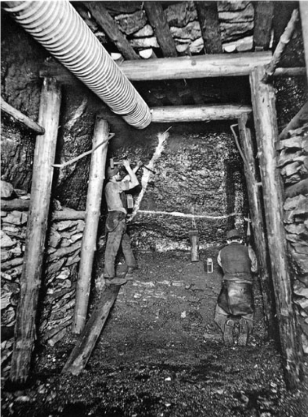
Abb. 14-19: Vortrieb einer Streichstrecke im 1. Flöz. Deutscher Türstockausbau mit eisernen „Hefnägeln“ und Bergemauer am Streckenstoß. An der Firste eine „Lutte“ (Blechrohr) zur Bewetterung. Verm. Königl. Steinkohlenwerke; Foto: GEORGI et al. 1894: Abb. 7
