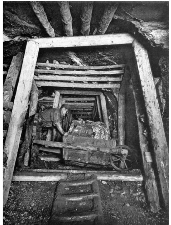
Abb. 14-7: „Karrenläufer“, gleislose Förderung untertage mit Schubkarren. Über dem Rücken ein Tragegurt. Die Karrenholme waren am Kasten nur angeschraubt, zur rationellen Reparatur; Foto: GEORGI et al. 1894: Abb. 17
