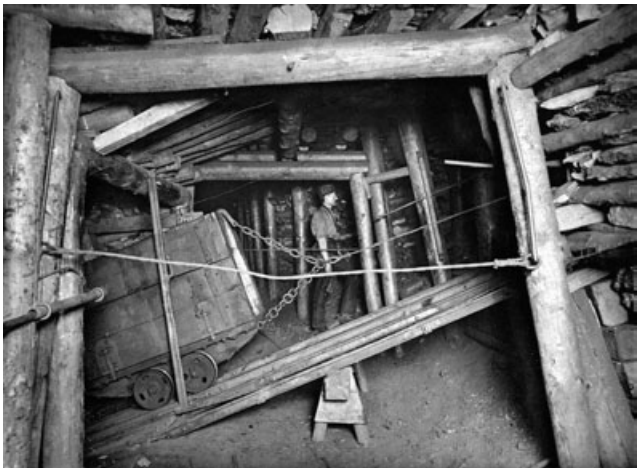
Abb. 14-9: Bremsberg mit Hunt am Seil mit Kettenverbindung, etwa ab 1876. Königl. Steinkohlenwerke, Foto: GEORGI et al 1894: Abb. 19
