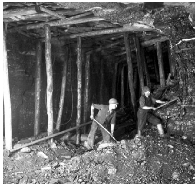
Abb. 9.2-16: Abbau des ca. 5 m-mächtigen Flözes. Förderung mit Schüttelrutsche. Döhlen Formation, 1. Flöz. Gf. Unteres Revier, Schacht 2, 1950. Freital-Burgk; Foto: Deutsche Fotothek Dresden, Nr. 104424
