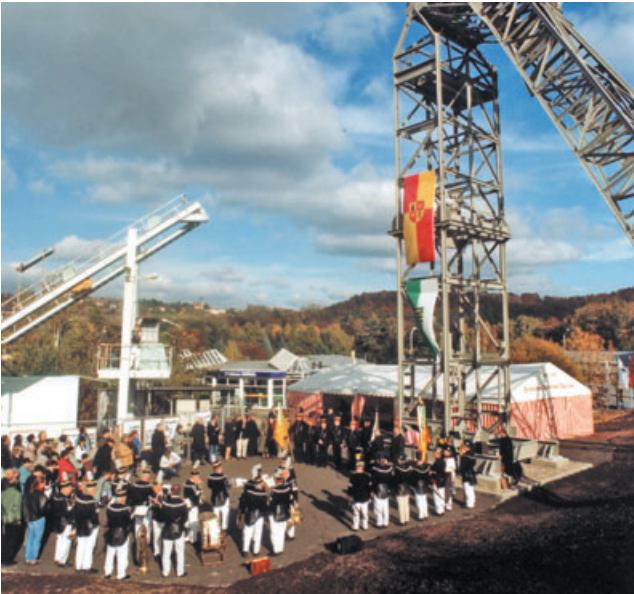
Abb. 14.9-1: Bergbaudenkmal : Neuaufrichtung des Fördergerüsts vom ehem. Schacht 2 (Grube Dresden-Gittersee) im Bereich des Oppel Schachtes in Freital-Zauckerode am 23.10.2003, Foto: WEISSE, WISMUT GmbH
