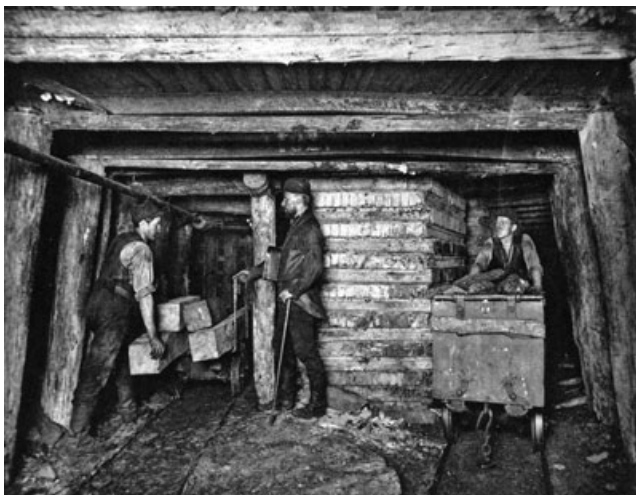
Abb. 14-25: Kompakter Holzpfeiler an Streckenabgang, rechts ein Huntstößer, links ein Fördermann mit einem „Holzketcher“. Königl. Steinkohlenwerke; Foto: GEORGI et al. 1894: Abb. 18
