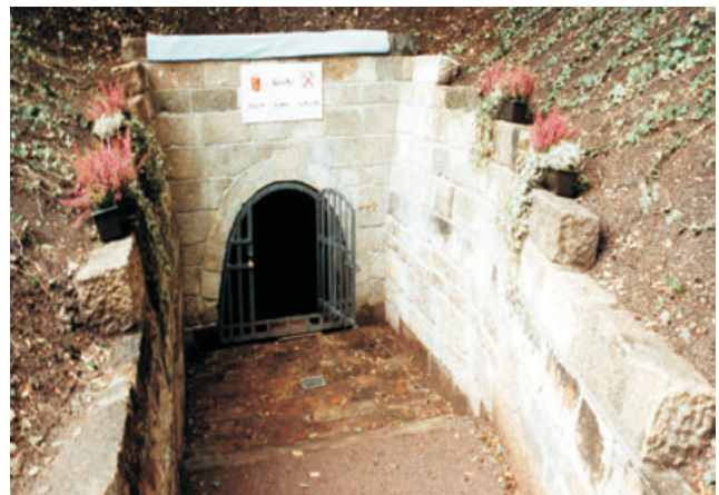
Abb. 14.9-4: Bergbaudenkmal: Rösche des Segen Gottes Schachtes mit Sandstein Ausmauerung. Poisentalstraße, Freital-Niederhäslich; Foto: STUTE
