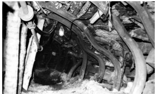
Abb. 10-19: Deformierte Stahl-Polygonbau einer Strecke an der Grenze zu einem Bruchfeld; Foto: SDAG Wismut
