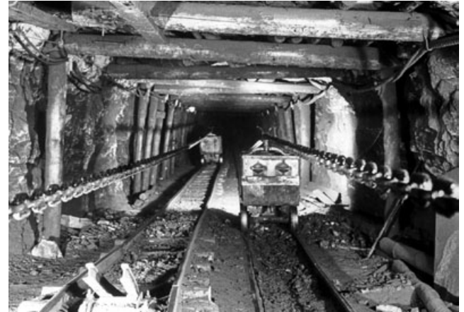
Abb. 14.4-2: Kettenberg zwischen 13. und 17. Sohle - aufgefahren im 3. Flöz (leichter Ausbau). Links „Fänger“ für aus der Kettengabel ausgeklinkte und abgehende Hunte. Paul-Berndt Grube 1950; Foto: Deutsche Fotothek Nr. 104380
