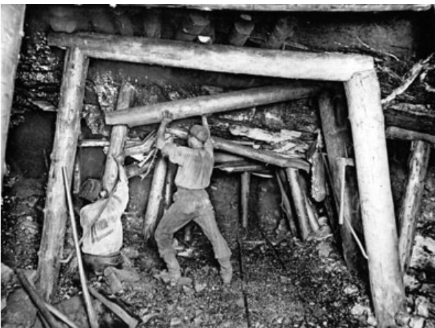
Abb. 14-20: Umbauzimmerung einer verbrochenen Streichstrecke mit Deutsch. Türstock. Verm. Königl. Steinkohlenwerke; Foto: GEORGI et al. 1894: Abb. 13
