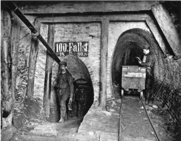
Abb. 9.2-10: Untergebirgsstrecke (hier 100. Fallstrecke), wichtige Abwetterwege und Verbindungen zwischen den Hauptsohlen (s. Ausrichtungsschema von FÖRSTER). Ausmauerung der elliptischen Streckenprofile mit Plänersandstein und Ziegeln. Königl. Steinkohlenwerke; GEORGI et. al. 1894: Abb. 29
