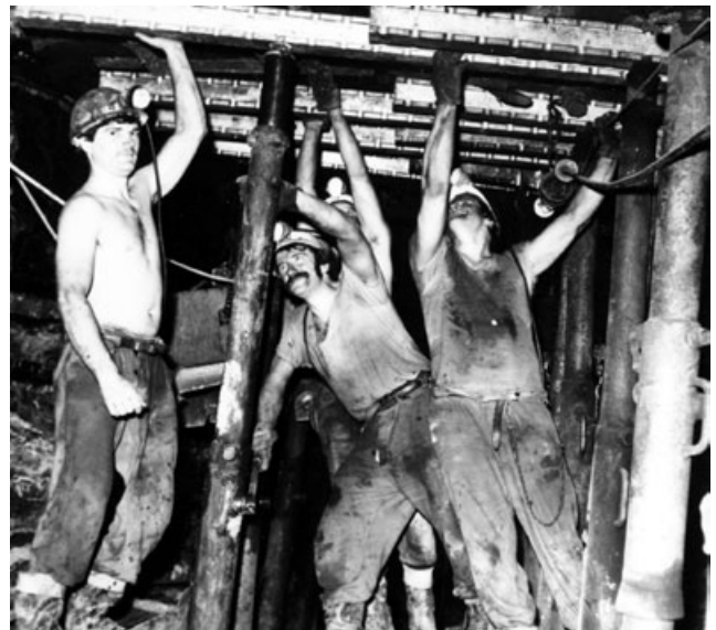
Abb. 10-18: Ausbau im Abbau mit Hydraulikstempel und Aluminiumhohlkapfen; Foto: SDAG Wismut
