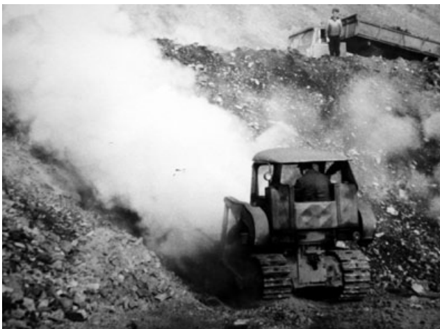
Abb. 14.8-4: Bekämpfung der Schwelbrände auf der Bergehalde Dresden-Gittersee; Foto: HUTH 1967
