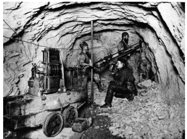
Abb. 14-16: Elektrisch betriebene Diamantbohrmaschine beim Streckenvortrieb im Grundgebirge, ab 1888/89 beim 8. und 10. Hauptquerschlag Königin-Carola Schacht, Freital-Döhlen. Königl. Steinkohlenwerke Foto: GEORGI et al. 1894: Abb. 5
