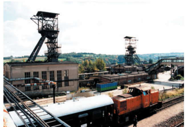
Abb. 14.4-11: Schachtfördertürme Bergbaubetrieb Willi Agatz Dresden-Gittersee mit Verladeanlage, links Schacht 1, rechts Schacht 2; nach Demontage und Umsetzung Bergbaudenkmal, Foto: HAUSTEIN
