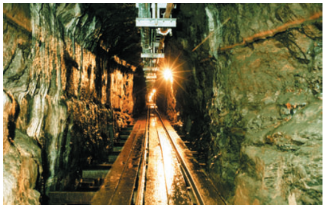
Abb. 14-4: Entschlammter Tiefer Elbstolln mit neu installierter Gleisanlage. An den Stößen Wasserstandsmarken, die vor der Sanierung entstanden. Foto: WEISSE, WISMUT GmbH
