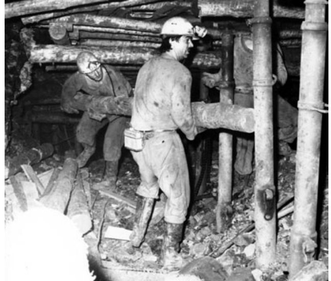
Abb. 10-17: Ausbau im Abbau mit Hydraulikstempel und Holzkapfen; Foto: SDAG Wismut
