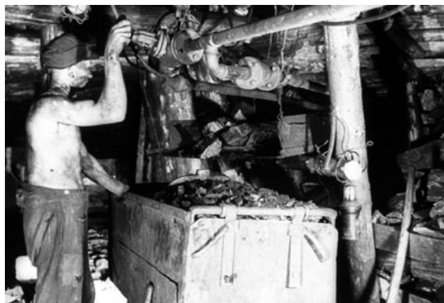
Abb. 14-13: Huntefüllung über Schüttelrutsche aus Strebbau, Rutsche Pressluftantrieb (siehe Handrad), Döhlener Hunt, Geleucht: kleine Mannschafts-lampe. Verm. 17. Sohle, Paul-Berndt-Grube, 1950; Foto: Deutsche Fotothek Nr. 104392
