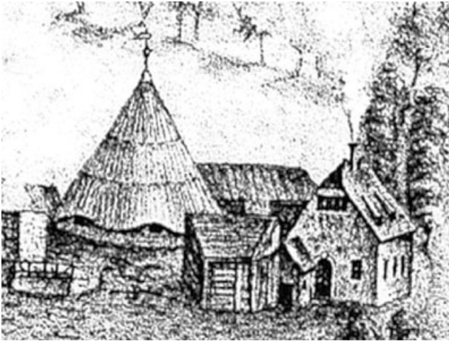
Abb. 14.4-14: Gebäudekomplex des Erdmann- oder Dampfmaschinen Schachtes (rechts), mit der Burgker Dampfmaschine, unmittelbar daneben der Göpel des Wilhelminen Schachtes. Burgker Steinkohlenwerke. Freital-Burgk, Windberg Allee; Lithographie von 1835 - Bildausschnitt, Original SSB
