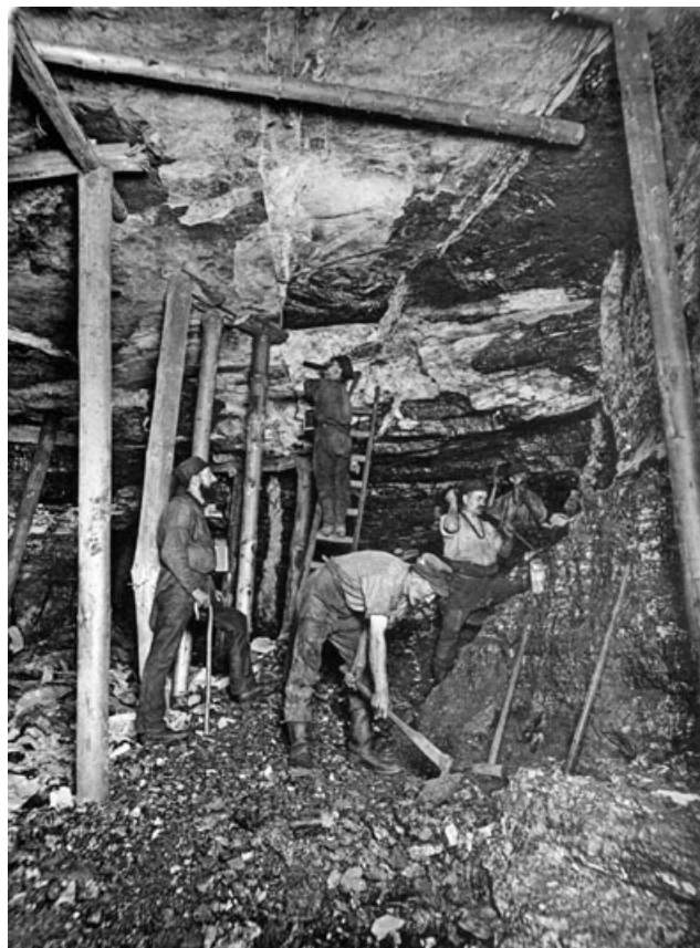
Abb. 14-23: Abbauarbeiten im tektonisch gestörtem Flöz: Bohren von Sprenglöchern, Kratzen der Masse und Sicherung der Firste durch verlorene Stempel mit Kopfpfählen und Unterzügen. Offenes Geleucht; Foto: GEORGI et al. 1894: Abb. 9
