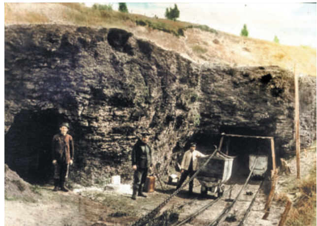
Abb. 9.2-14: Die sogen. „Seilbahn“ zwischen Marien und Glück auf Schacht am 340 m langen Horkenberg-Tunnel (ab 1928). Wegen der hohen Beanspruchung rissen die Seile und es wurden nach dem Vorbild der Döhlener Kettenberge stückweise Ketten eingefügt und die Seilstücke 1929-1930 entfernt. Foto: Autor n. bekannt, Archiv SSB
