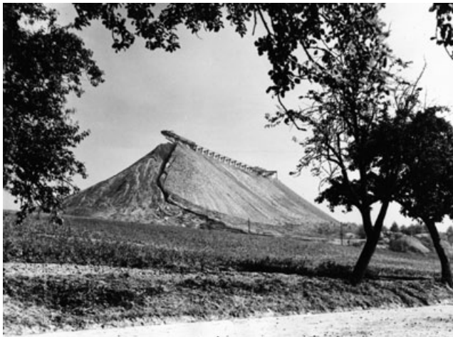
Abb. 14.4-7: Bergehalde, Blick von Süd mit Schüttstelle der Haldenseilbahn (links oben). Königin-Carola Schächte, (Paul-Berndt Grube) Freital-Döhlen, 11.09.1944; Foto: SCHULZ, Nr. 1143 bei SSB
