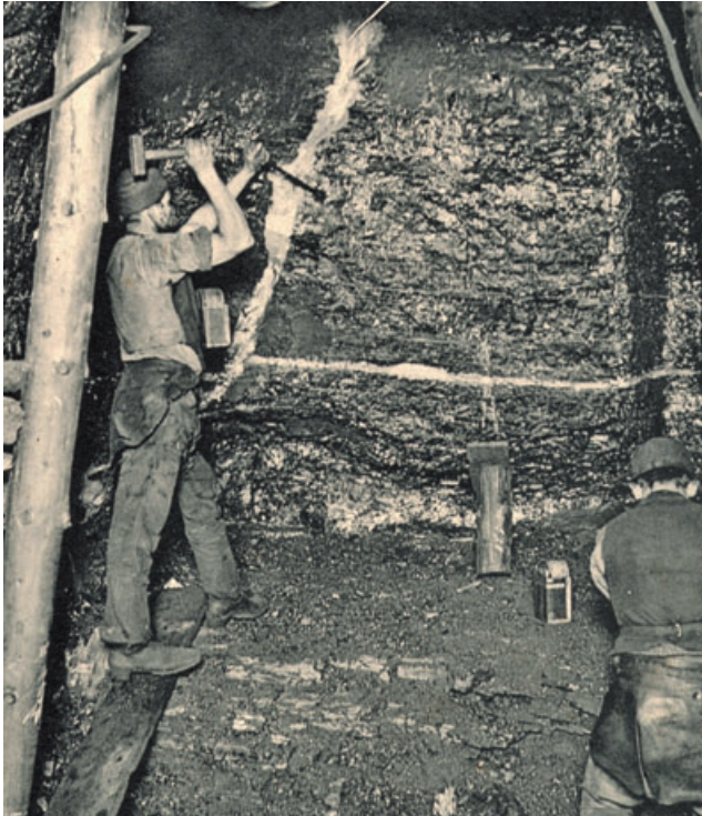
Abb. 14-14: Vortrieb einer Streichstrecke im 1. Flöz. Schaffung eines Vertikalschlitzes (Ortsbrust, rechts), den der kniende Hauer durch die noch anstehende Strosse vortreibt. Der stehende Hauer bohrt ein Sprengloch zum Abdrücken der „Oberware“ über dem Horizontalschram, im Bereich der hellen Großen Lette. Verm. Königl. Steinkohlenwerke; Foto: GEORGI et al. 1894: Abb. 7 (Ausschnitt)
