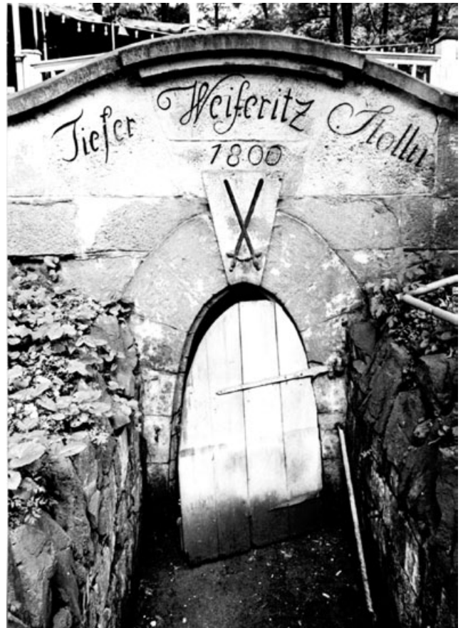
Abb. 9.2-6: Mundloch des „Tiefen Weißeritz Stolln“, Freital-Potschappel; Foto: SCHULZ, Archiv Nr. 518, Slg. REICHEL
