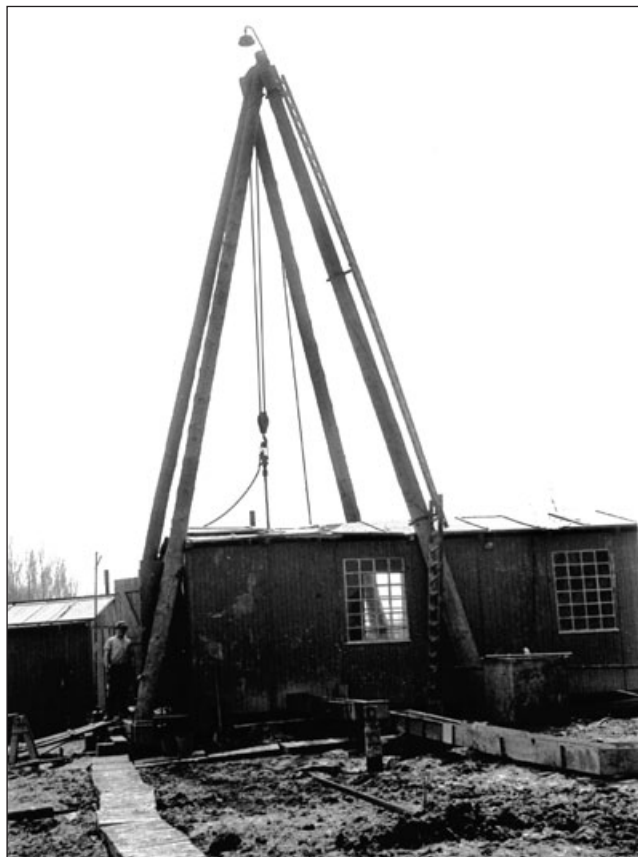
Abb. 9.2-18: Stationäre Bohranlage mit Holzvierbock als Bohrgerüst. 1958 im Gebiet Gittersee/Bannewitz; Foto: REICHEL
