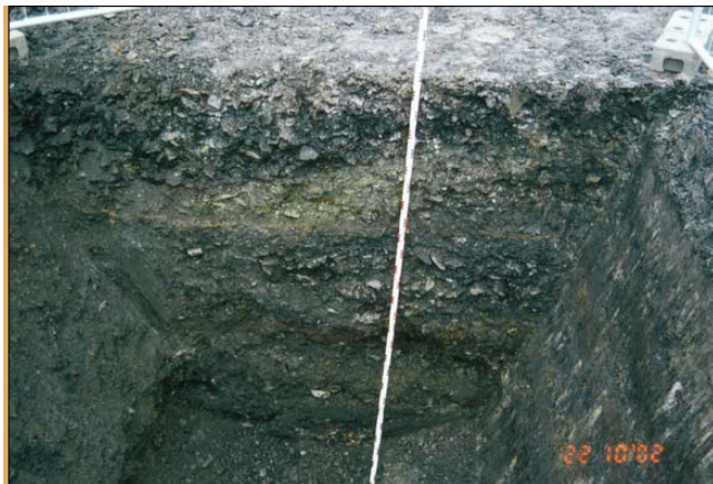
Abb. 8-6: Grob- und Waschberge, Halde Nr. 45, An der Planitzer Straße, Glückauf-Schacht (Foto: Frenzel, G.U.B. Ingenieur AG)
