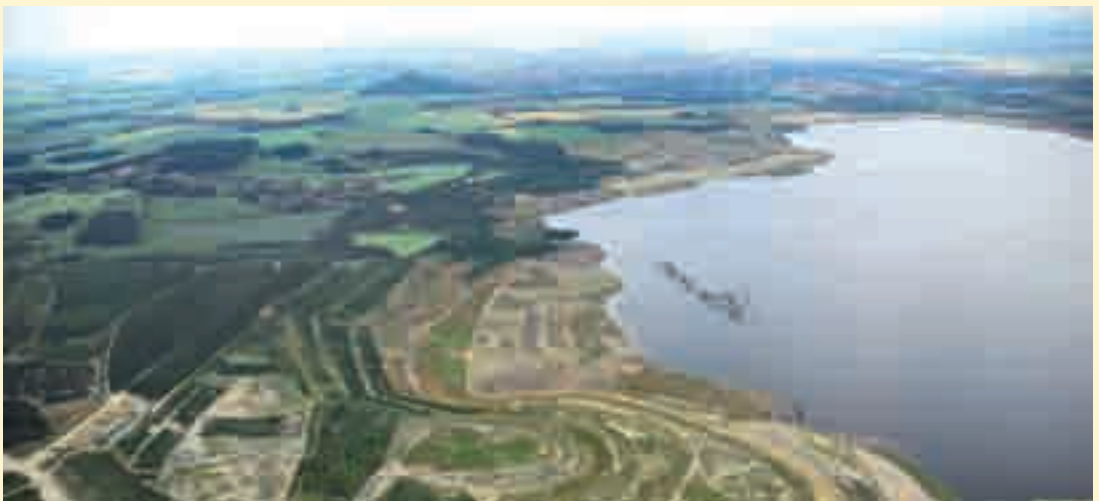
Blick von Süden auf die Rutschung P und sanierte Böschungen im ehemaligen Tagebau Berzdorf
