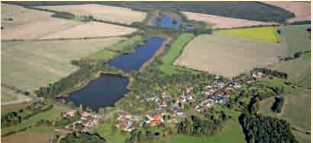
Blick von Südwesten auf Rohrbach und die Teiche
