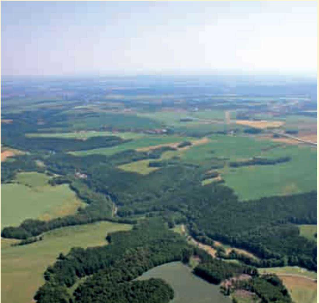
Blick von Südwesten auf das Seidewitztal, rechts die neue Autobahn A 17 Dresden-Prag
