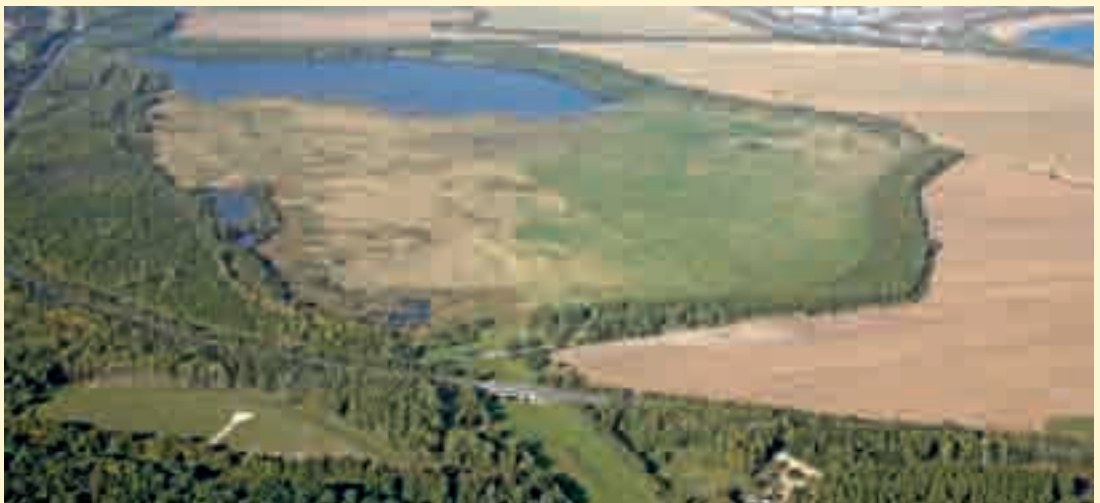
Blick von Süden auf das Rückhaltebecken Stöhma bei Normalstau
