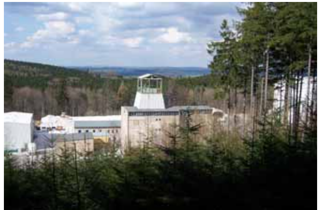
Abb. 29: Marmorwerk Lengfeld, moderne Verarbeitungsanlagen und Förderschacht 3 (Foto: G. SACHSE 2006)
