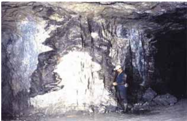
Abb. 16: Schichtaufpressung UT Kalkwerk Oberscheibe. Foto: J. KUGLER
