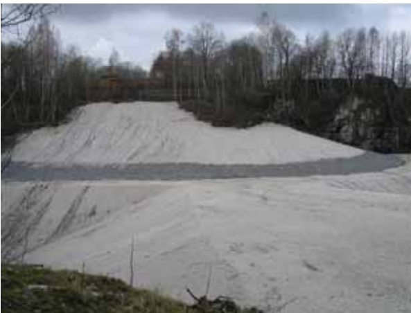
Abb. 17: Sanierter Westwand, Marmorbruch Oberscheibe 2008 (Foto: P. WOLF). Vgl. Titelbild
