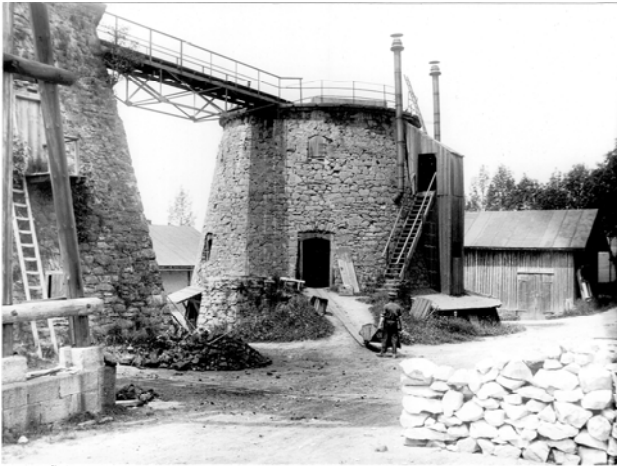
Abb. 69: Kalkwerk Hermsdorf, Generatorgas-Brennofen, Foto: Reymann 1914
