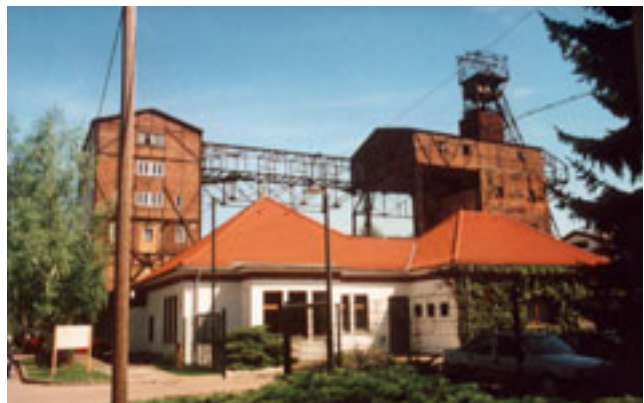
Abb. 6-2-1-1 : Förderschacht Dölitz (Gesamtansicht) (Foto: BERKNER)
