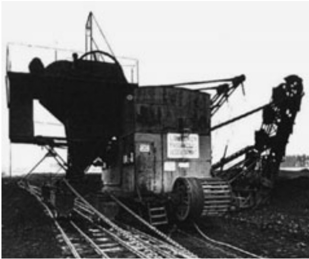
Abb. 5-2-3: LMG-Eimerkettenbagger mit Raupenfahrwerk in der Grube Kraft I im Einsatz (1920) (Foto: Archiv KAPPLER)
