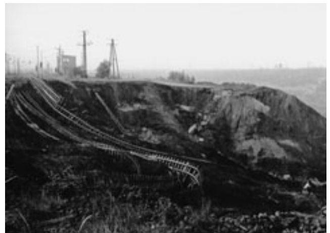
Abb. 2-3-5: Tagebau Zwenkau, Stellwerk 101, Rutschung vom 03.08.1978
