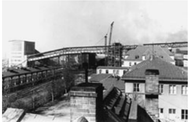
Abb. 5-3-10: Bau der Bandstraße über die Reichsbahnstrecke Leipzig – Altenburg – Zwickau/Plauen (Foto: Archiv BRÄUTIGAM)
