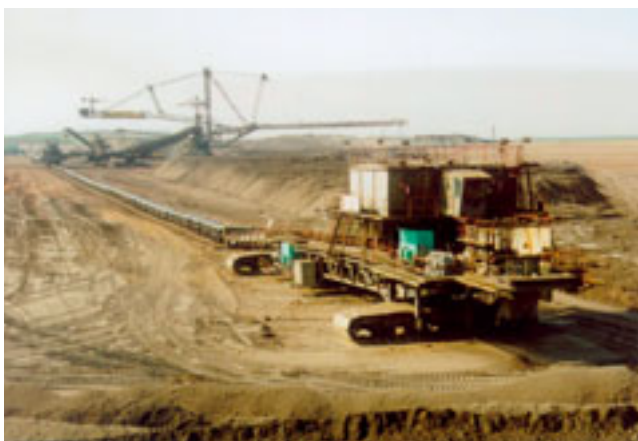
Abb. 5-2-49: Bandantriebsstation im Tagebau Espenhain
