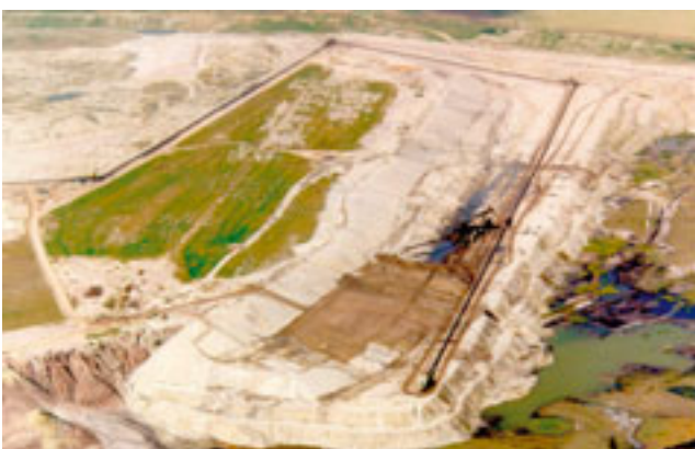
Abb. 5-2-52 : Stützdammerschüttung Innenkippe Peres
