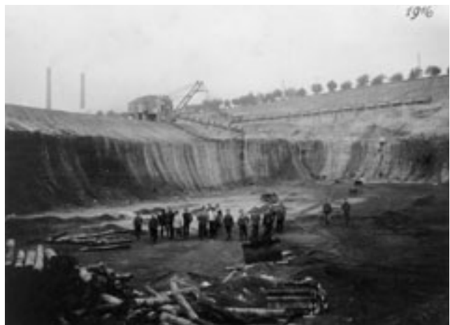
Abb. 5-2-4: Kohlefreilegung durch Abraumbagger mit ungeführter Eimerkette im Tagebau Borna-Nord (1916). Zu erkennen ist auch der Einsatz von Kriegsgefangenen (Bewachung mit aufgepflanztem Bajonett) (Foto: Archiv KAPPLER)
