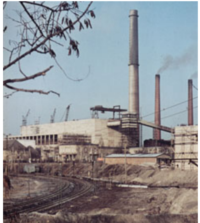
Abb. 5-4-2: Kraftwerk Borna in der Rekonstruktionsphase 1963...66
