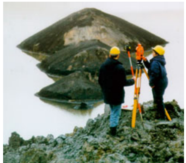
Abb. 7-3-16: Vermessungsarbeiten mittels vollautomatischem Tachymeter (Totalstation) an der Südböschung des in Flutung befindlichen Tagebaus Witznitz
