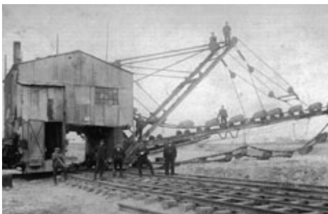
Abb. 4-5-5: Bagger mit Dampfantrieb (um 1900) (Foto: Archiv BRÄUTIGAM)
