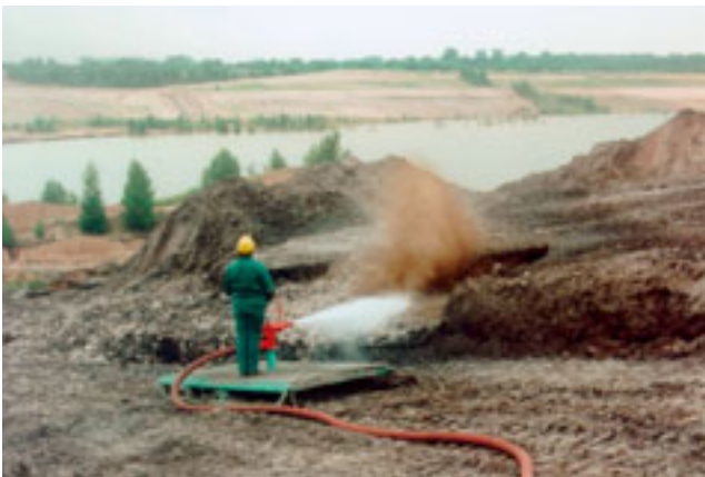
Abb. 5-2-51 : Böschungregulierung durch Abspülen im Südostbereich Tagebau Cospuden
