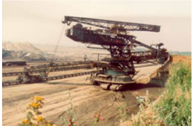
Abb. 5-2-39: Bagger 1522 SRs 1300 im 1. Abraumschnitt Tagebau Cospuden
