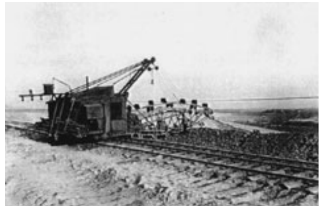
Abb. 5-2-2: Der Uehlein-Absetzer; erster Absetzer-Typ im Tagebau Marie I im Einsatz (1918) (Foto: Archiv KAPPLER)
