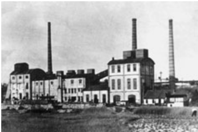
Abb. 4-6-2: Brikettfabrik „Germania“ bei Gorma (Foto: Archiv BRÄUTIGAM)
