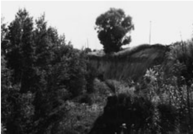
Abb. 2-3-10: Restloch Absetzer 13 im Tagebaubereich Böhlen (Zwenkau), Rutschung vom 02.09.1983
