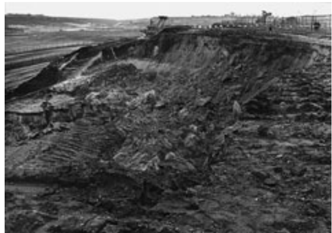
Abb. 2-3-6: Tagebau Groitzscher Dreieck, 2. Abraumschnitt, Rutschung vom 12.10.1982 auf VG Haselbacher Ton
