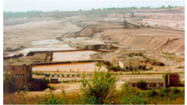
Abb. 5-2-53 : Anstützung der setzungsfließgefährdeten Innenkippe im Tagebau Grotzischer Dreieck
