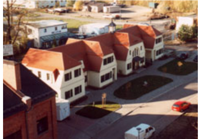
Abb. 6-2-5-3: Verwaltungsgebäude der Bleichertschen Kohlenwerke nach der Sanierung
