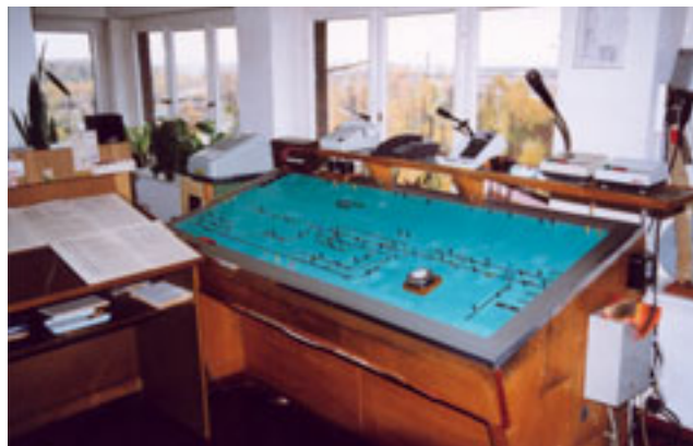
Abb. 5-6-8: Stellwerkstisch, Bauform II-JB (Foto: KIRCHHÜBEL)
