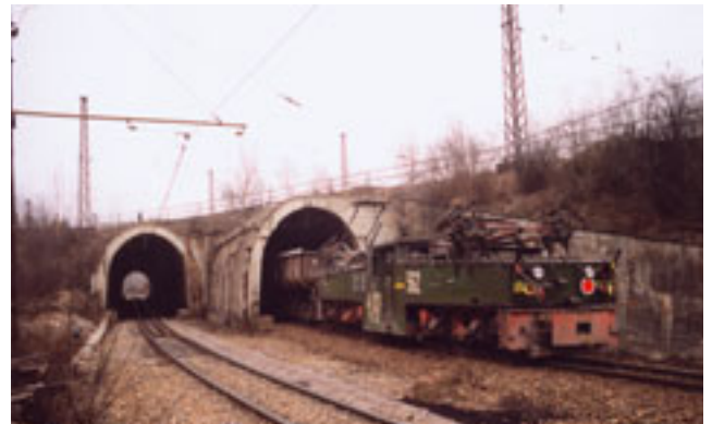
Abb. 5-6-13: Kreuzungsbauwerk Tagebau Zwenkau 1996 (Foto: NEDDERMEIER)
