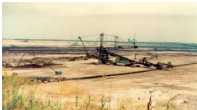
Abb 5-2-36: Innenkippe Tagebau Peres
