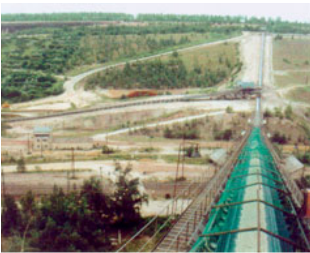
Abb. 5-2-42: Querung Niederfahrt 1:36 mit Gurtbandförderer 3 im Tagebau Espenhain
