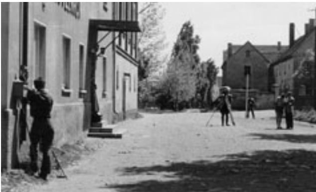
Abb. 7-3-5: Präzisionsnivellement mit zwei Instrumenten im Jahr 1959
