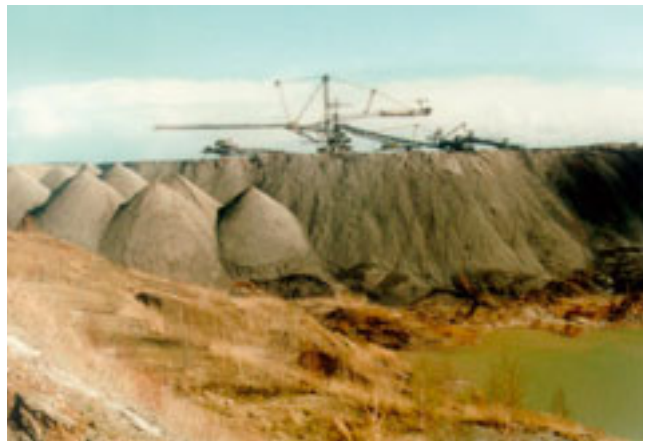
Abb. 5-2-59/-60 : Pionierdammschüttung für die Landbrücke zwischen dem künftigen Markkleeberger und Störmthaler See mit Absetzer 1115
