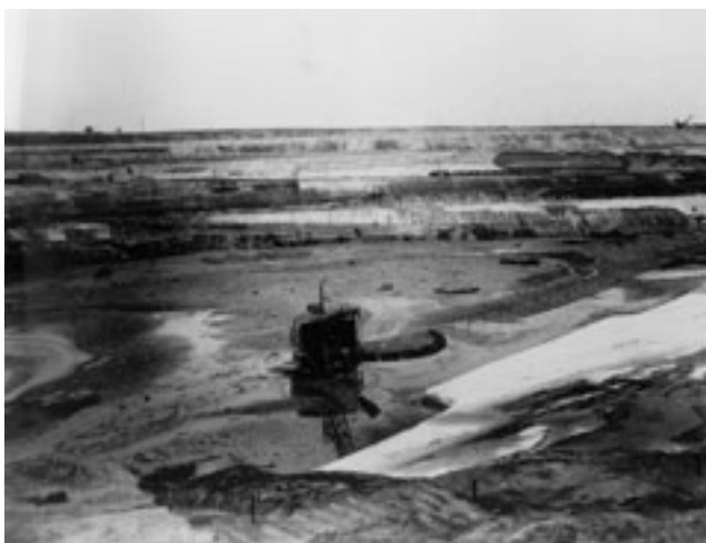
Abb. 5-2-15: D 500 beim Aufschluss des Tagebaus Böhlen im Schlamm der ausgelaufenen Ringspülkippe (1927) (Foto: Archiv WINKLER)
