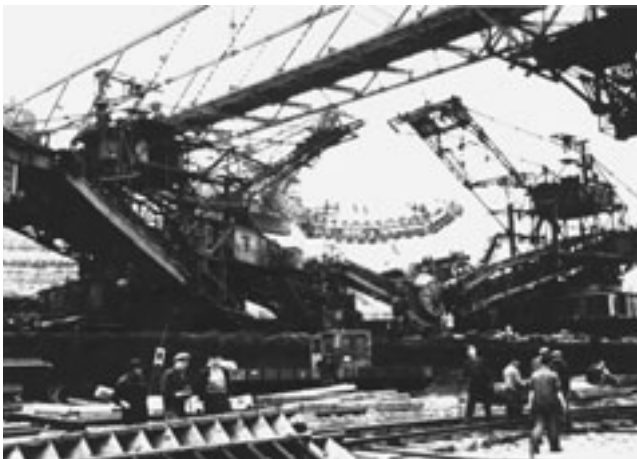
Abb. 5-2-20: Umbausituation beim „Sprung der Mittelstütze durch das Mittel“ (1962) (Foto: SCHUBERT)
