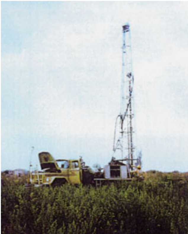
Abb. 2-2-2: Rotarybohrgerät bei Markkleeberg-Zöbiger im Tagebaubereich Cospuden
