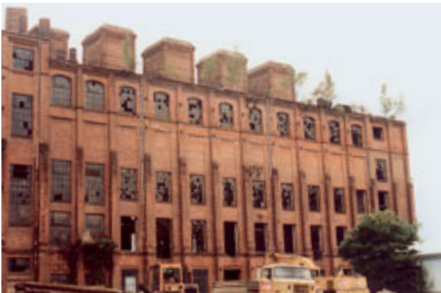
Abb. 6-2-5-2: Pressenhaus – Bauzustand vor der Sanierung ca. 1995
