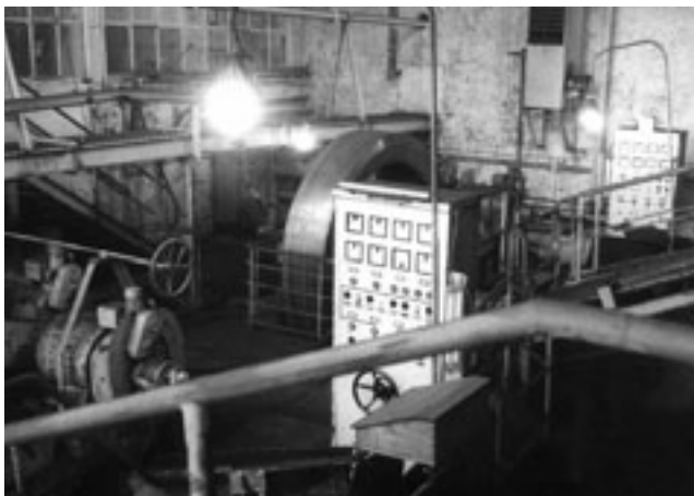
Abb. 5-3-9: Ringwalzenpressenhaus der Brikettfabrik Deutzen (Foto: Archiv BRÄUTIGAM)
