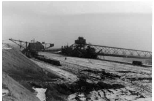
Abb. 5-2-11: Ds 635 Krupp mit Baggerstütze AFB 18 im Tagebau Böhlen (1957) (Foto: SCHUBERT)
