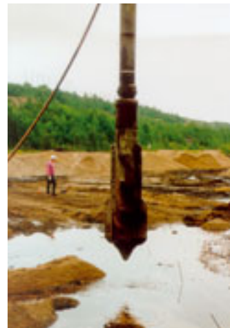
Abb. 5-2-54 : Rütteldruckverdichtung AFB-Kippenfuß Tagebau Espenhain
