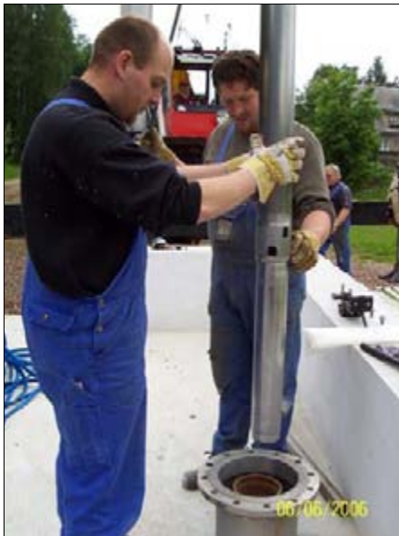
Abb. 7: Einbau der Pumpe in die GrWM I
