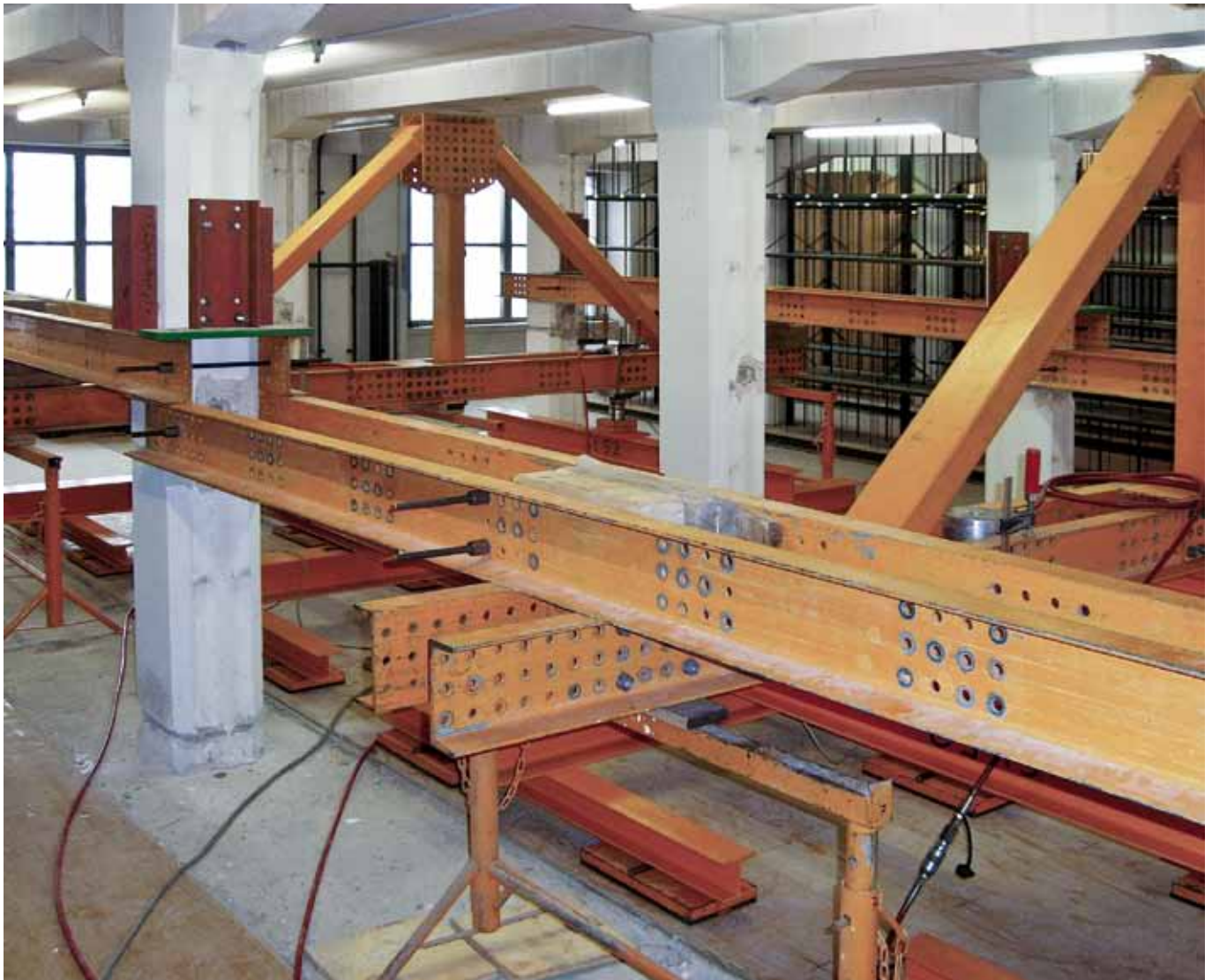
Probebelastung einer vorhandenen Decke zur Ermittlung der Tragfähigkeit
