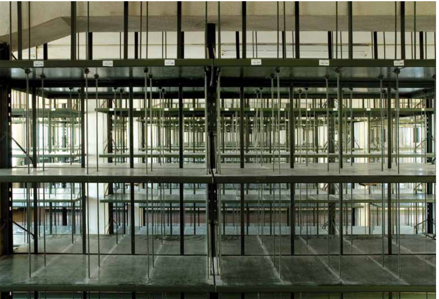
Regalanlage von 1915 im Magazinaltbau vor der Aufarbeitung
