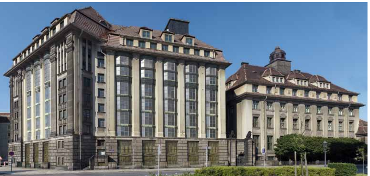
Die beiden historischen Gebäude des Hauptstaatsarchivs vor der Sanierung
