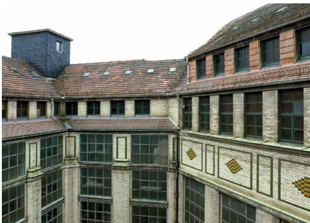
Der Lichthof des Magazinalbaus vor der Sanierung
