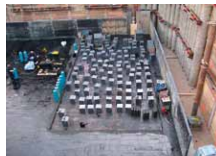
Verlegung der Dämmung unterhalb der Bodenplatte, die Baugrubensohle liegt 10 Meter unter Straßenniveau.
