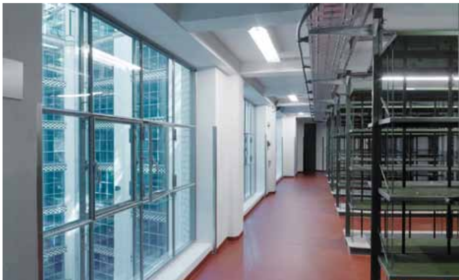
Fenster eines Archivrums an der Lichthoffassade, rechts vor und links nach der Sanierung, die historischen Fenster wurden erhalten
