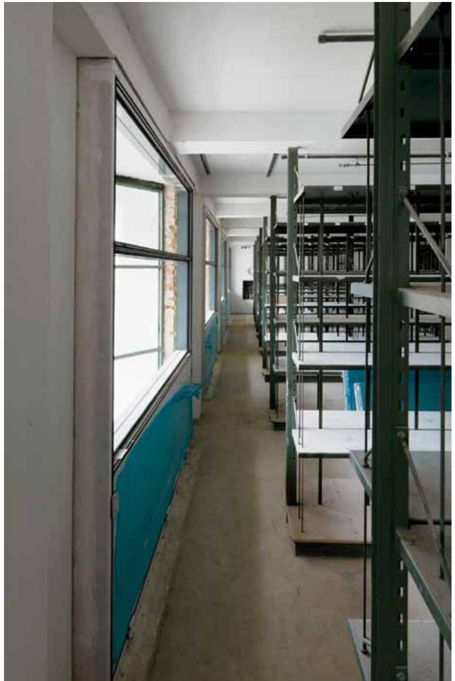
Einbau der Dämmebene auf der Rauminnenseite der Fenster der Außenfassaden
