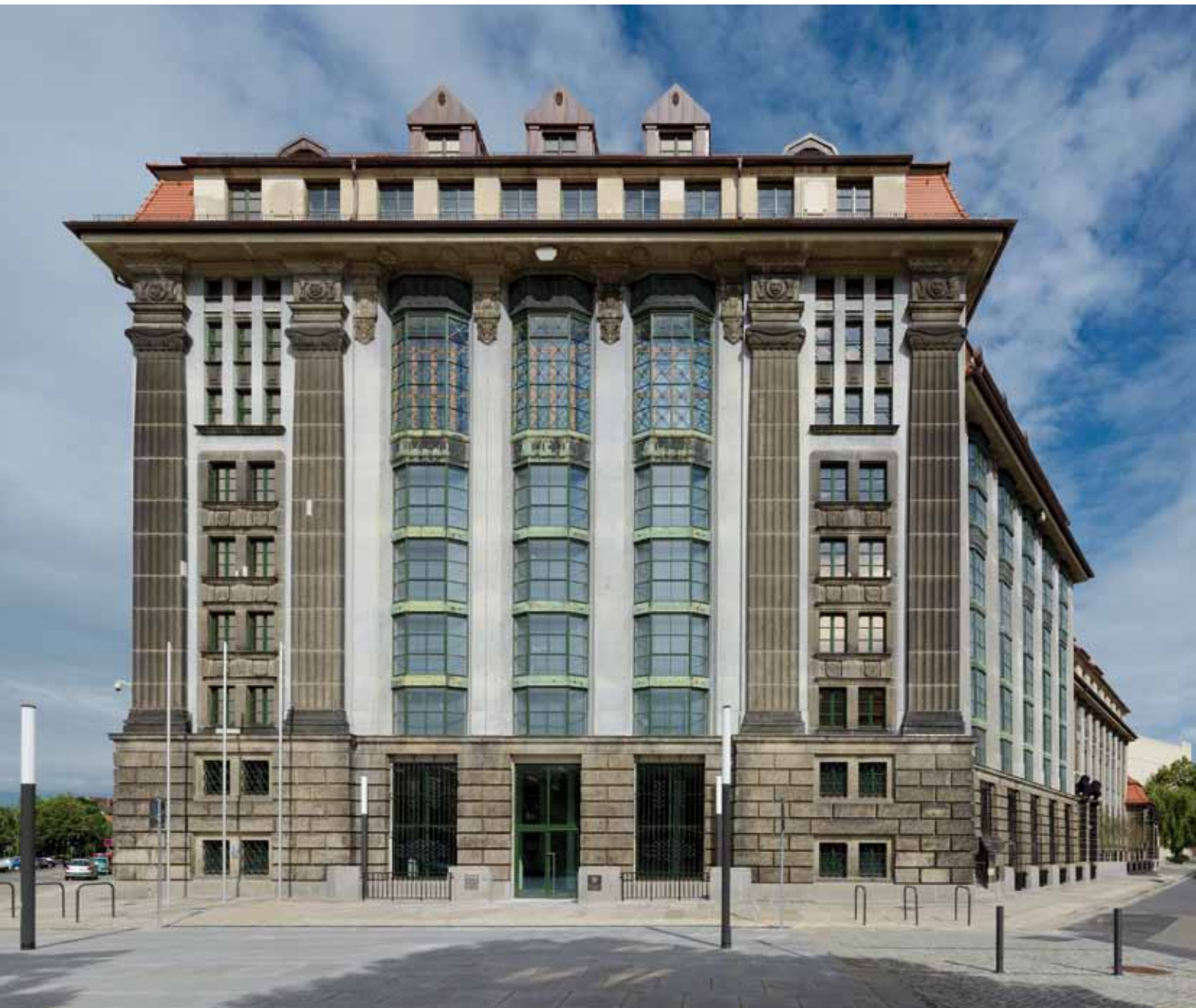
Das historische Magazingebäude nach der Sanierung mit neu geschaffener Eingangssituation zum früheren St. Privat- und zukünftigen Archivplatz
