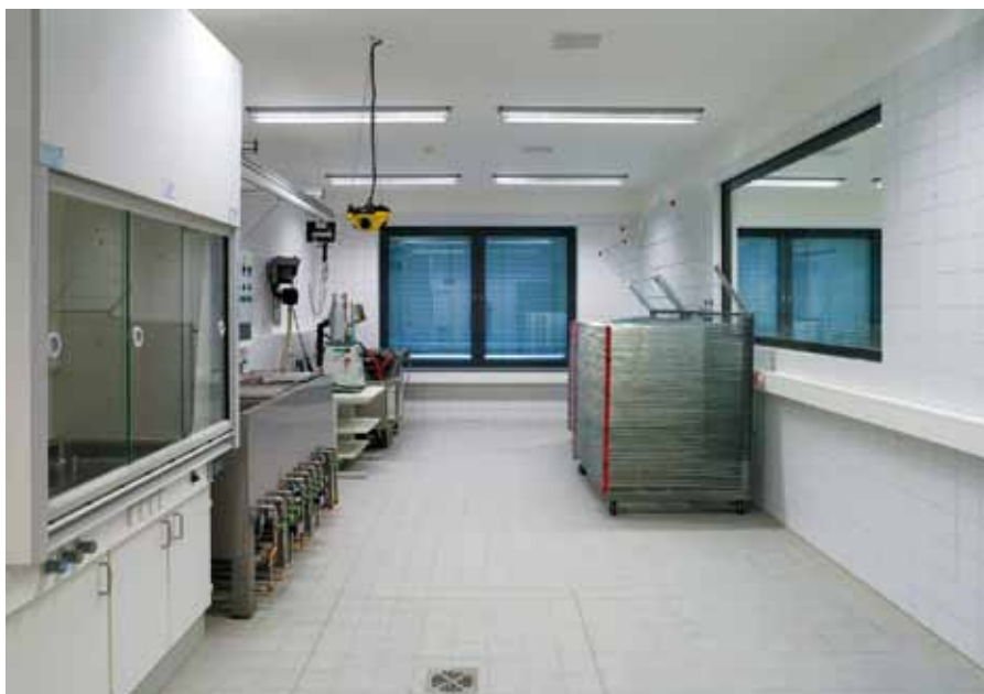
Werkstattbereich des Archivneubaus mit Laboreinrichtungen zur Papierbearbeitung
