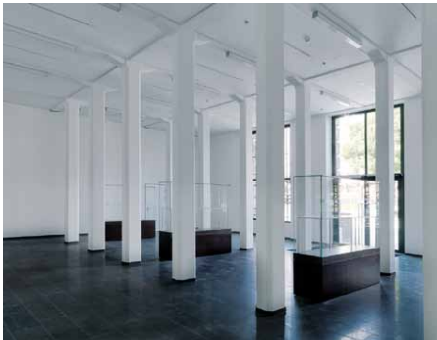
Für das neue zweigeschossige Eingangsfoyer wurden die Decke entfernt und neue durchgehende Stützen eingebaut.
