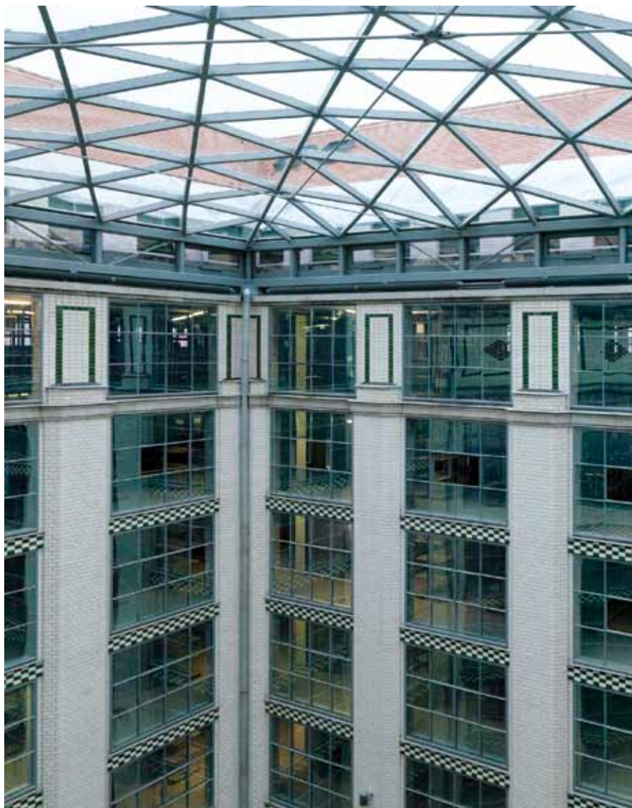
Durch die neue Glasdachkonstruktion erhält der historische Magazinbau ein zentrales Atrium.
