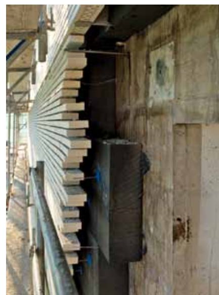
Die Fassade während der Bauphase
