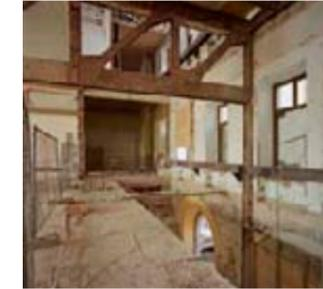
Bereich des jetzigen Lastenaufzugs. Der Abbruch für den Aufzugschacht förderte die unterschiedlichen Zeitschichten zutage.
