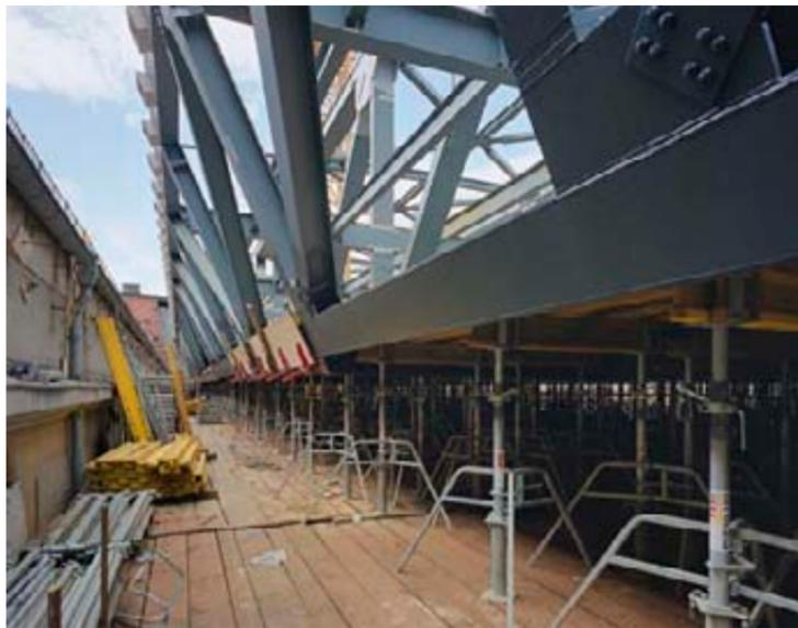
Bereich des unteren Gurts – spätere Lichtfuge des Innenhofs, die Teleskopstützen dienten dem Einbau der unteren Decke (Gemäledepot).
