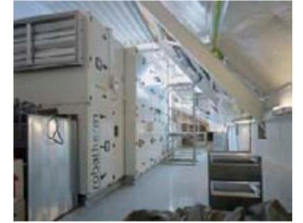
Die Technikanlagen befinden sich in den Bereichen des Altbaudaches. So kann das Volumen des Neubaus ausschließlich für die Deponierung genutzt werden.
