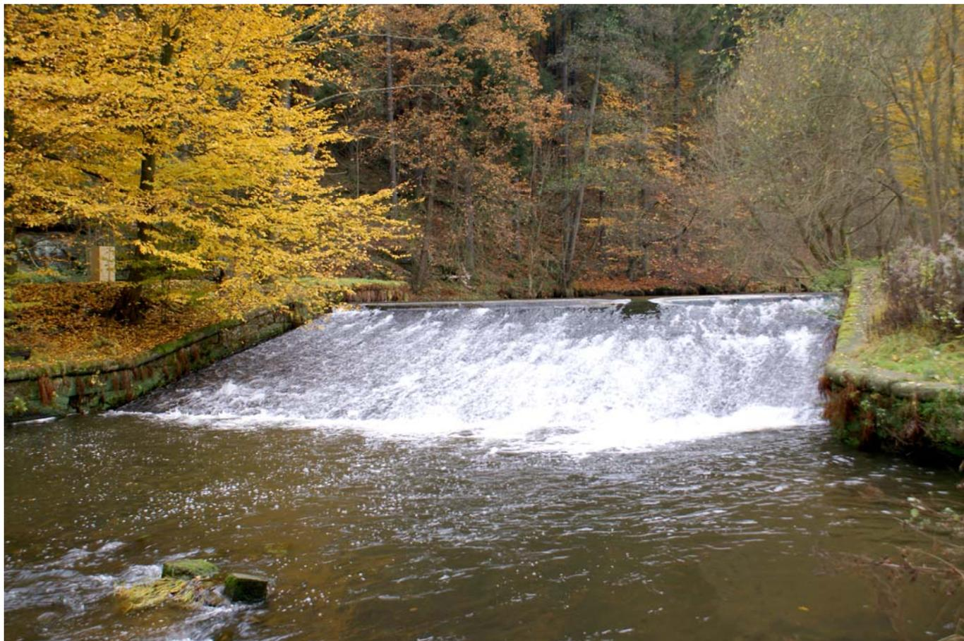
**Bild 3.1: Streichwehr mit Schlauchaufsatz oberhalb der WKA und Beginn des Anstaukanals**
