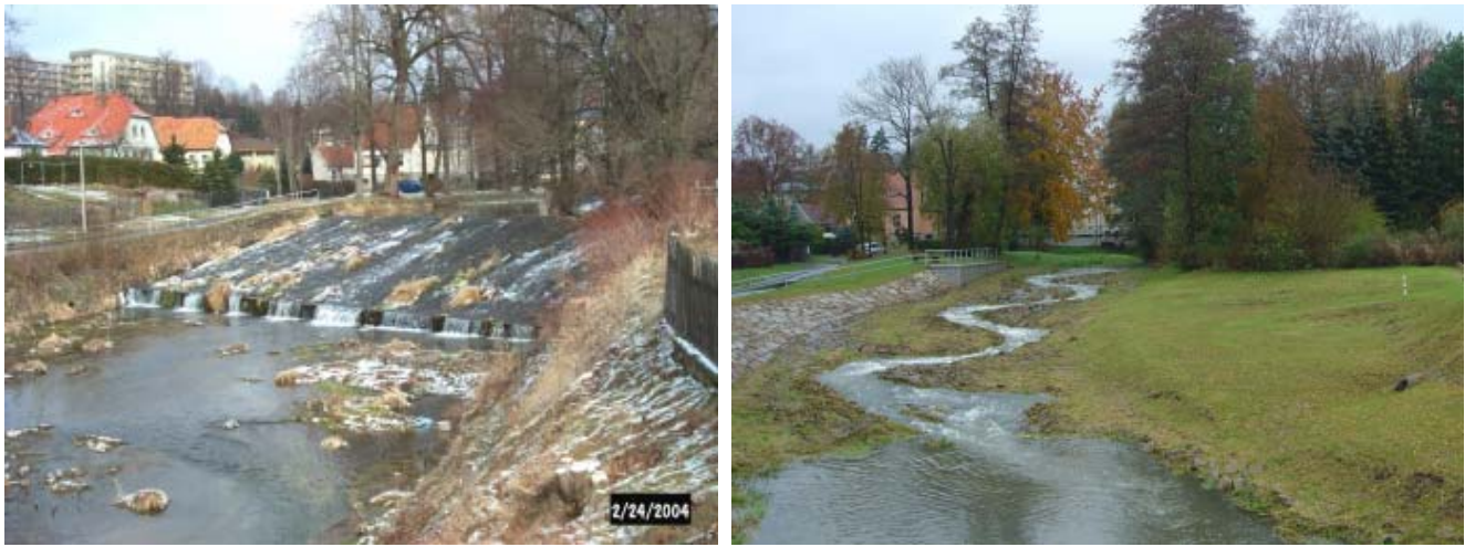
Abbildung 21: Gewässeraufweitung und Umbau Kirchwehr an der Pließnitz in Bernstadt (Landestalsperrenverwaltung)
