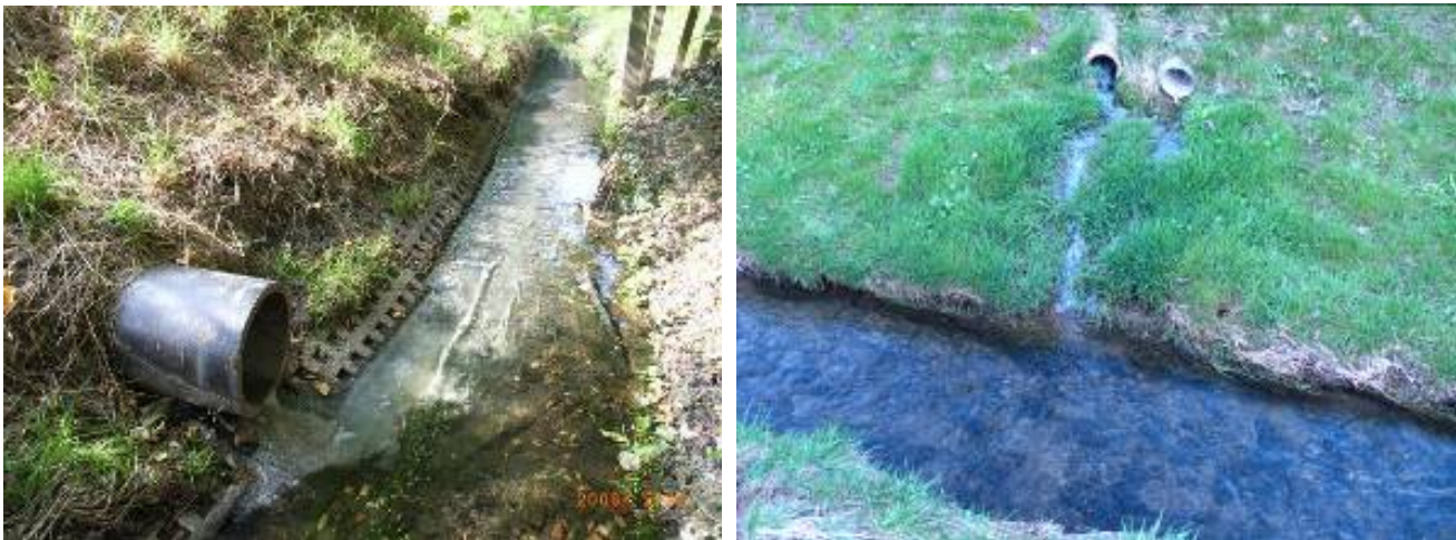
Abbildung 7: Abwassereinleitungen in Oberflächengewässer
