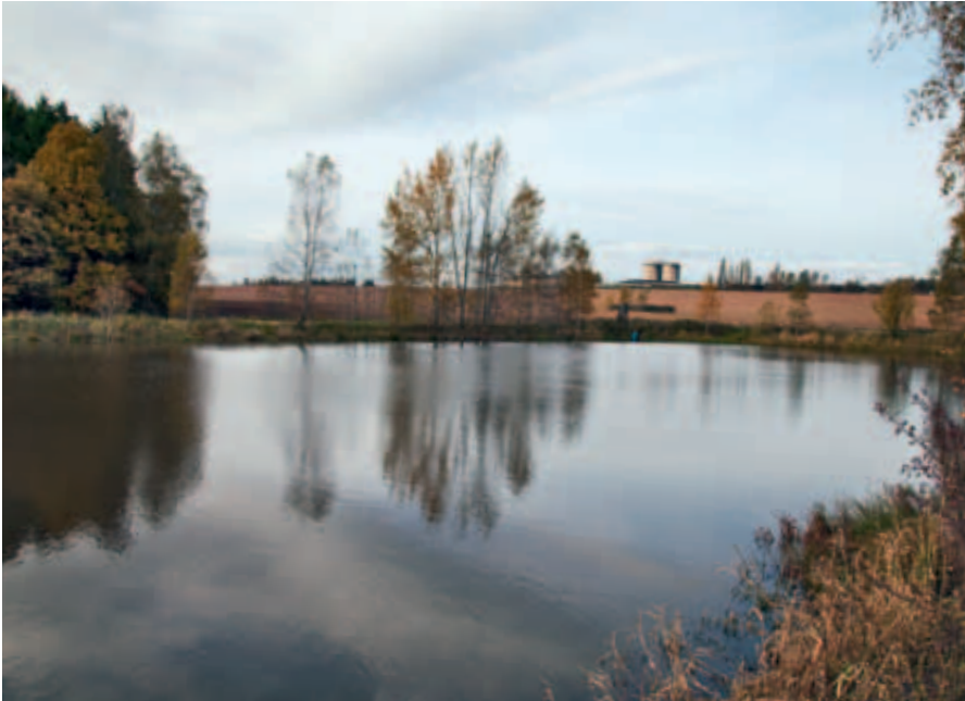
Absetzteich, Im Hintergrund sind die Anlagen der »MAVEK« eG zu sehen.
