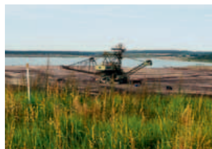
Absetzer im Tagebau »Haselbach III« während der Sanierungsarbeiten 1995 Foto: LMBV
