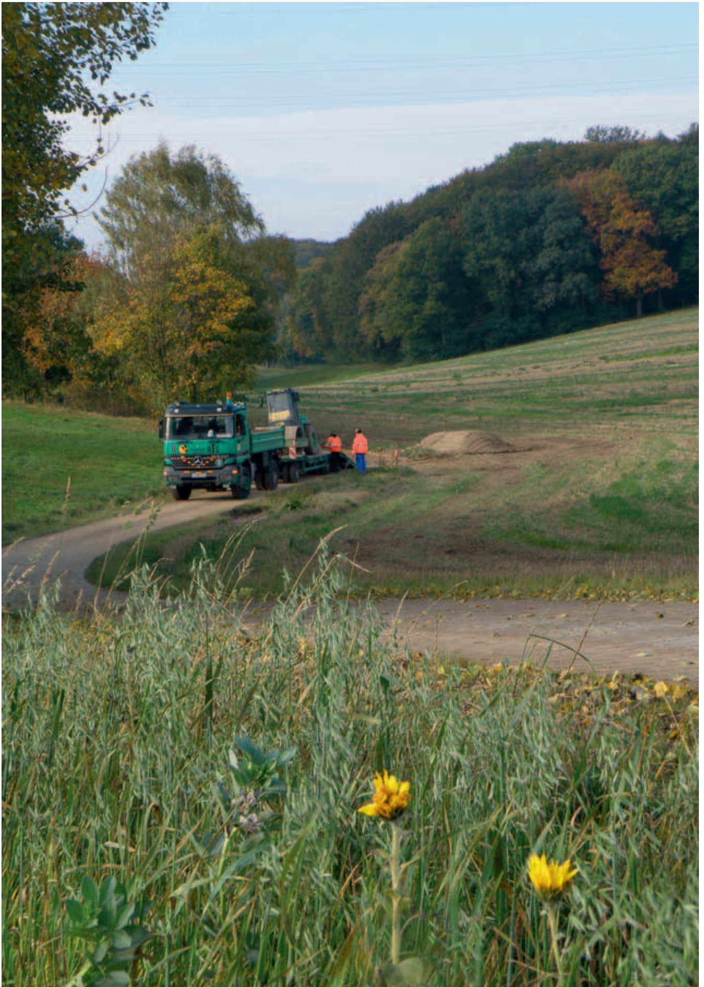
Bau eines ländlichen Weges in der Flur Schönberg
