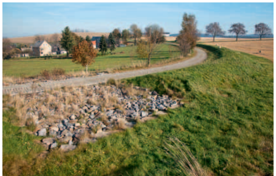
Fertig gestellter Hochwasserrückhaltedamm mit Dammscharte und Wirtschaftsweg – Einzugsgebiet A1. Im Hintergrund ist die zu schützende Ortslage zu sehen.
