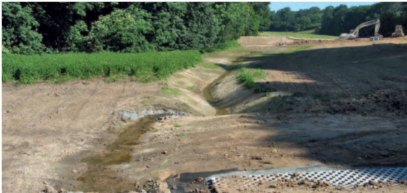
Naturnahe Neugestaltung des Ziegenbachgrundes; Foto: Teilnehmergeinschaft Zschadraß (Hochwasser-) Muldedörfer
