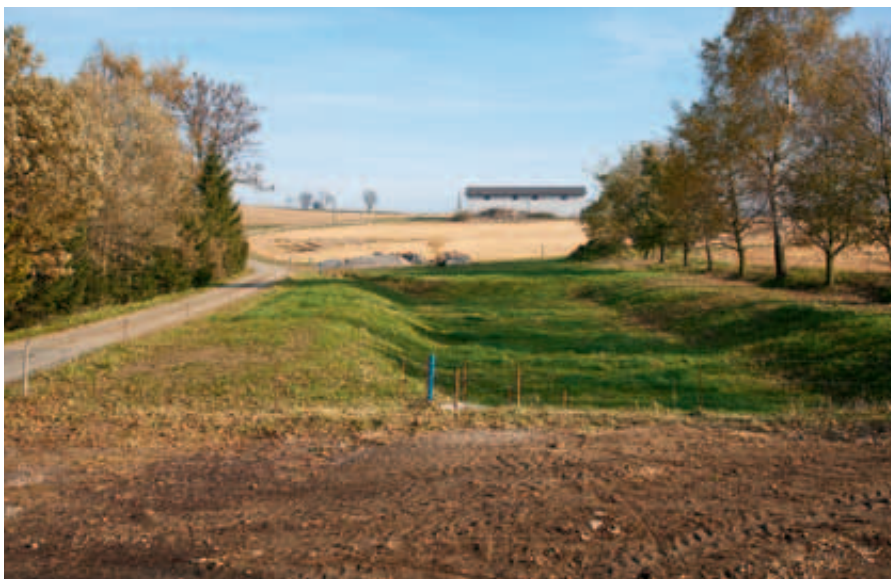
Fertig gestelltes Hochwasserrückhaltebecken – Einzugsgebiet A 2
