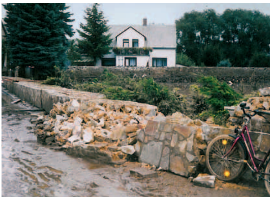
Verwüstung der Ortslage Podelwitz im August 2002 Foto: Teilnehmergemeinschaft Zschadraß (Hochwasser-) Muldedörfer
