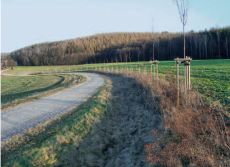
Bräunecker Weg nach der Fertigstellung; Foto: Dr. Gunter Möbius
