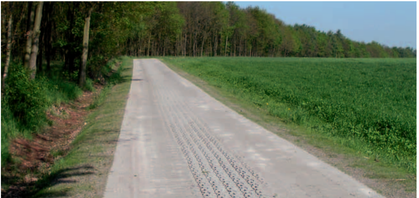
Ausgebauter Pflasterweg im Flurbereinungsverfahren Reichenbach-Falken; Foto: Teilnehmergeinschaft Reichenbach-Falken
