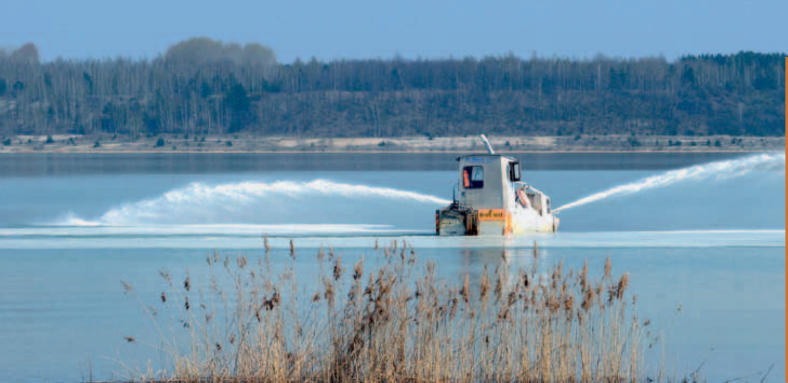
Sanierungsschiff auf dem Haselbacher See; Foto: LMBV
