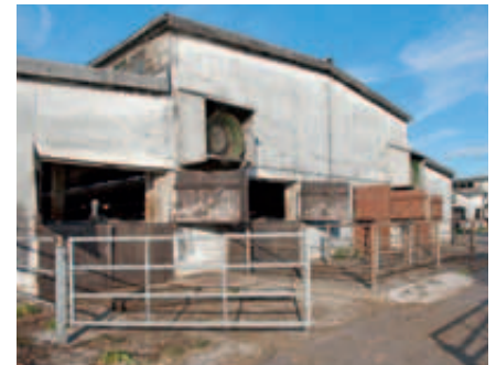
Stallanlage auf dem Betriebsgelände der »MAVEK« eG
