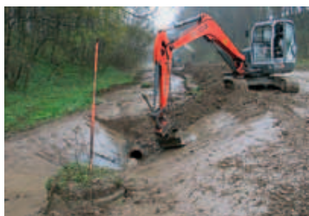
Offenlegung verrohrter Abschnitte des Baches Foto: Teilnehmergeinschaft Zschadraß (Hochwasser-) Muldedörfer
