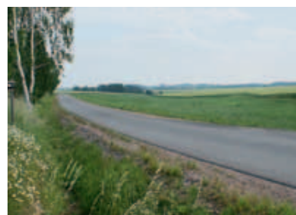
»Plattenweg II« - Abschnitt mit Asphaltdecke
