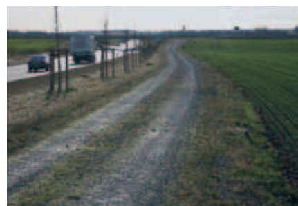
Anlage eines neuen Erschließungsweges parallel zur Ortsumfahrung Foto: Teilnehmergeinschaft S 177 OU Radeberg / Großberkmannsdorf
