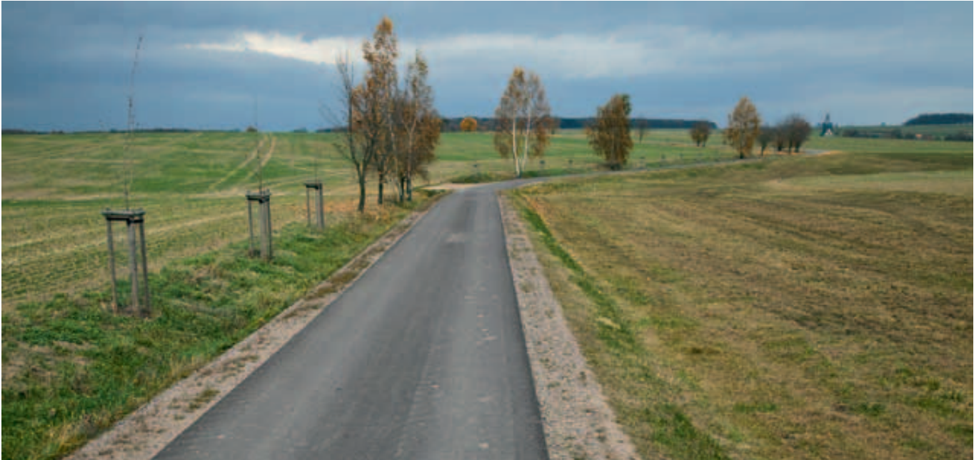
Asphaltierter ländlicher Weg in der Flur von Erlau
