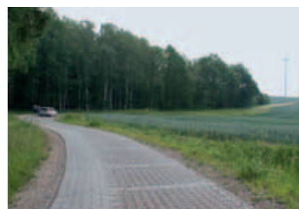
»Südlicher Querweg« - Abschnitt mit einer Pflasterdecke aus Betonsteinen
