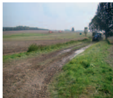
»Stichweg« vor dem Ausbau Foto: Teilnehmergemeinschaft Crossen
