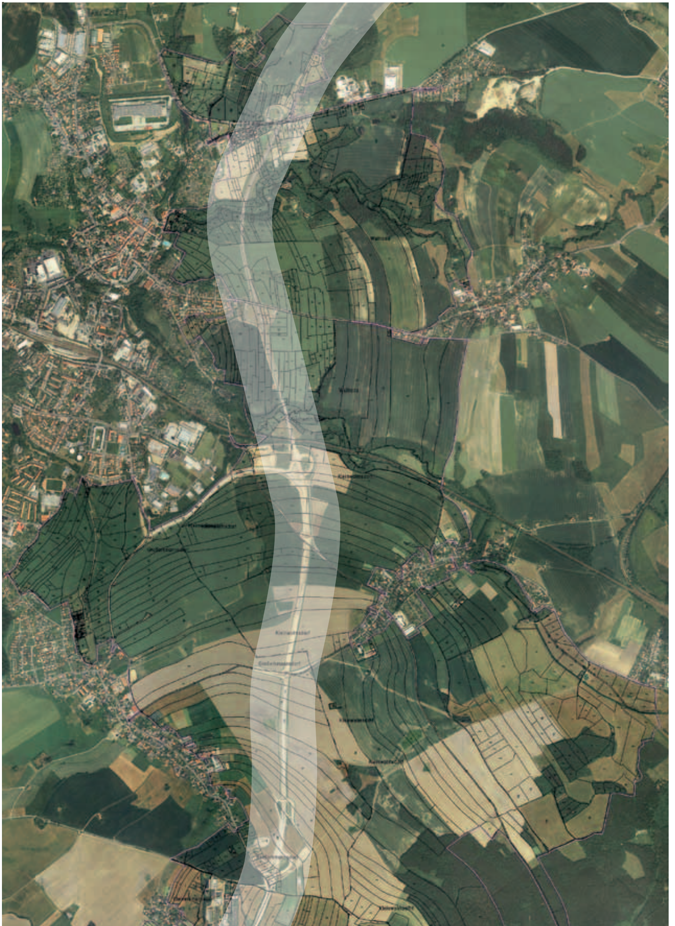
Ausschnitt aus dem Flurbereinigungsgebiet mit der im Bau befindlichen Ortsumfahrung und dem zu diesem Zeitpunkt aktuellen Flurstückszuschnitt Quelle: Teilnehmergeinschaft S 177 OU Radeberg / Großbermannsdorf
