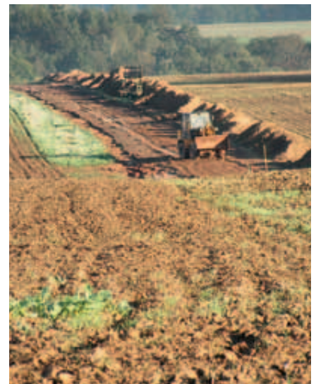
Bau eines ländlichen Weges im der Flur Langenhessen Foto: Teilnehmergeinschaft Langenhessen
