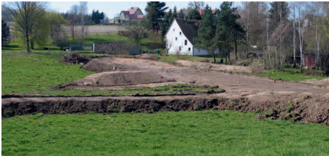
Anlage von Hochwasserschutzdämmen oberhalb der Ortslage Podelwitz; Foto: Teilnehmergemeinschaft Zschadraß (Hochwasser-) Muldedörfer
