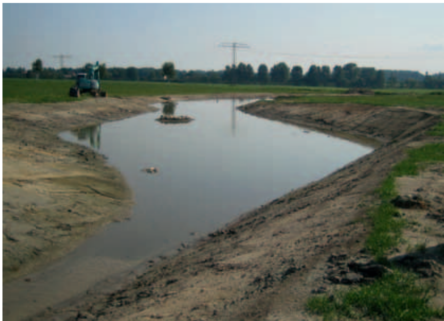
Im Bau befindliche Wasserrückhaltefläche; Foto: Teilnehmergeinschaft S 177 OU Radeberg/Großberkmannsdorf
