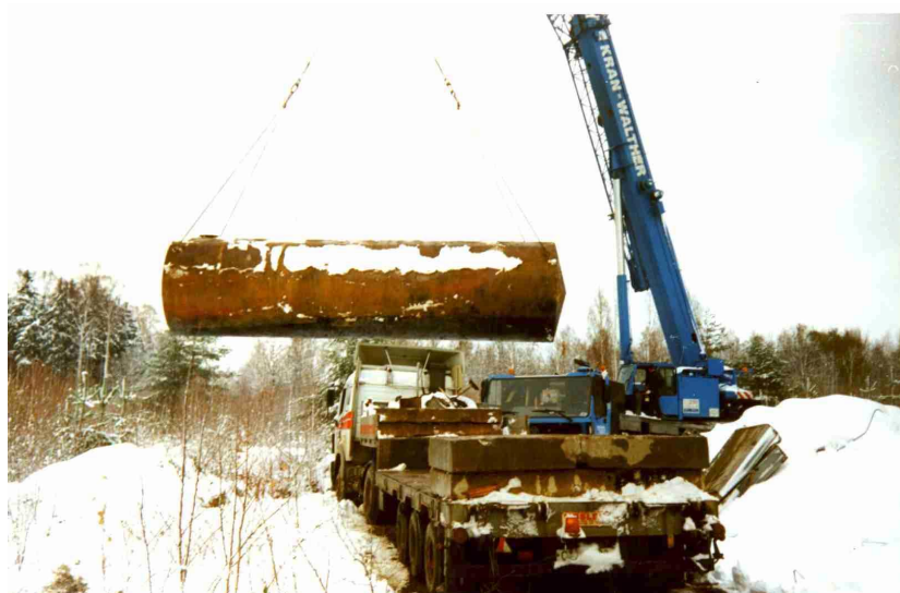
Bergungsmaßnahme (64 m 3 ) und Verladung zur Verschrottung
