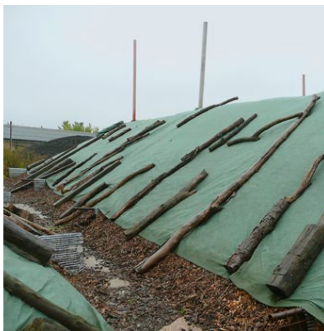
Abbildung 46: Dombelüftungsverfahren mit Abdeckvlies
