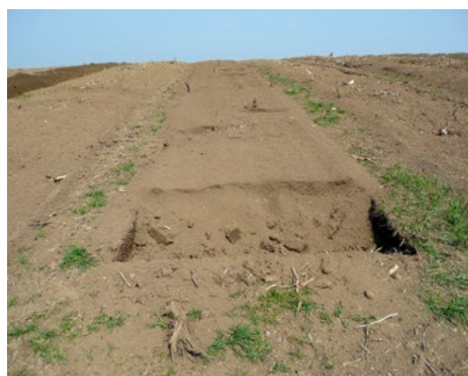
Abbildung 53: Einsatz der Rodefräse zum Zerkleinern der Wurzelstöcke bis 30 cm Tiefe, Arbeitsrichtung Gleichlauf
