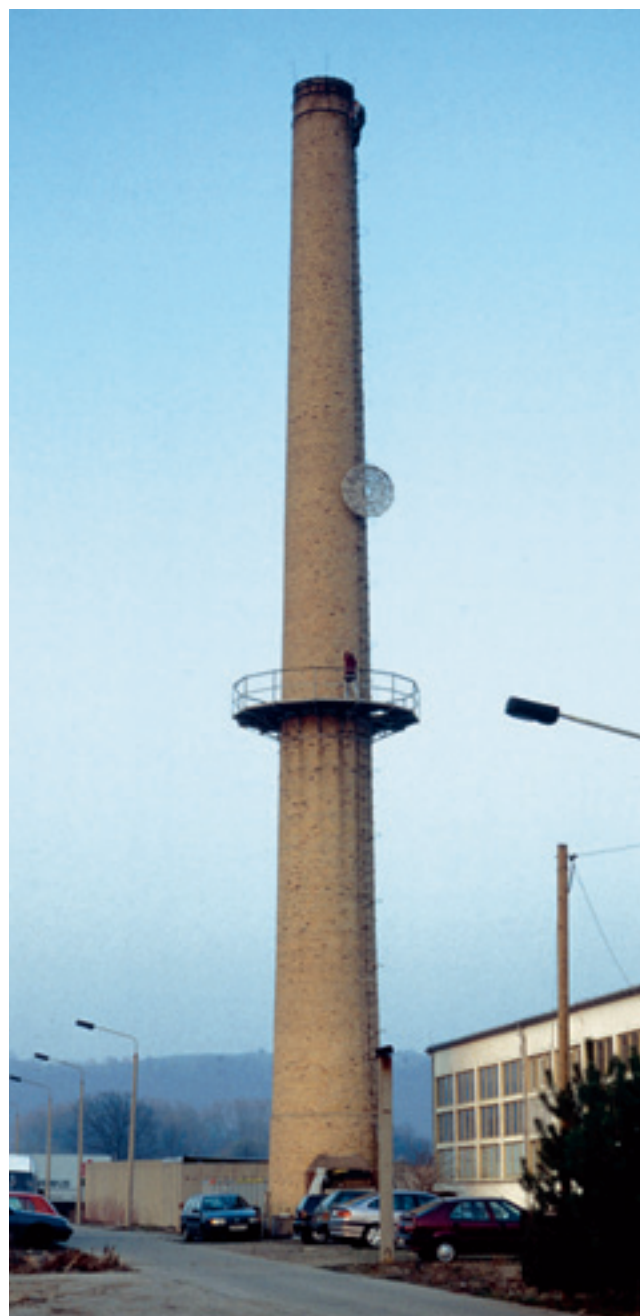
Abb. 78: Anbringen einer Nestunterlage auf einem Schornstein durch zwei Bergsteiger; 1997, Dresden-Leuben Foto: S. Teschner
