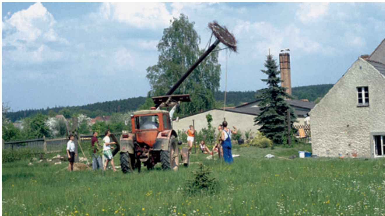
Abb. 87: Errichtung einer Nisthilfe; auf dem Schornstein im Hintergrund „wartet“ das Brutpaar, das 1993 auf der neuen Nisthilfe 2 Junge aufzog; 02.05.1993, Großdittmannsdorf Foto: M. Schrack
