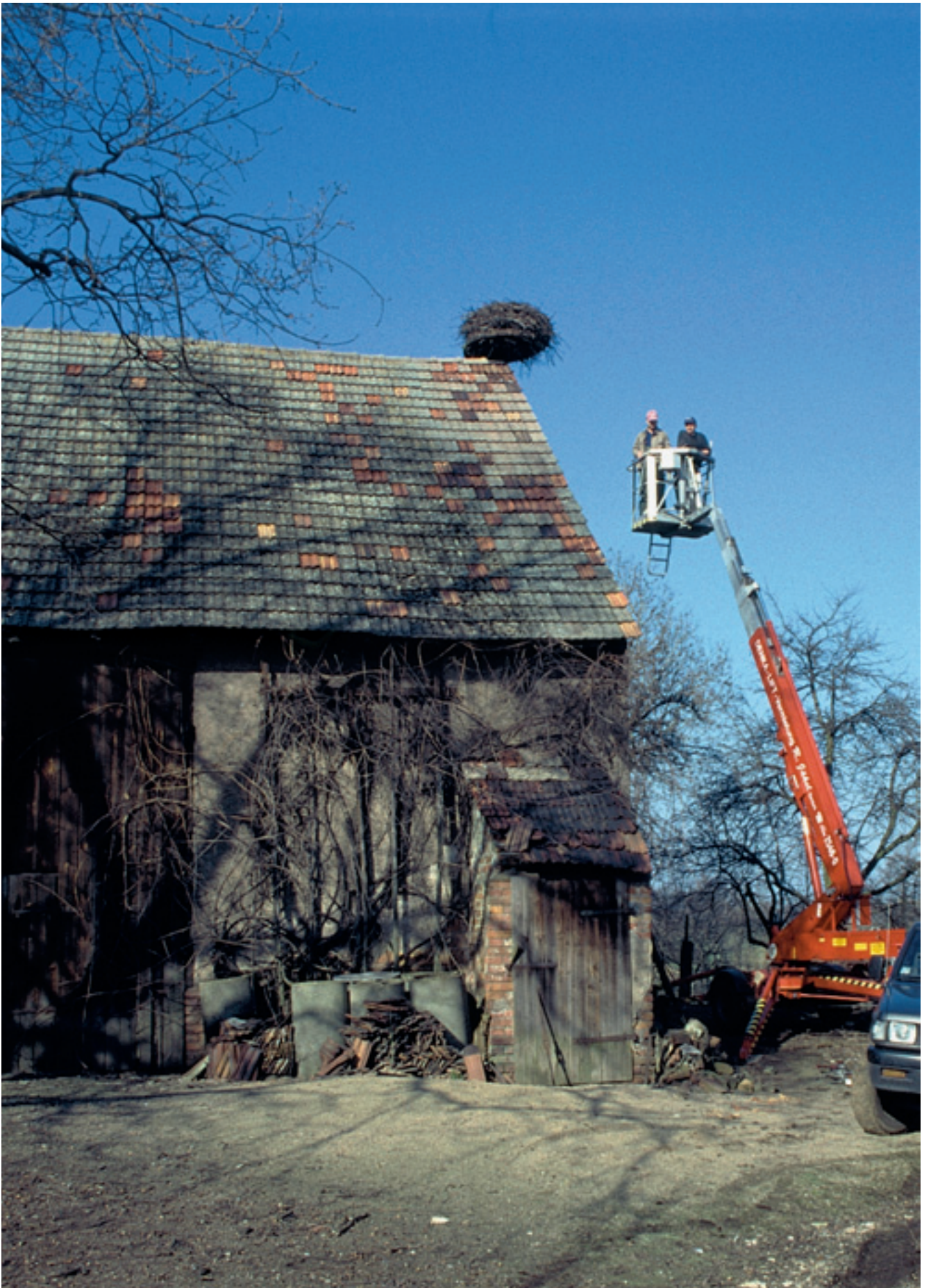
Abb. 101: Nestsanierung; März 1993, Zodel, NOL
