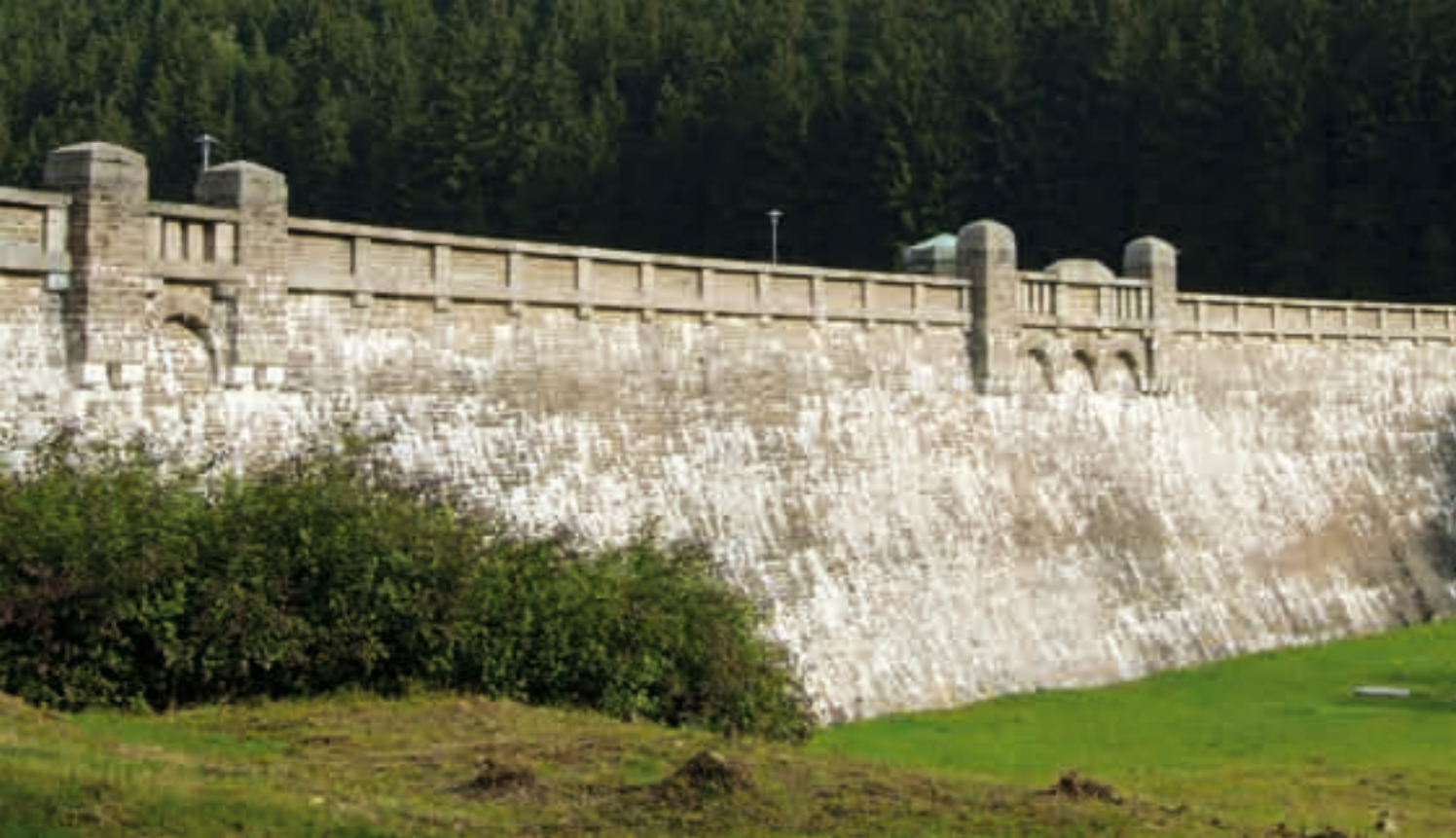
Neunzehnhain I dam
