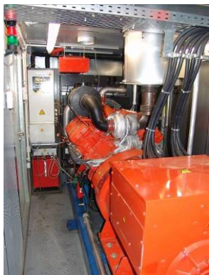
Abbildung 13 Pflanzenöl BHKW in einem sächsischen Gartenbaubetrieb ( 340 \text{ kW}_{\text{elektr.}}/350 \text{ kW}_{\text{therm.}} )
