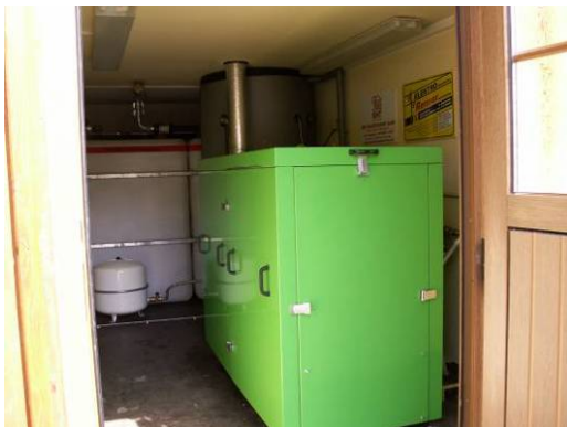
Abbildung 13 Pflanzenöl BHKW in einem sächsischen Gartenbaubetrieb ( 340 \text{ kW}_{\text{elektr.}}/350 \text{ kW}_{\text{therm.}} )
