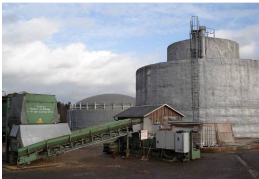
Abbildung 24 Biogasanlage Agrarfarm 2000 GmbH mit Substrataufbereitung
