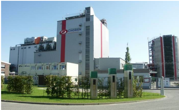
Abbildung 18 BtL-Anlage in Freiberg, in Betriebnahme 2008
