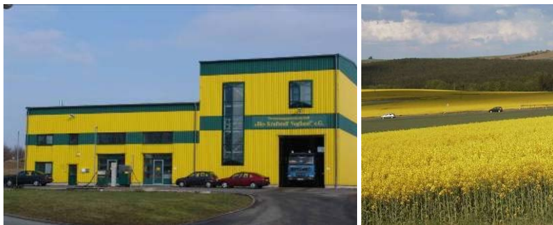
Abbildung 8 Biodieselanlage in Großfriesen
