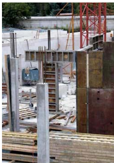
Abbildung 35 Schalungselemente auf einer Baustelle
