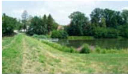
Hochwasserrückhaltebecken vor der Sofortmaßnahme
