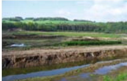
Entleerte Vorsperre während der Beräumung
