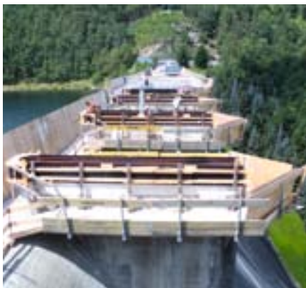
Sanierung der Mauerkrone
