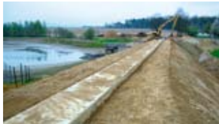
Dichtwand im fertig gestellten Dammbauwerk
