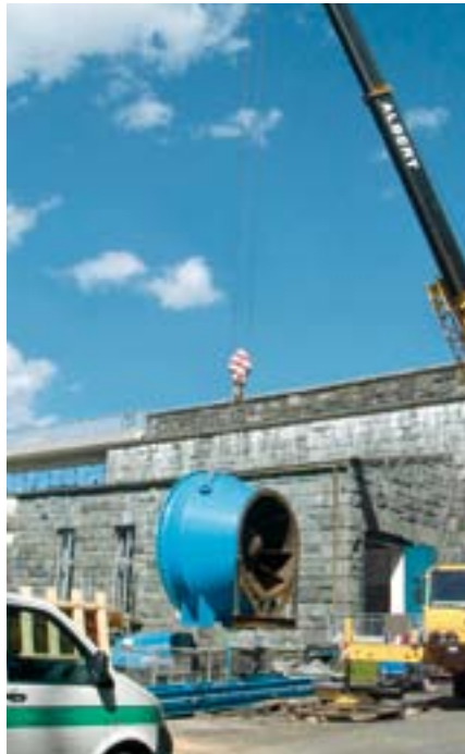
Vorbereitung der Montage der Ringkolbenventile
