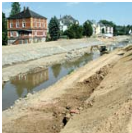
Deich oberhalb der Brücke Harthauer Straße während der Arbeiten
