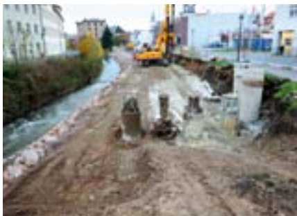
Arbeiten für die Hochwasserschutzwand, Ritterstraße
