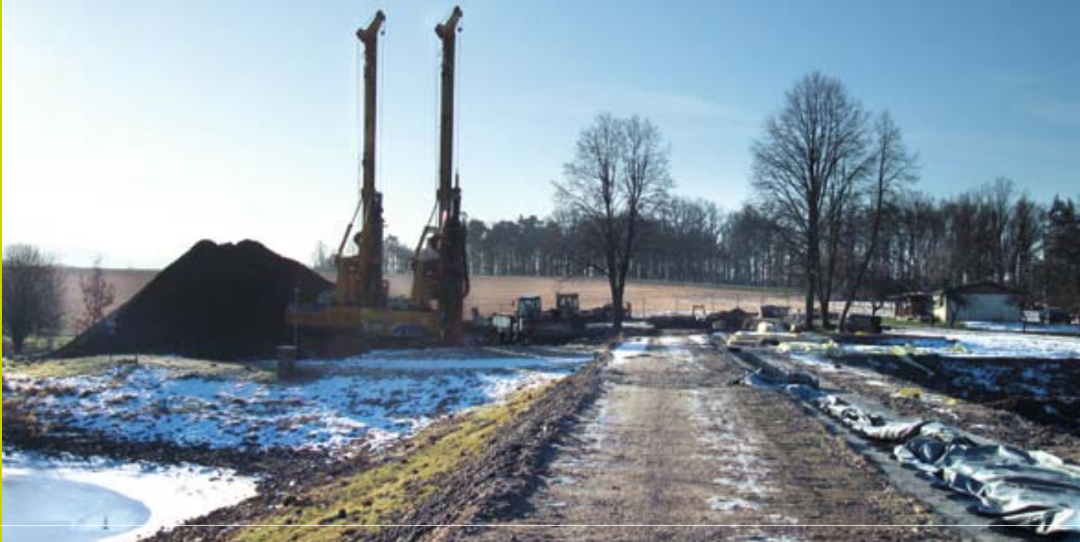
Winterarbeiten am Damm des Hochwasserrückhaltebeckens Göda
