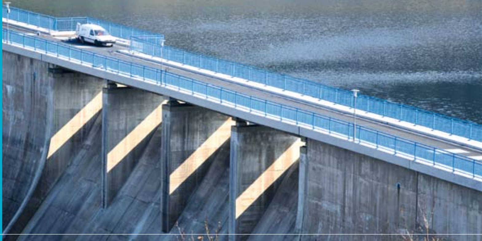
Mauerkrone der Talsperre Gottleuba nach Abschluss der Sanierung
