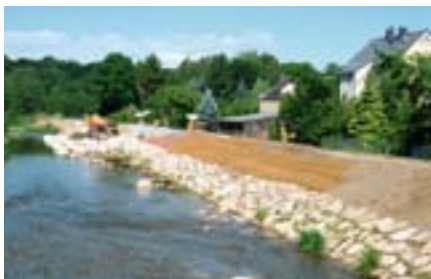
Deich unterhalb der Brücke nach Abschluss der Deichsanierung
