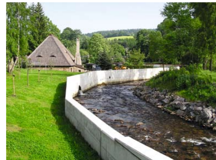
Hochwasserschutzmauer in Rothenthal
