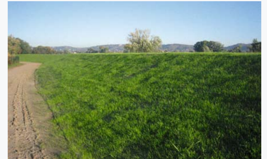
Sanierter Deich in Dresden-Gohlis
