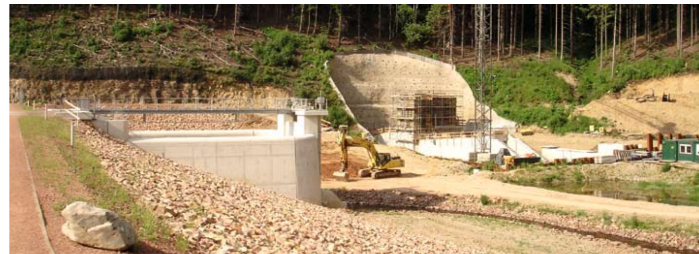
Neue Vorsperre und Einlaufbauwerk
