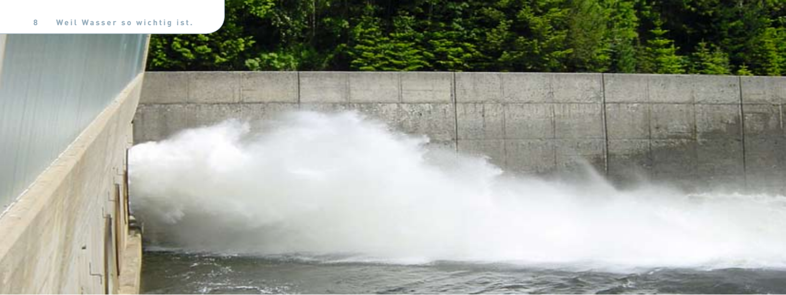
Grundablass Talsperre Eibenstock
