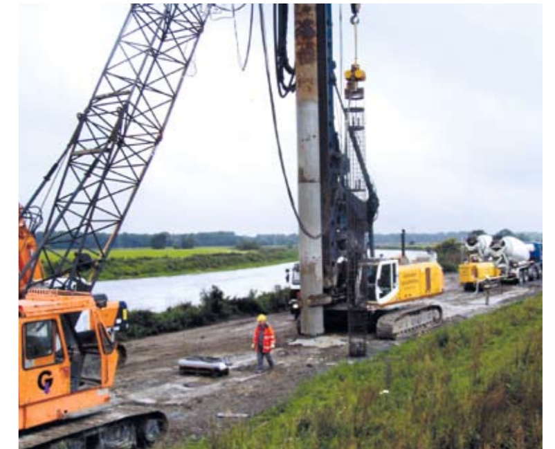
Bohrung am Hochwasserschutzdeich Kollau Canitz
