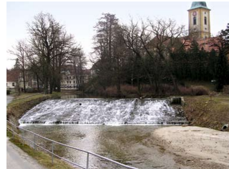
Kirchwehr in Bernstadt vor dem Rückbau
