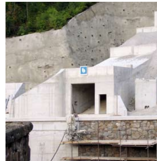
Auslaufbauwerk an der Hauptsperre
