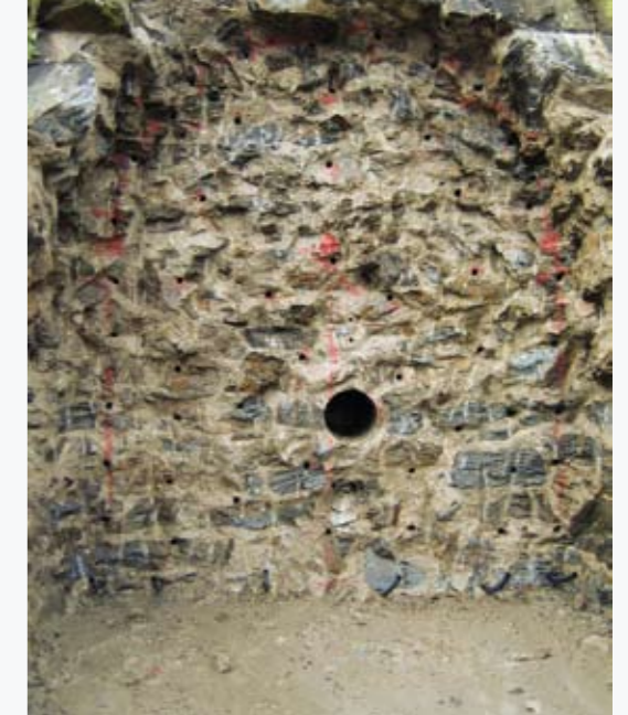
Sprengstelle für den neuen Kontrollgang
