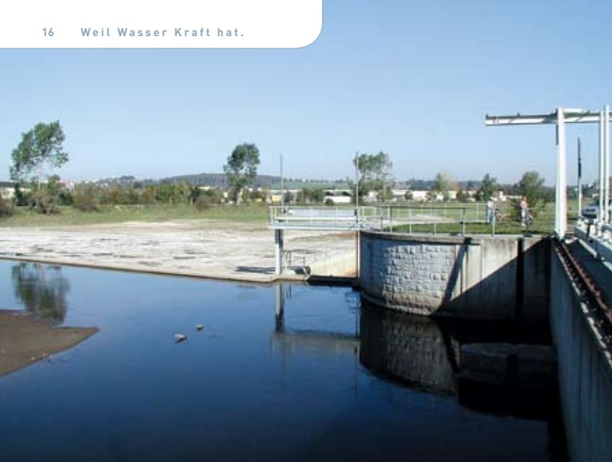
Flutrinnenwehr Glauchau nach dem Umbau
