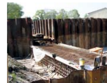
Bauabschnitt Schöpfwerk Jerisau
