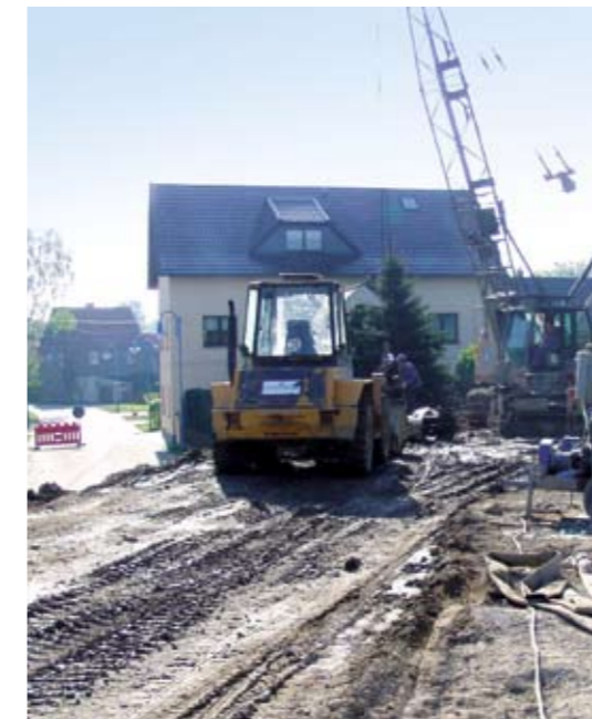
Baustelle am Hochwasserschutzdeich Kollau Canitz
