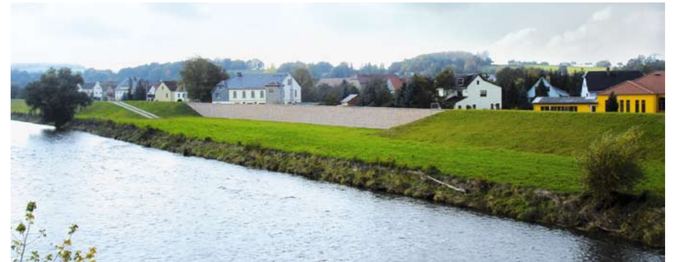
Hochwasserschutzmauer und Deiche in Sermuth
