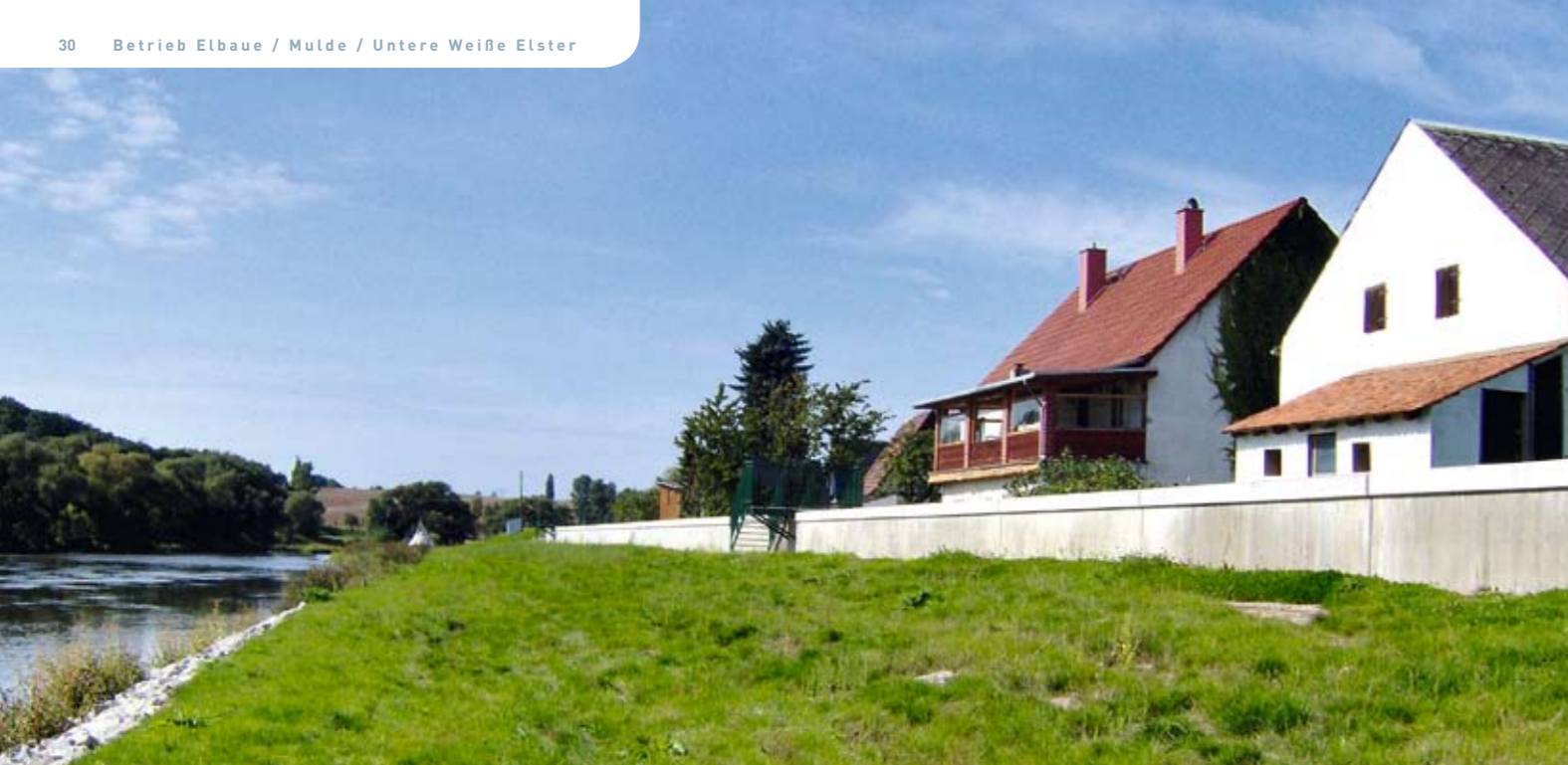
Hochwasserschutzmauer und Vorland in Erltn
