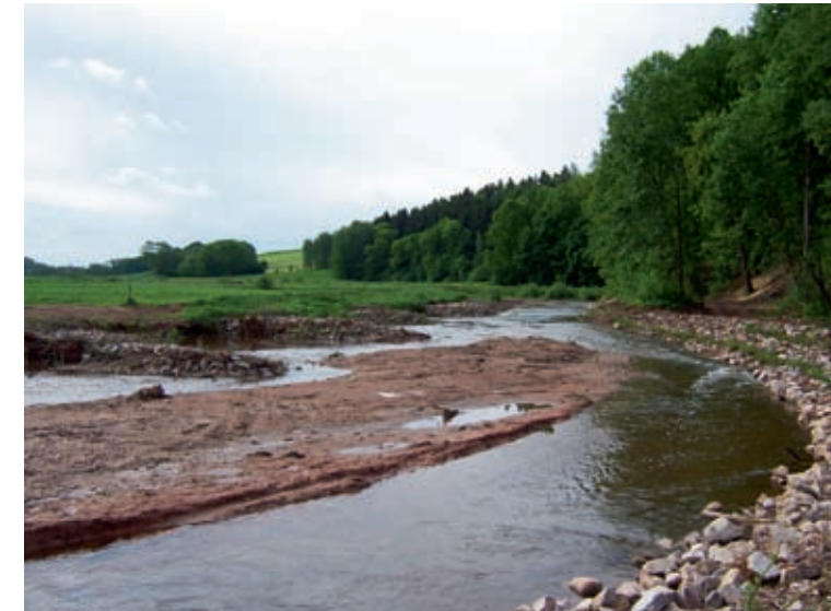
Böschungssicherung durch Buhnen
