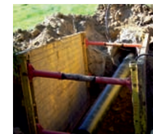
Sanierung der Hüttenteichleitung im Reliningverfahren mit PE-HD-Rohr DN 350
