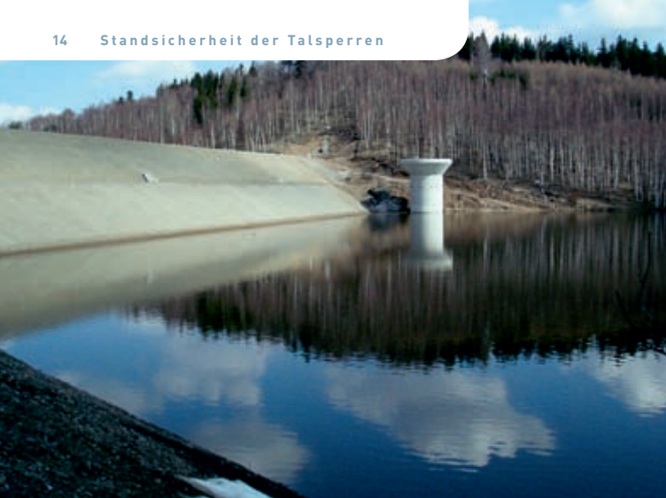
Ersteinstau Hochwasserrückhaltebecken Lauenstein
