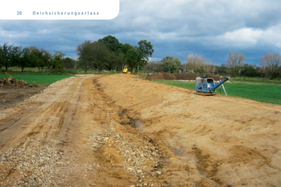
Deichbauarbeiten in Hirschstein, Ortsteil Boritz bei Riesa. Hier wurden 120 Meter Deich nach Deichsicherungserlass instand gesetzt.
