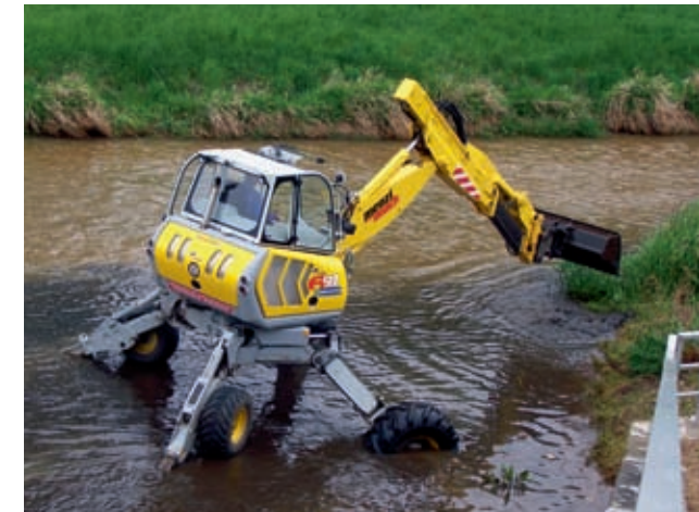
Schreitbagger im Einsatz
