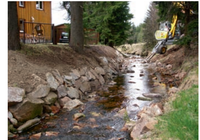
Böschungsbefestigung an der Roten Weißeritz in Schellerhau
