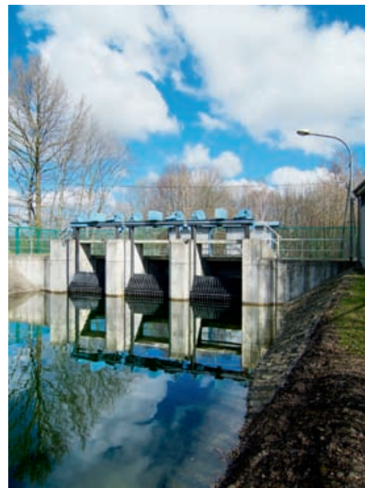
Ablauf Speicherbecken Witznitz
