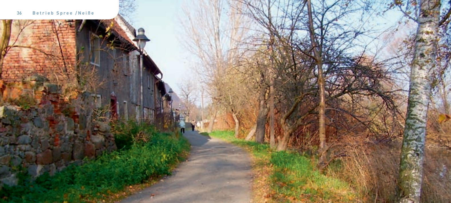
Häuser in Ostritz am Ufer der Lausitzer Neiße vor dem Bau der Hochwasserschutzwand
