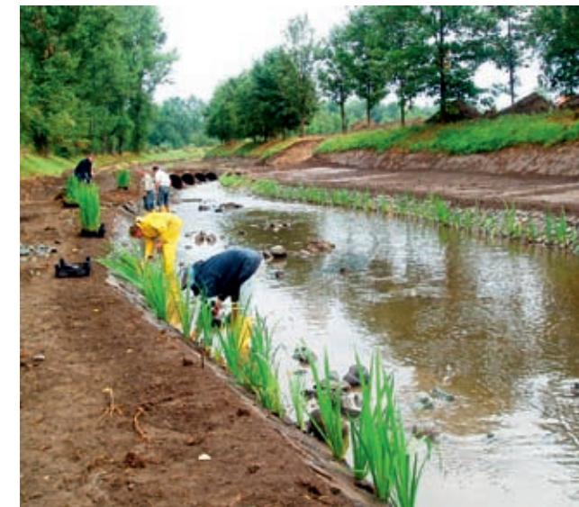
Mandau in Seiffenhensdorf: Anwendung ingenieurbioologischer Bauweisen im zweiten Bauabschnitt
