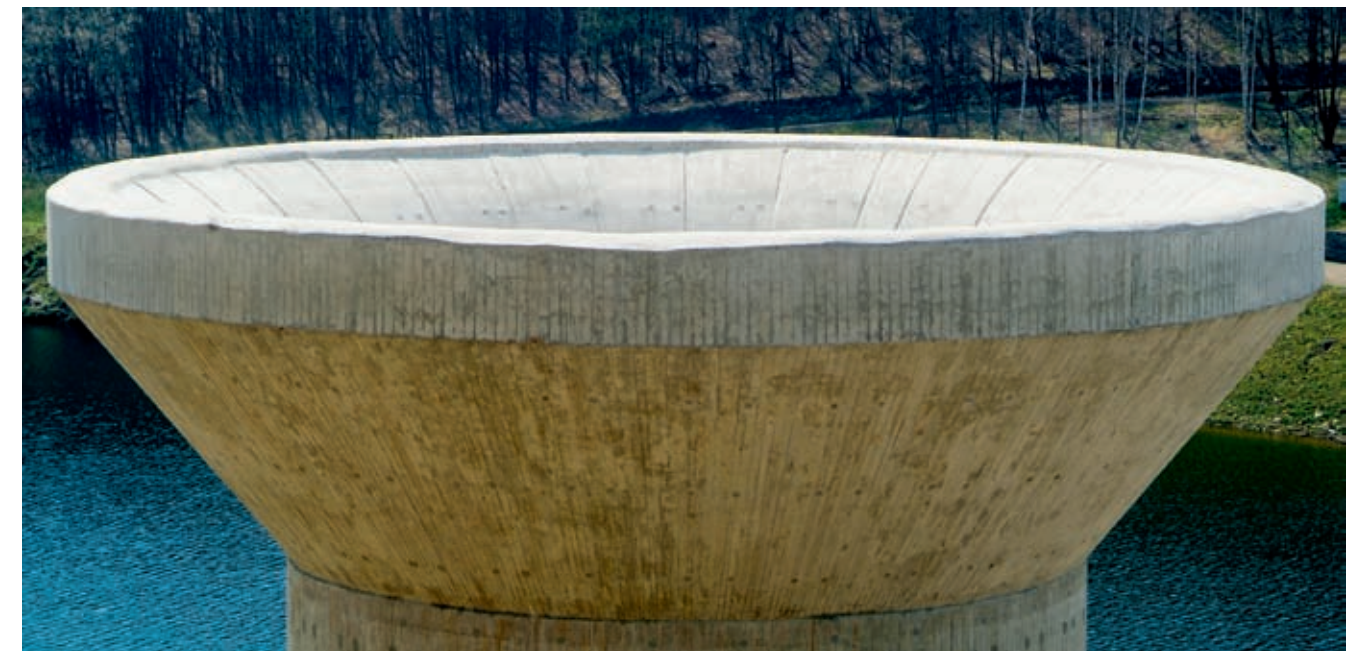
Überlauftrichter der Hochwasserentlastung
