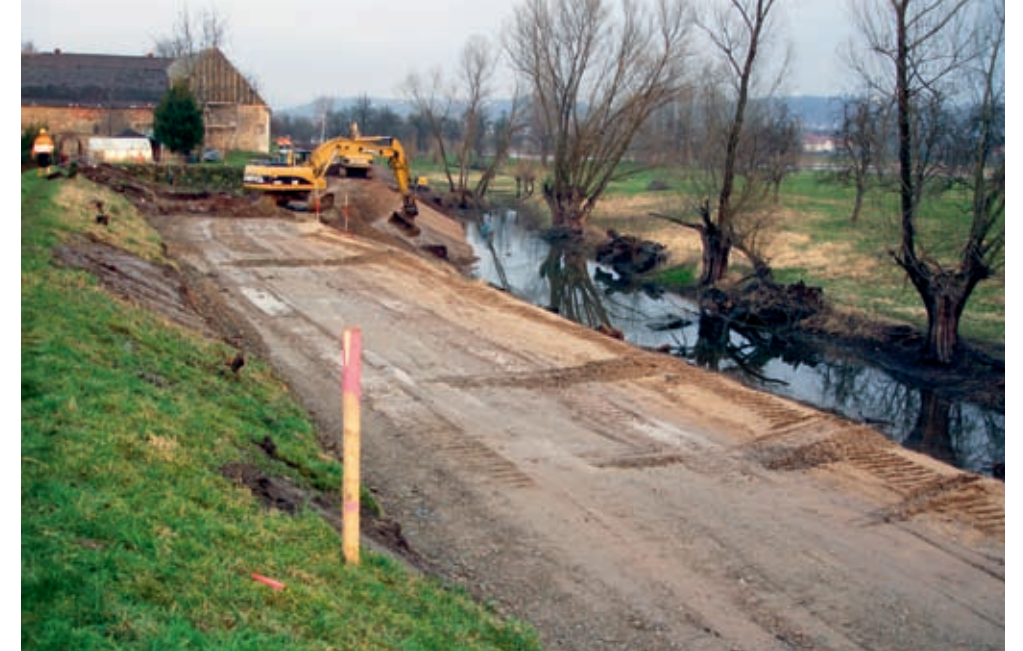
Bauarbeiten am Deich Dresden-Gohlis. Der Deich wurde auf Basis des Deichsicherungserlasses instand gesetzt.
