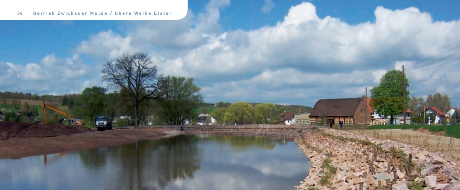
Sedimentationsfalle am Ende des naturbelassenen Gewässerabschnittes
