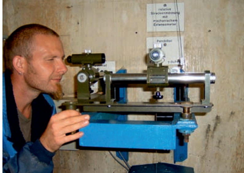
Pendellotmessung mittels Koordimeter in einer Gewichtsstaumauer
