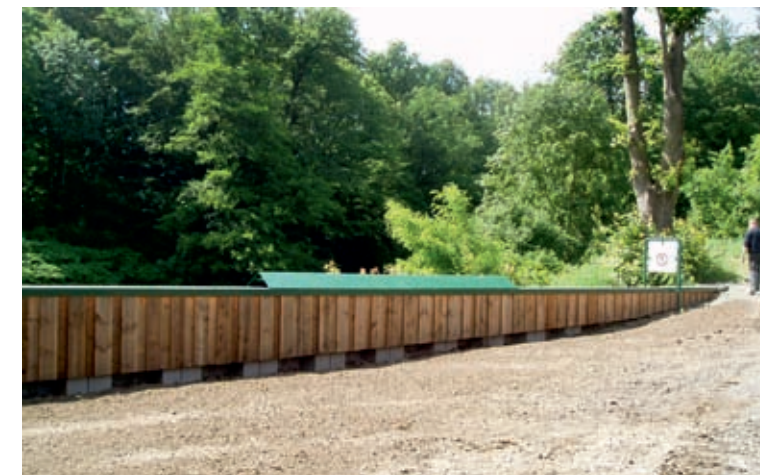
Hochwasserschutzwand in Ostritz
