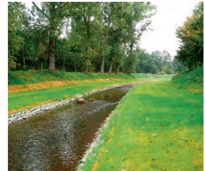
Zweiter Bauabschnitt der Mandau nach der Fertigstellung
