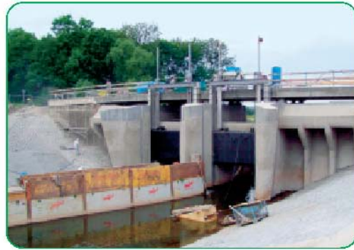
Das obere Wehr Regis während der Instandsetzung
