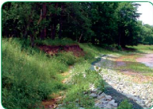
Das neugestaltete Ufer nach der Baumaßnahme
