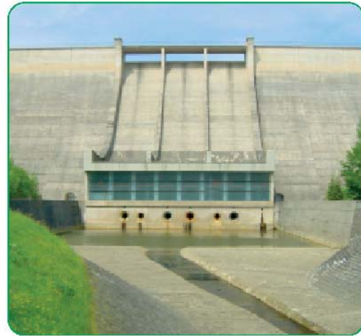
Hochwasserentlastungsanlage der Talsperre Eibenstock
