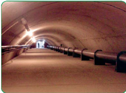
Fertiggestellter Grundablass-Stollen mit Lüftungsleitung
