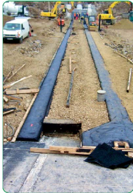
Herstellung von Asphaltkern und Längsschott im November 2004
