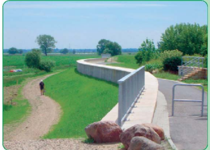
Hochwasserschutz-Mauer am Elbdeich, Blick stromauf
