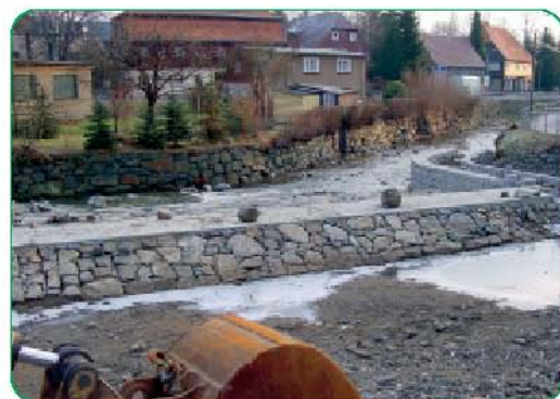
Oberes Mühlenwehr während der Bauphase
