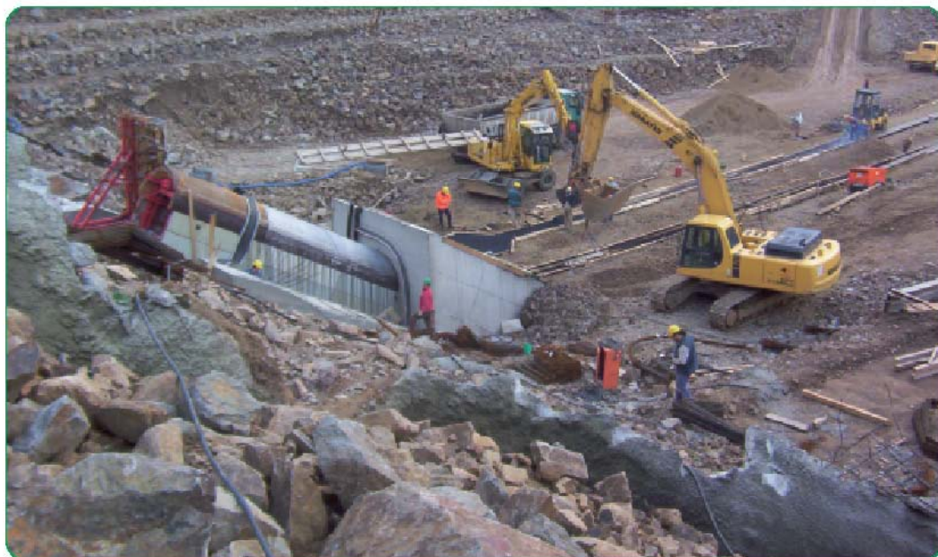
Bau des Kontrollgangs am Hochwasserrückhaltebecken Lauenstein im November 2004
