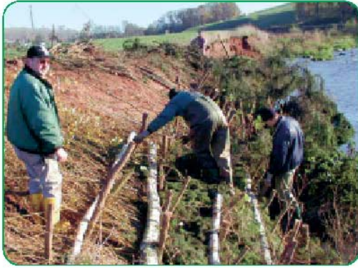
Ufersicherung am Lungwitzbach mit natürlichen Baustoffen
