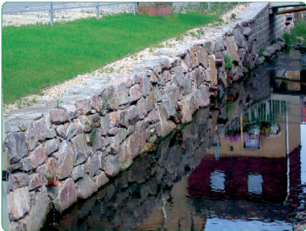
Neue Ufermauer in Mülsen aus großformatigen Blocksteinen
