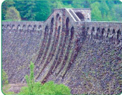
Kronenbauwerk der Talsperre Klingenberg
