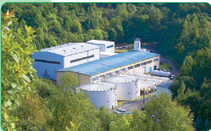
An das Wasserwerk Gottscheuba wird Rohwasser zur Trinkwasseraufbereitung geliefert
