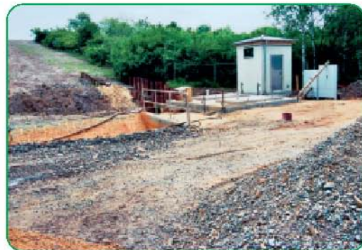
Das Schöpfwerk Regis wird umfassend modernisiert
