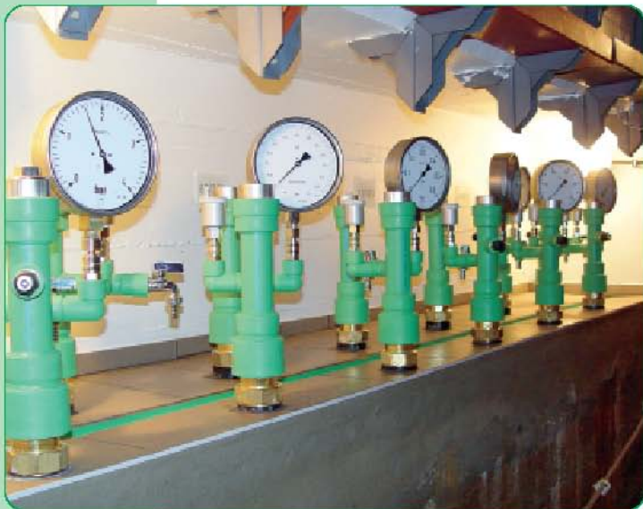
Köpfe der Sohlwasserdruckmessstellen an der Talsperre Gottleuba erneuert
