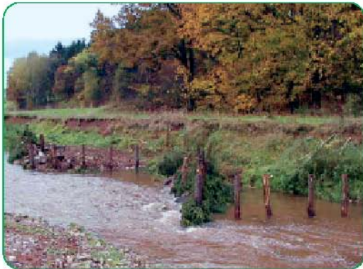
Buhnen verlegen den Stromstrich zur Gewässermitte
