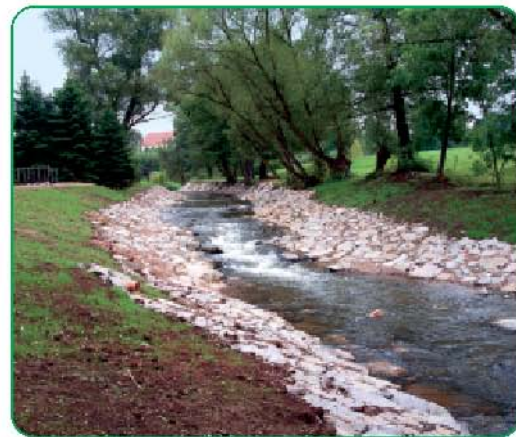
Die neu gestaltete Raue Rampe am Lungwitzbach verhindert Rückstau und ermöglicht Fischwanderung
