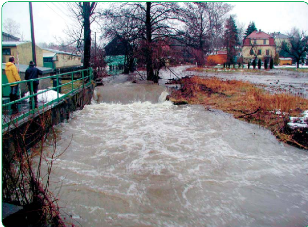
Das Wehr an der Polenz während des Hochwassers im Januar 2003
