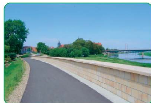
Hochwasserschutz-Mauer am Elbdeich, Blick stromab
