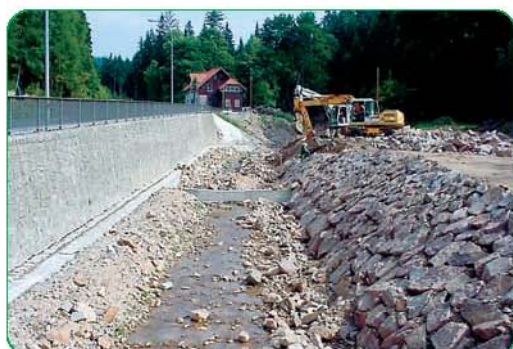
Nach Abschluss der Schadensbeseitigung ist der Gewässerabschnitt auf ein 100-jährliches Hochwasser ausgelegt
