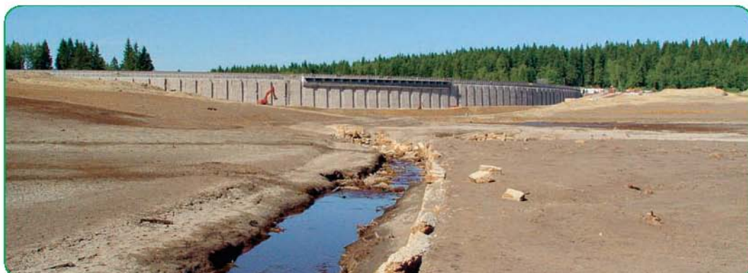
Für die Modernisierung wurde die Talsperre Muldenberg abgelassen
