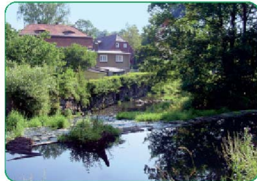
Oberes Mühlenwehr vor Baubeginn
