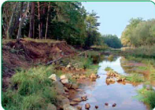
Vor Baubeginn starke Erosion am Ufer unterhalb des Wehres
