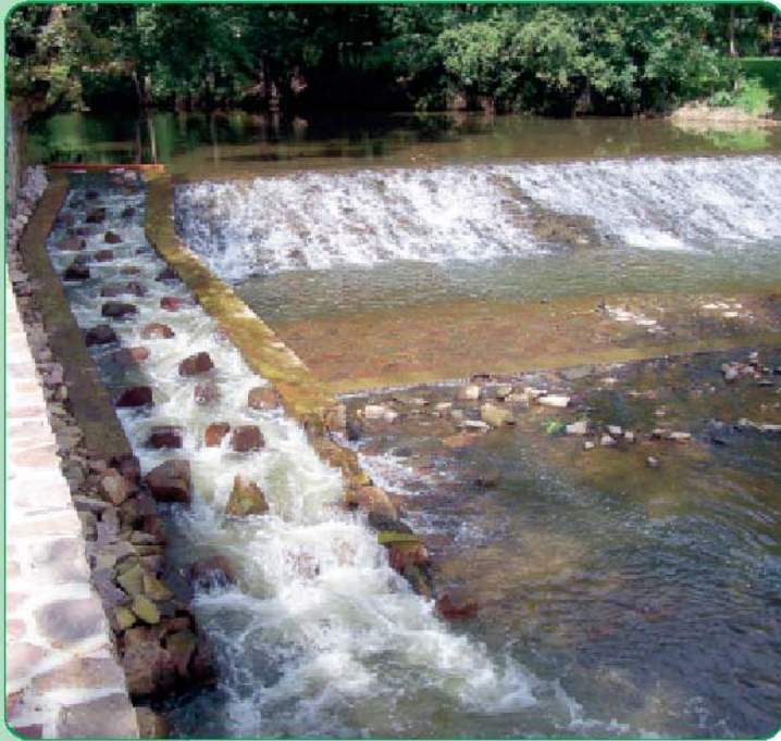
Saniertes Wehr in Chemnitz mit neuer Fischrampe
