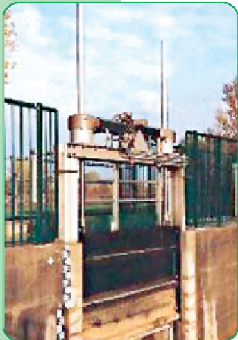
Die Wehranlage Weideroda wurde vollständig neu errichtet
