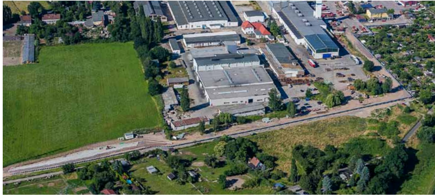
Hochwasserschutzanlage Naundorf aus der Luft
