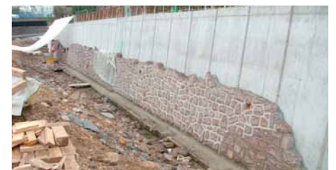
Bauarbeiten an der Ufermauer in der Hofmühlenstraße
