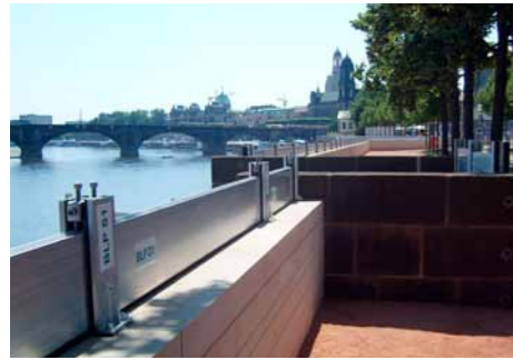
Hochwasserschutzmauer mit mobilen Elementen in der Altstadt
