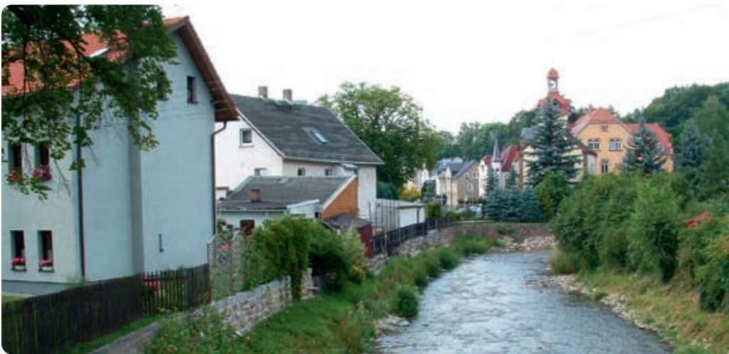
Zwönitz in der Ortslage Einsiedel
