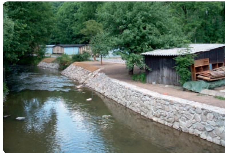
Bereits umgesetzte Hochwasserschadensbeseitigung in Erfenschlag
