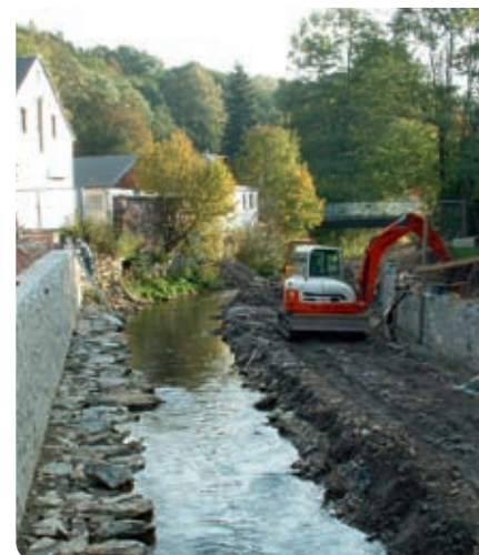
Hochwasserschadensbeseitigung an der Zwönitz
