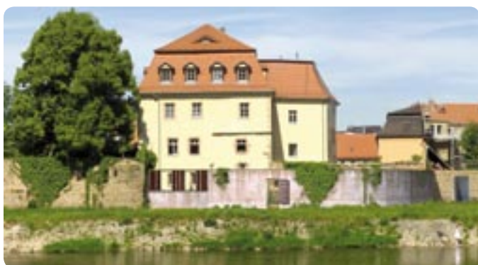
Neue Mauer um das Muldegärtchen
