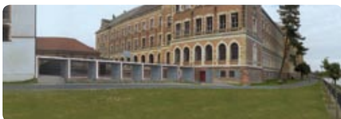
Hochwasserschutzwand mit großen Öffnungen auf dem Schulgelände
