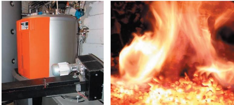
**Abbildung 2:** Kessel Guntamatic Powercorn 30 (links), Strohpelletfeuer (rechts)
