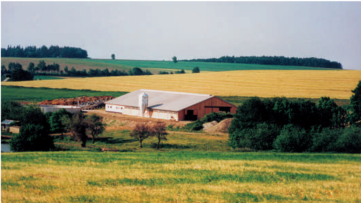
Abbildung 6: Kuhstallneubau in Oberdorf bei Stollberg
