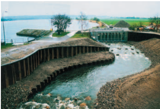
Abb. 9: Raugerinne-Beckenpass am Wehr Rathmannsdorf (Lachsbach, Sachsen)
