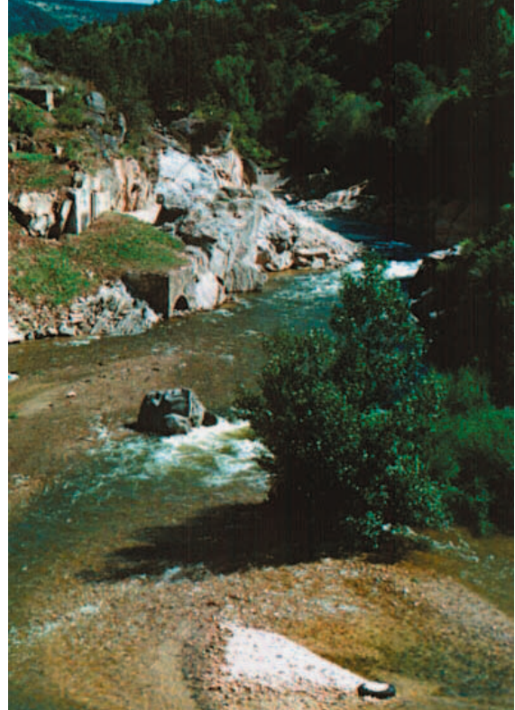
Abb. 12: Um die Laichplätze des Lachses im Oberlauf des Allier (Haute-Allier, Loireeinzugsgebiet, Frankreich) wieder für aufsteigende Laichfische zugänglich zu machen, wurde in einer spektakulären Aktion der Staudamm mit dem Wasserkraftwerk vom ehemaligen Betreiber EDF (Electricité de France) gesprengt (Fotos: European Rivers Network).
