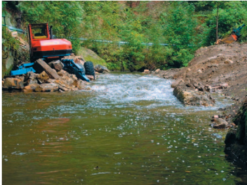
Abb. 13: Rückbau des Wehres Porschdorf in der Sebnitz (Sachsen)
