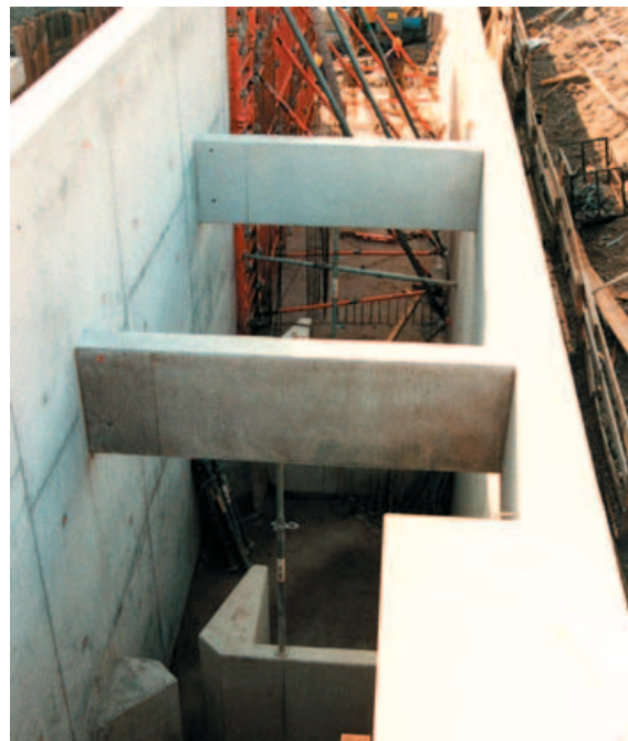
Abb. 10: Fischaufstiegsanlage an der Staustufe Iffezheim am Rhein. In der Bauphase ist die Ausführung als Vertical-Slot-Pass gut zu erkennen.
