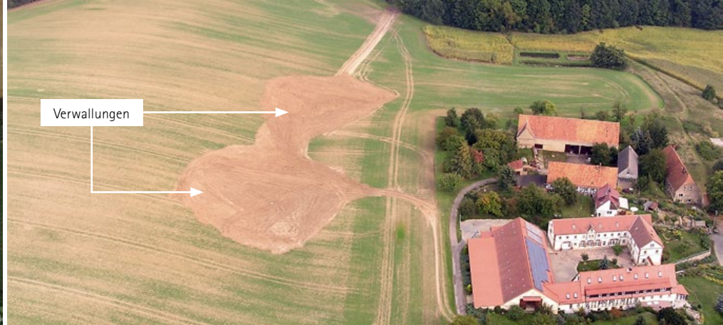
Verwallungen auf der Ackerfläche nach der Fertigstellung
