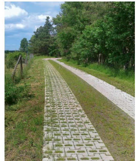
Spurweg aus Pflastersteinen
