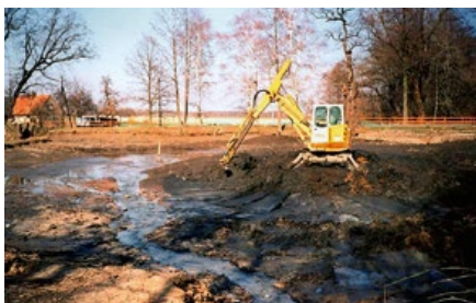
Mühlteich Günthersdorf während der Sanierung 1998
