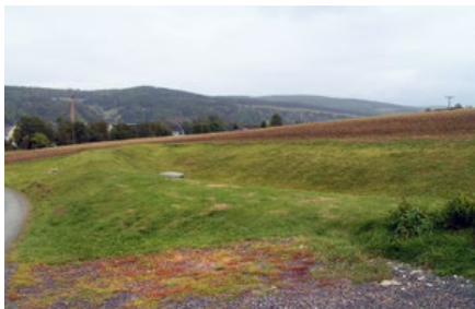
Flächensparende Variante – Regenrückhaltebecken in Olbernhau
