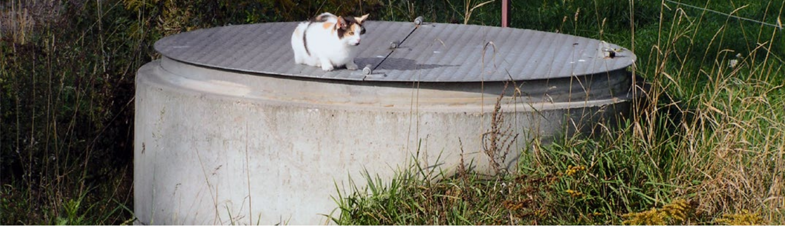
Flächensparende Maßnahme – Sickerschacht in Niederfrohna
