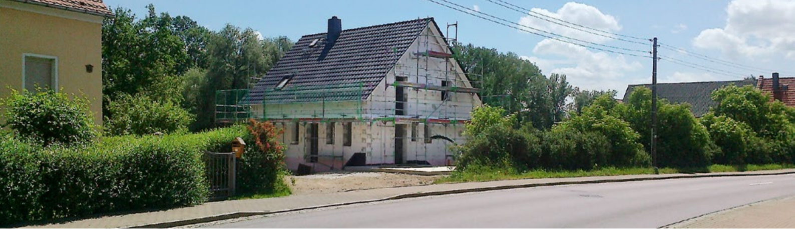
Neubau eines Wohnhauses im Innenbereich eines Dorfes
