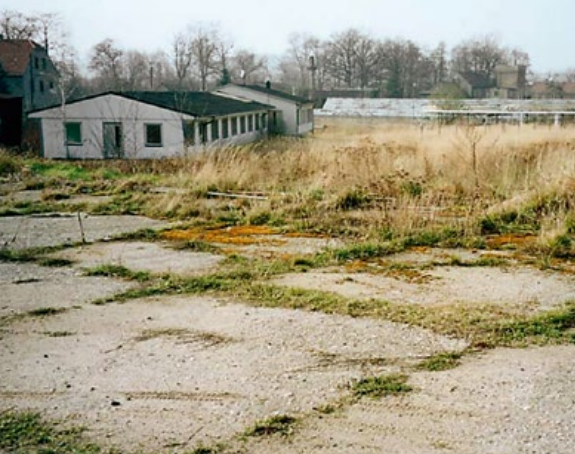
Brache: Lagerfläche in Nieschütz vor der Entsiegelung
