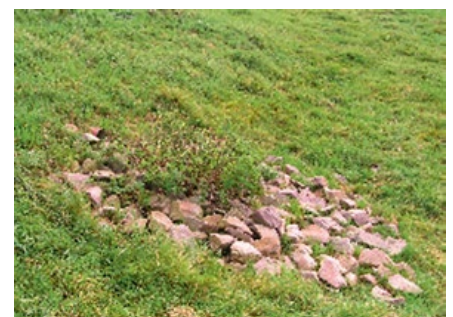
Auslauf oberer Damm
