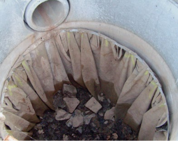
Blick in einen Versickerungsschacht
