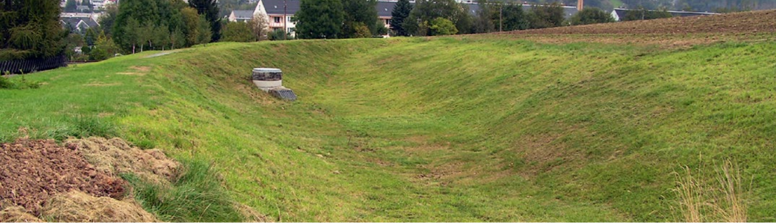
Regenrückhaltebecken »Am Bahnweg« – Blick Richtung Olbernhau
