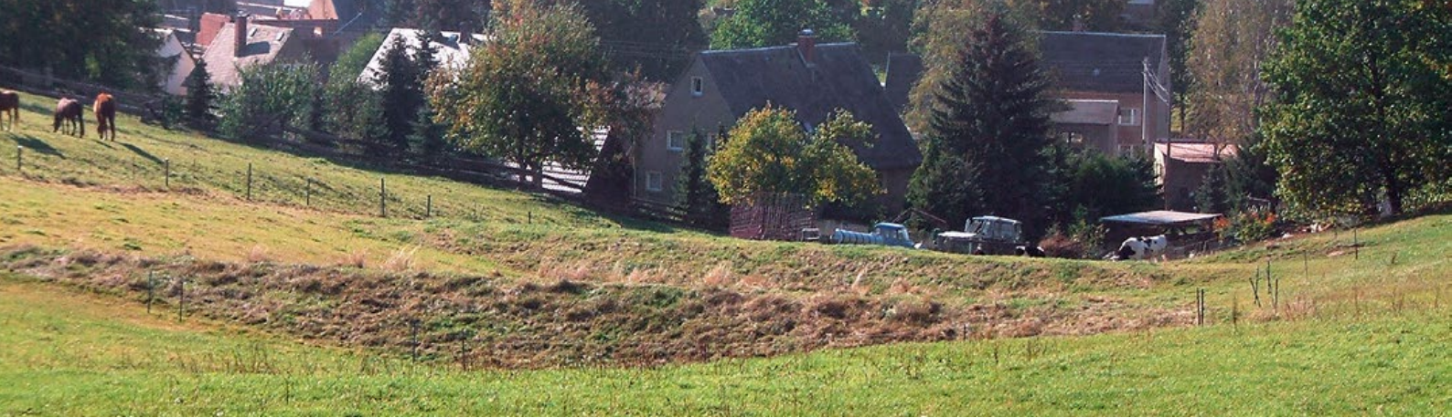
Rückhaltedämme Niederfrohna – Blick talwärts
