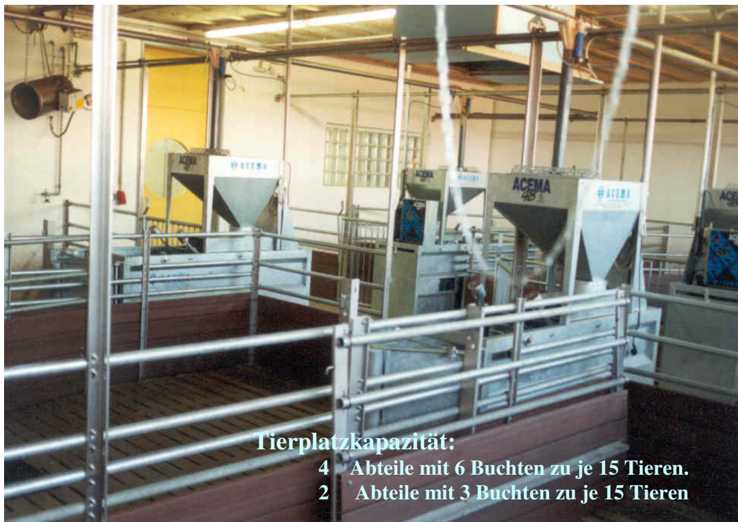
Abb. 14: Mastabteil im Prüfbereich
