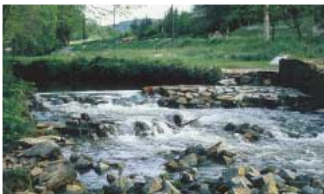
Abb. 147: Durch Umgestaltung in rauhe Sohlgleiten können Querbauwerke passierbar gemacht werden – ein Beispiel an der Pulsnitz.
