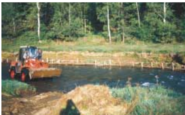
Abb. 161: Die Pfahlreihe mit hinterlegten Derbstangen am Ufer ist deutlich zu erkennen.
