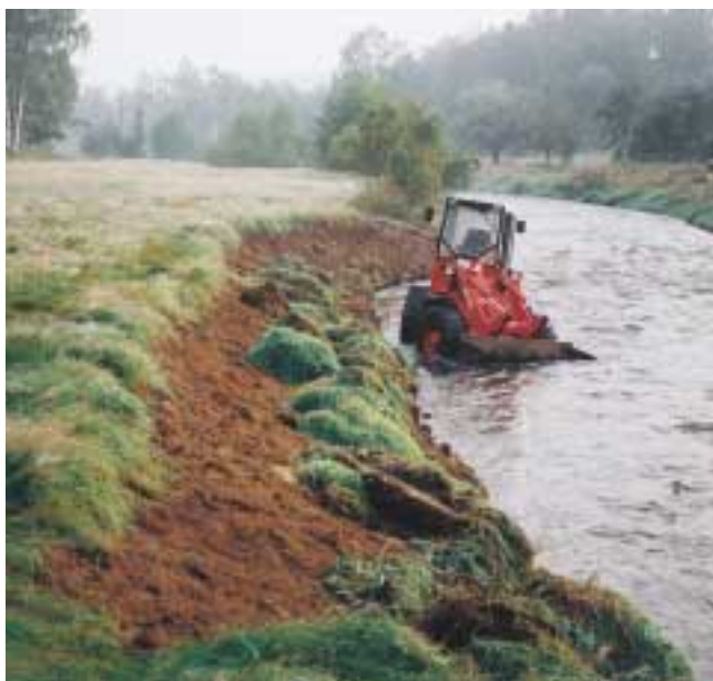
Abb. 162: Die Böschung wurde mit vorhandenem Bodenmaterial angefüllt und ein günstiges Böschungsverhältnis angelegt.
