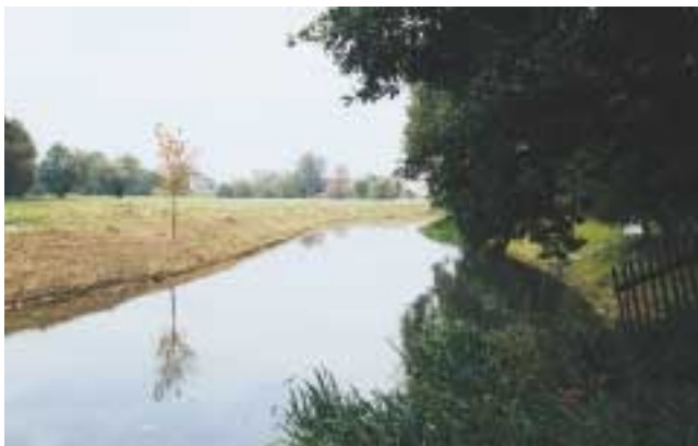
Abb. 126: Flussverlauf der Kleinen Spree bei Spree- wiese mit geregelter Wasserführung und Uferverbau unterhalb der Mittelwasser- linie mit Steinschüttung
