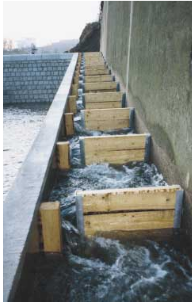
Abb. 159: Aus Platzmangel auf städtischem Gebiet wurde hier als technische Lösung zur Wiederherstellung der Durchgängigkeit ein Schlitzpass gewählt.
