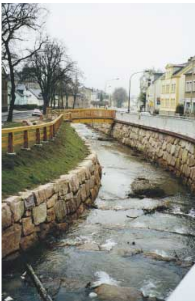
Abb. 170: Nach der Umgestaltung (1999) sieht dieser Abschnitt komplett verändert aus.
