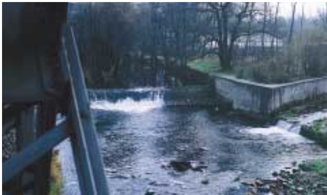
Abb. 95: Im Lauf der Flöha befinden sich 48 Querbauwerke.
