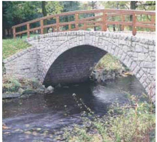
Abb. 153: Nach Möglichkeit sollten Gewässerquerungen immer durch Brücken und nicht durch Rohrdurchlässe erfolgen – ein Beispiel an der Großen Röder.
