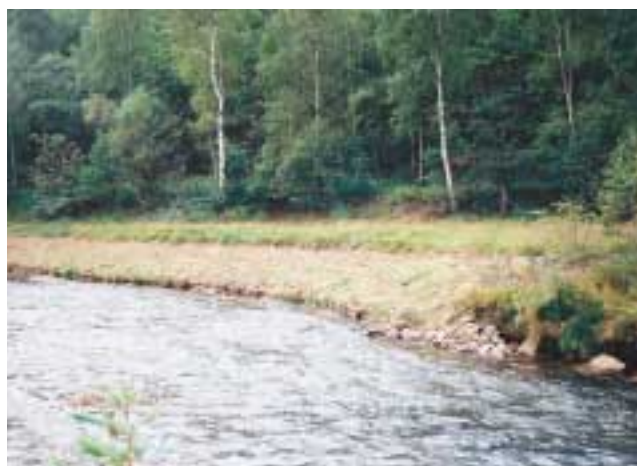
Abb. 163: Die Uferböschung nach der Baumaßnahme.
