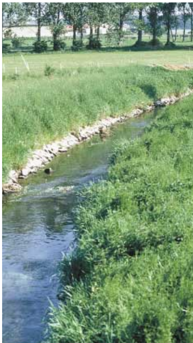
Abb. 150: Auch im ländlichen Raum sind die Gewässer oft verbaut und haben zu wenig Entwicklungsraum – ein Beispiel an der Schwarzen Elster.
