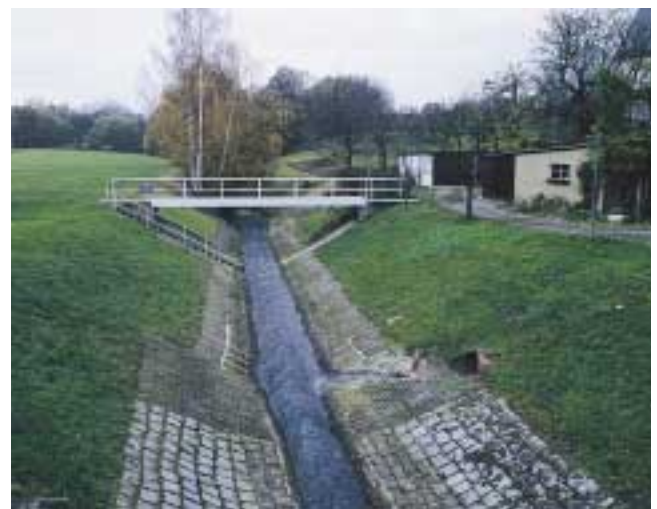
Abb. 66: Der massive Ausbau beeinträchtigt die Gewässerstruktur der Wyhra erheblich.
