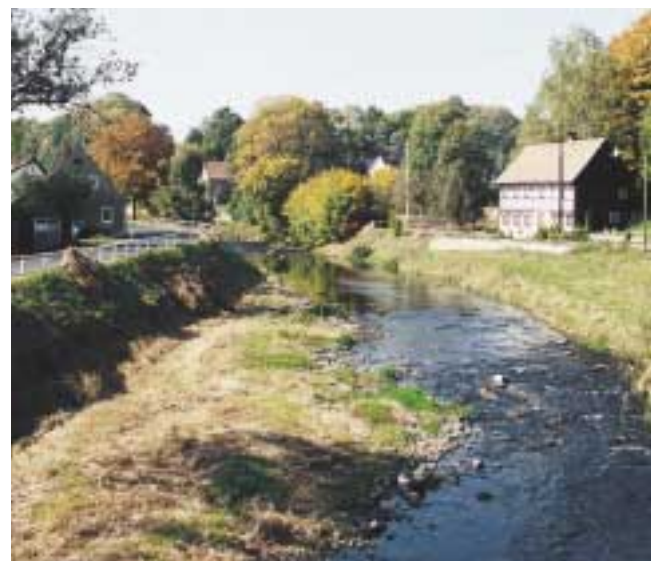
Abb. 134: Uferbau der Mandau bei Hainewalde
