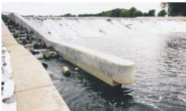
Abb. 148: An der Vereinigten Mulde am Wehr Kollau wurde ein Raugerinne-Beckenpass mit Bypassleitung zur Verbesserung der Lockströmung eingebaut.
