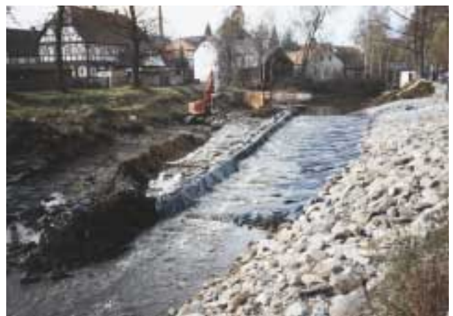
Abb. 160: 1997 wurde bei Großschönau eine Sohlengleite in die Mandau eingebaut.
