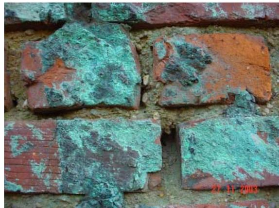
Abb. 3 und 4: An der Oberfläche sichtbare Kontaminationen: links Bodendetail im Bereich einer Halde; rechts Mauerwerk
