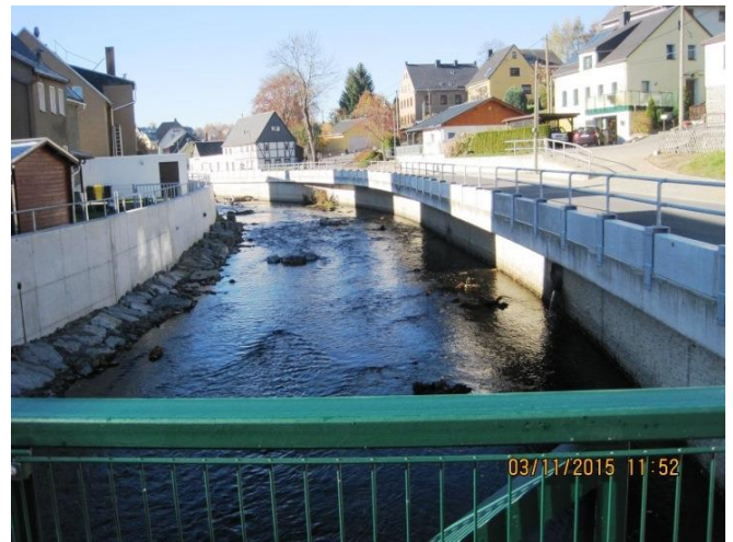
Abbildung 8: Gewässerabschnitte oberstrom (links) vor Baubeginn und nach Bauende (rechts); Schwergewichtswände (rechter Bildrand) mit HWS-Aufsatz und Stahlbetonwände mit vorgelagerter Böschung aus großformatigen Natursteinblöcken (linker Bildrand)
