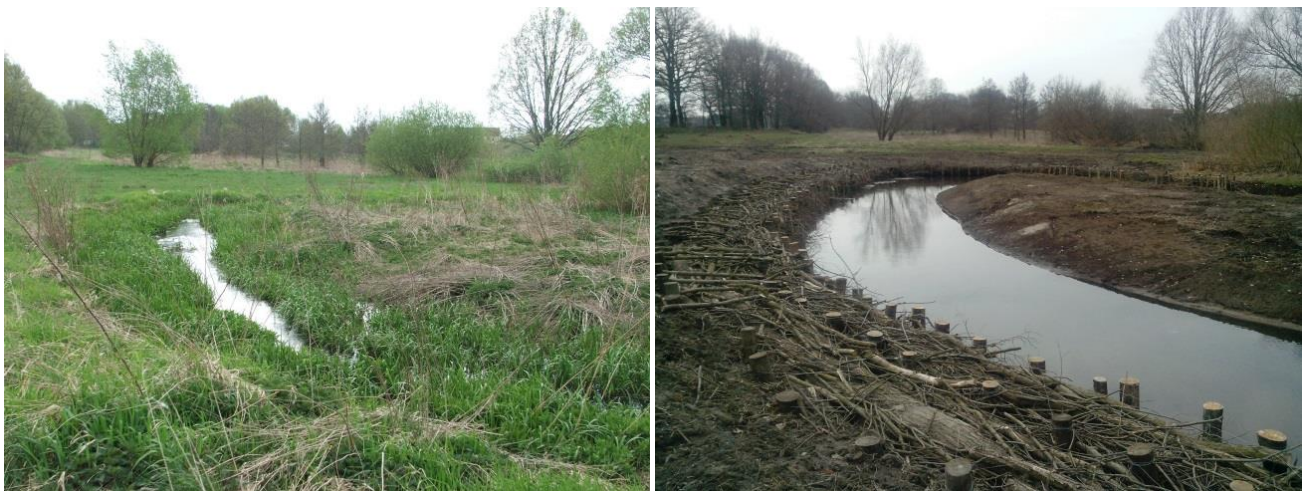
Abbildung 2: Abschnitt der Schwarzen Elster vor (links) und nach der Profilaufweitung durch Sedimententnahmen (rechts)
