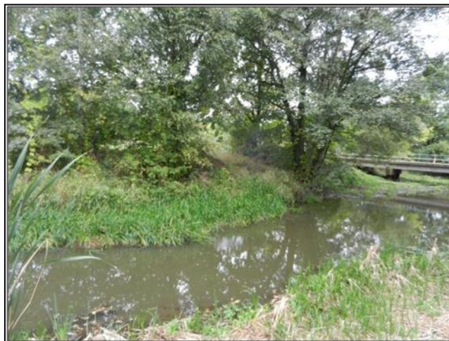
Abbildung 19: Schwarze Elster, SE_2, Grundräumung; in Fließrichtung 2012 vor Grundräumung (links); in Fließrichtung 2014 nach Grundräumung mit Profilaufweitung (rechts)
