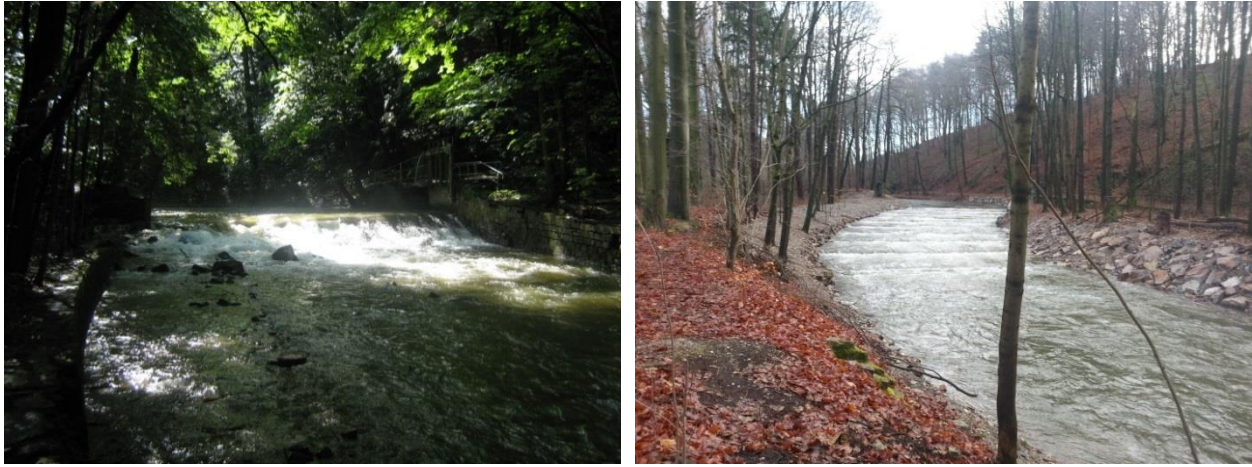
Abbildung 5: Wehr vor dem Umbau (links) und Zwönitz nach dem Umbau des Wehres in eine Riegelrampe (rechts)
