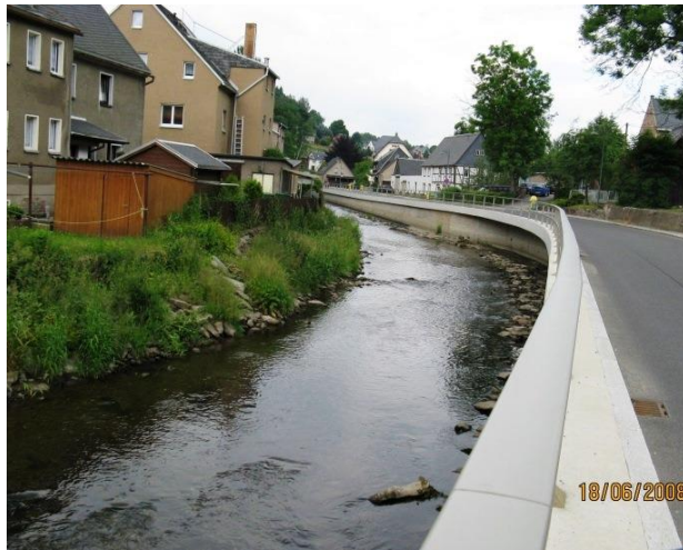
Abbildung 8: Gewässerabschnitte oberstrom (links) vor Baubeginn und nach Bauende (rechts); Schwergewichtswände (rechter Bildrand) mit HWS-Aufsatz und Stahlbetonwände mit vorgelagerter Böschung aus großformatigen Natursteinblöcken (linker Bildrand)
