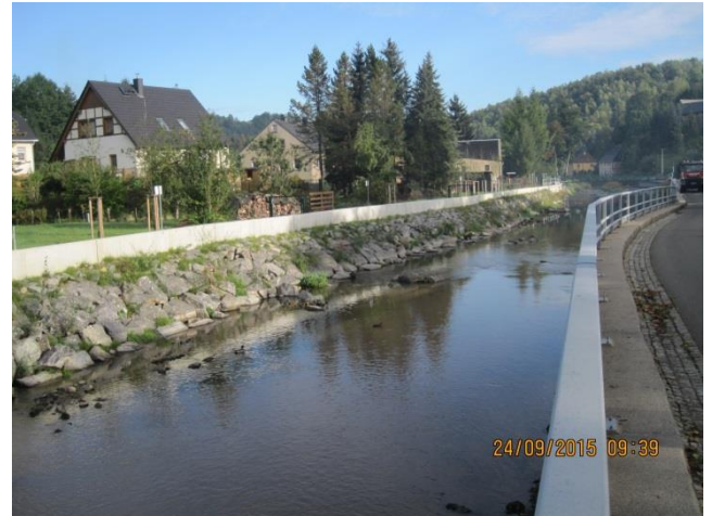
Abbildung 9: Gewässerabschnitte unterstrom (links) vor Baubeginn und nach Bauende (rechts); Winkelwand mit vorgesetzter Böschung (linker Bildrand)
