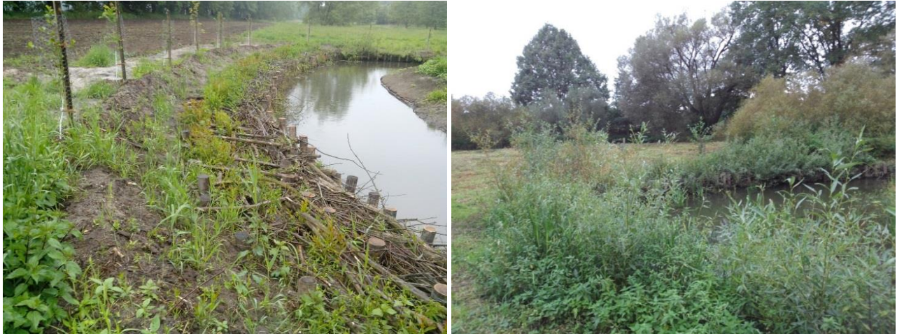
Abbildung 3: Ingenieurbiologische Bauweisen zur Ufersicherung Initialstadium (links); deutlicher Weidenaufwuchs (rechts)
