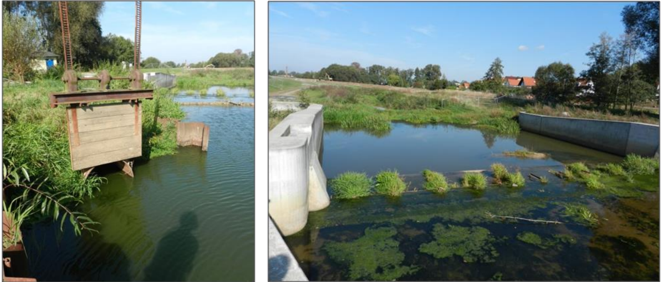
Abbildung 16: Abschlag der Schwarzen Elster mittels Rohr vor der Wehrsanierung (links); Beginn der Wudra am Wehr oberhalb von Wittichenau (rechts)
