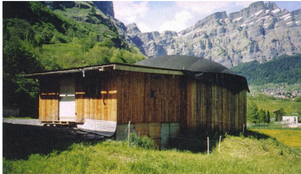
Bild 1 Biogasanlage Eugster Leukerbad
