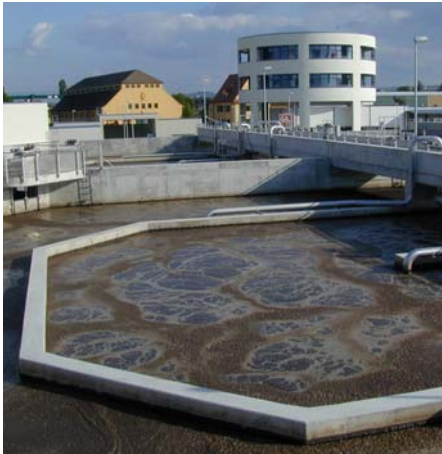
Titelbild: Kläranlage Dresden – Kaditz Neue biologische Abwasserbehandlung Foto: Stadtentwässerung Dresden
