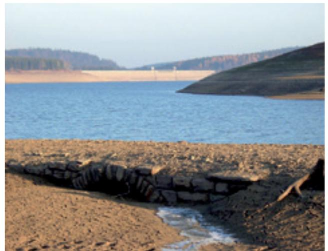
Abb. 6.4.6: Die TS Lehmühle bei deutlich abgesenktem Stauspiegel (508 m ü. NN). Ein Betriebsfall der Regelbewirtschaftung, d.h. im Rahmen der Rohwasserabgabe für Trinkwasser.
