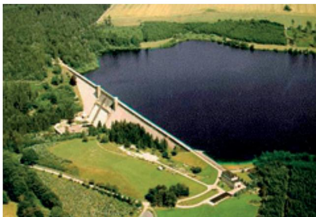
Abb. 6.4.2: Schwergewichtsstaumauer mit Dammschluss der Talsperre Lehnmühle
