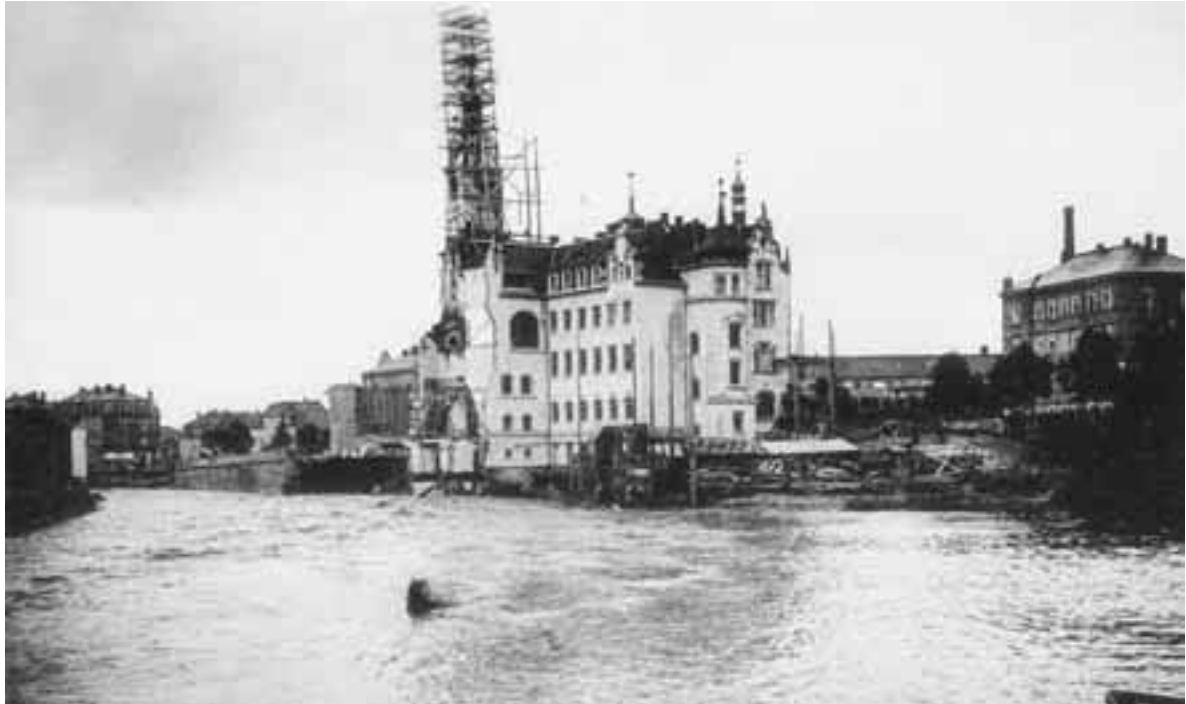
Abbildung 13: Nach dem Hochwasser 1897 zerstörter Flügel des Löbtauer Rathaus an der Weißeritz (Foto: LfUG)
