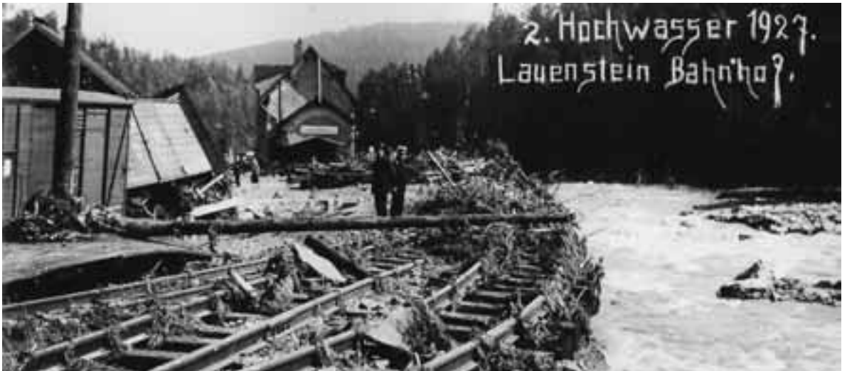
Abbildung 6: Bahnhof Lauenstein nach dem Hochwasser der Müglitz 1927 (Foto: aus POHL, 2003)
